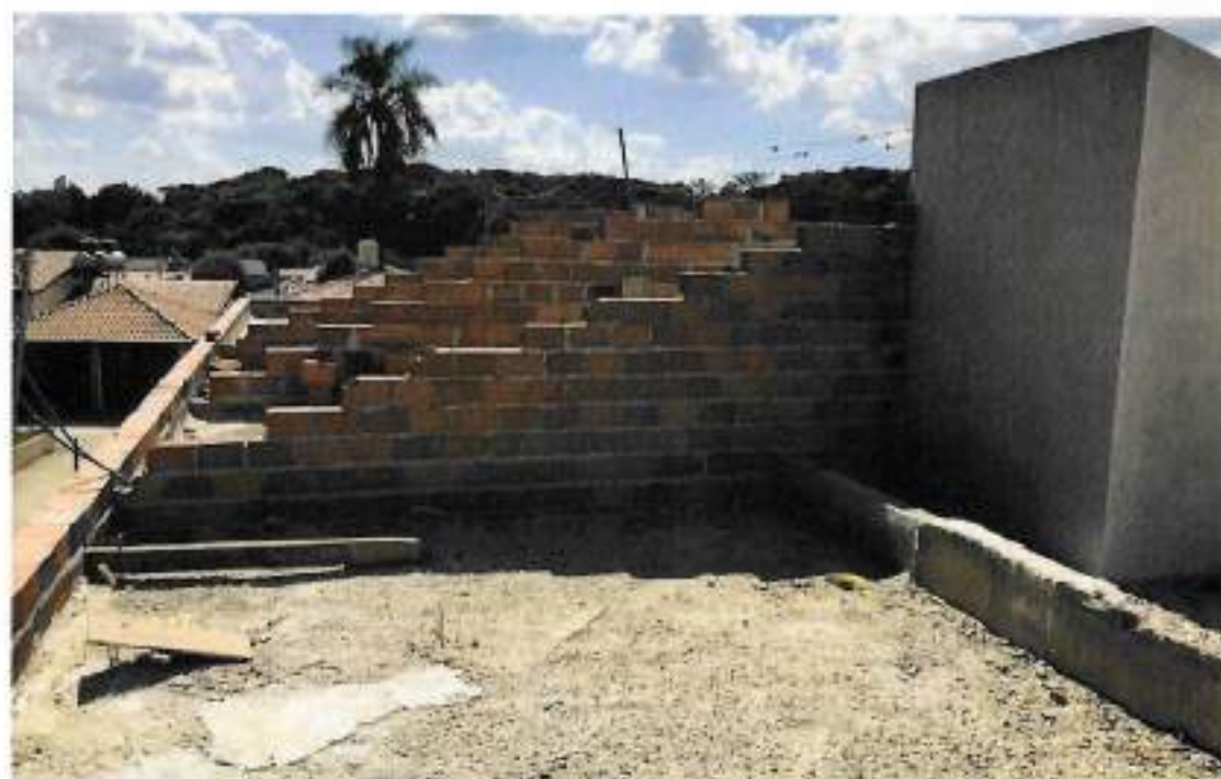
Foto 14 – Alvenaria de bloco furado da cobertura – data: 22/04/2022
