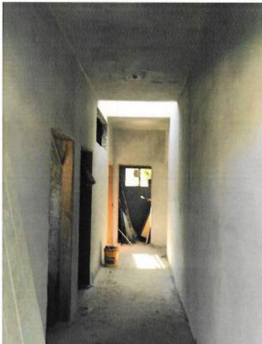
Foto 07 – Aplicação de argamassa em paredes internas– data: 10/06/2022
