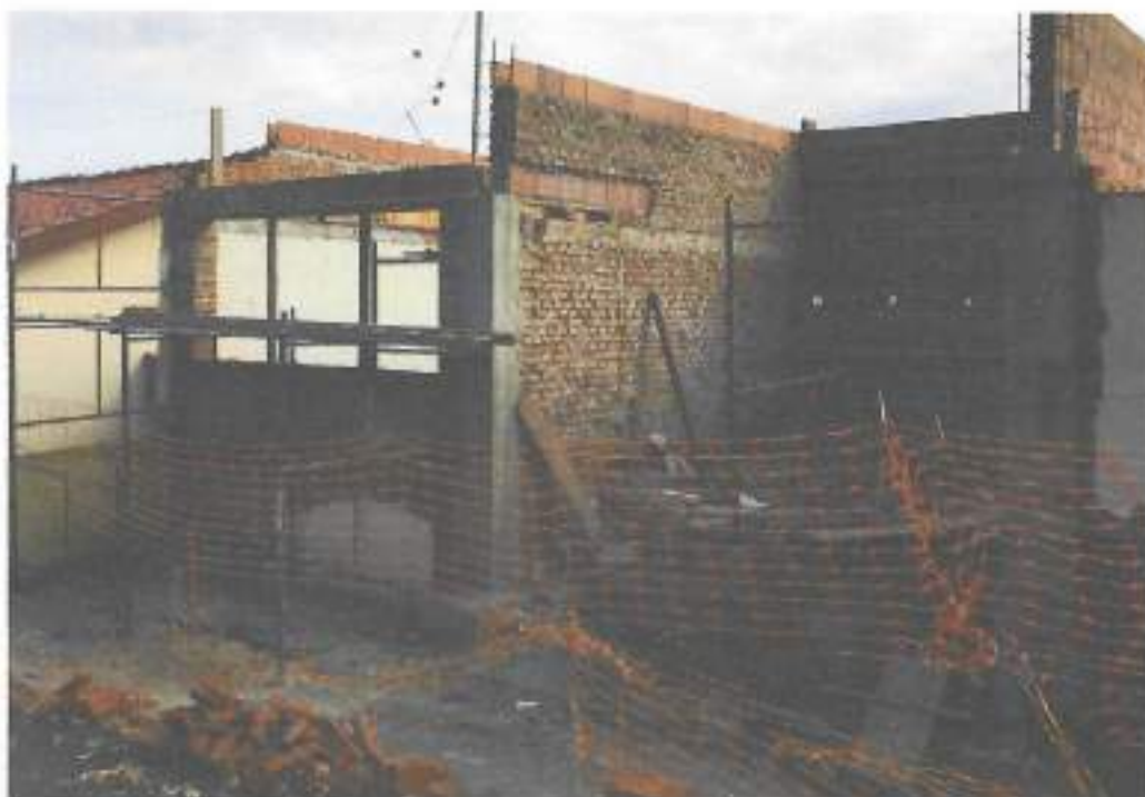
Foto 17 – Desmontagem de fôrma de pilares – data: 22/12/2021
