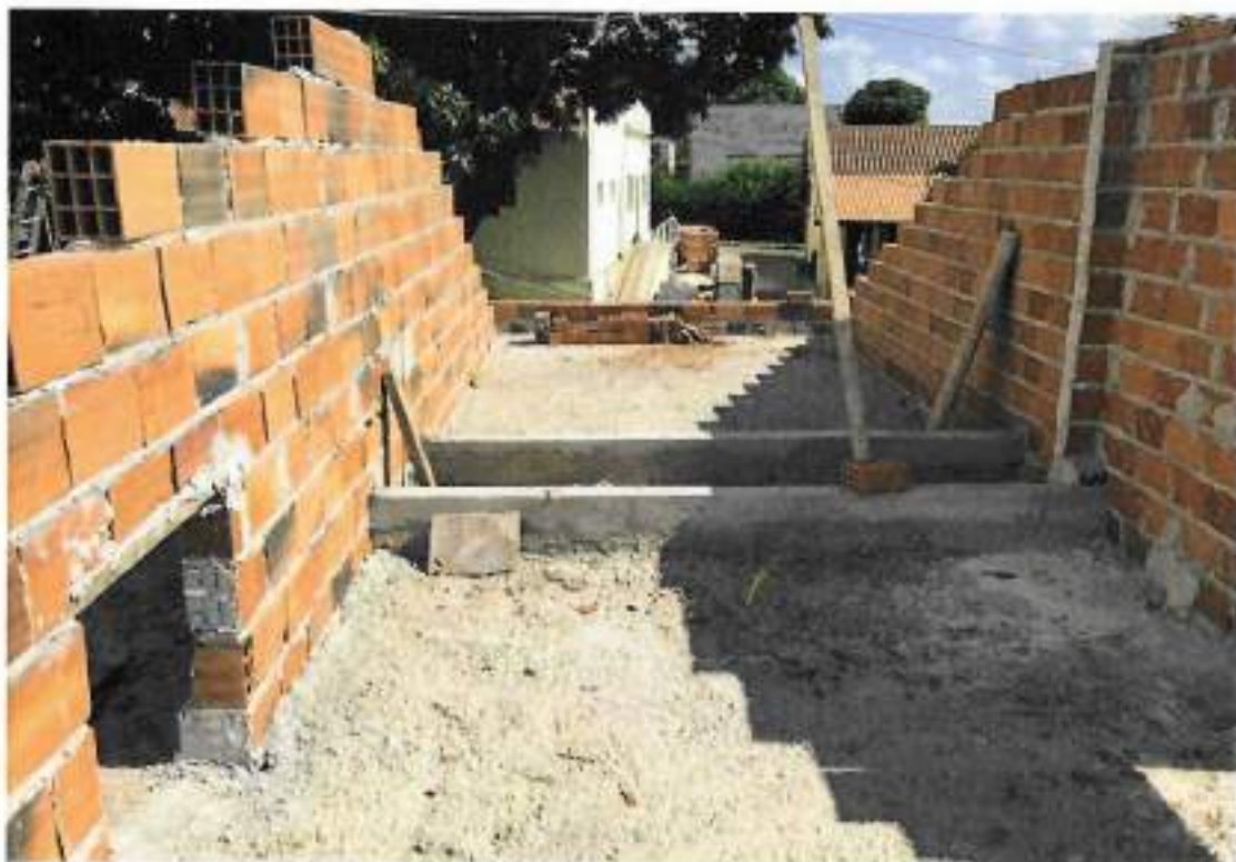
Foto 12 – Construção de vigas de sustentação caixa d'água – data: 22/04/2022
