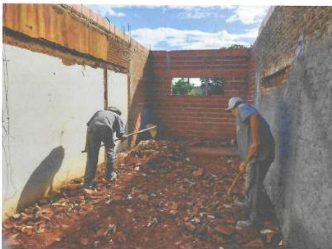
Foto 16 – Aterro do piso para cimentar – data: 25/01/2022
