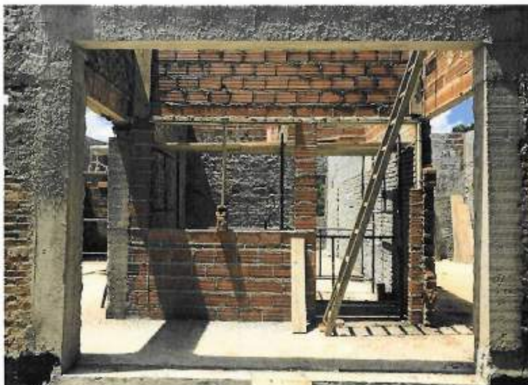
Foto 06 – Alvenaria de vedação – data: 17/02/2022
