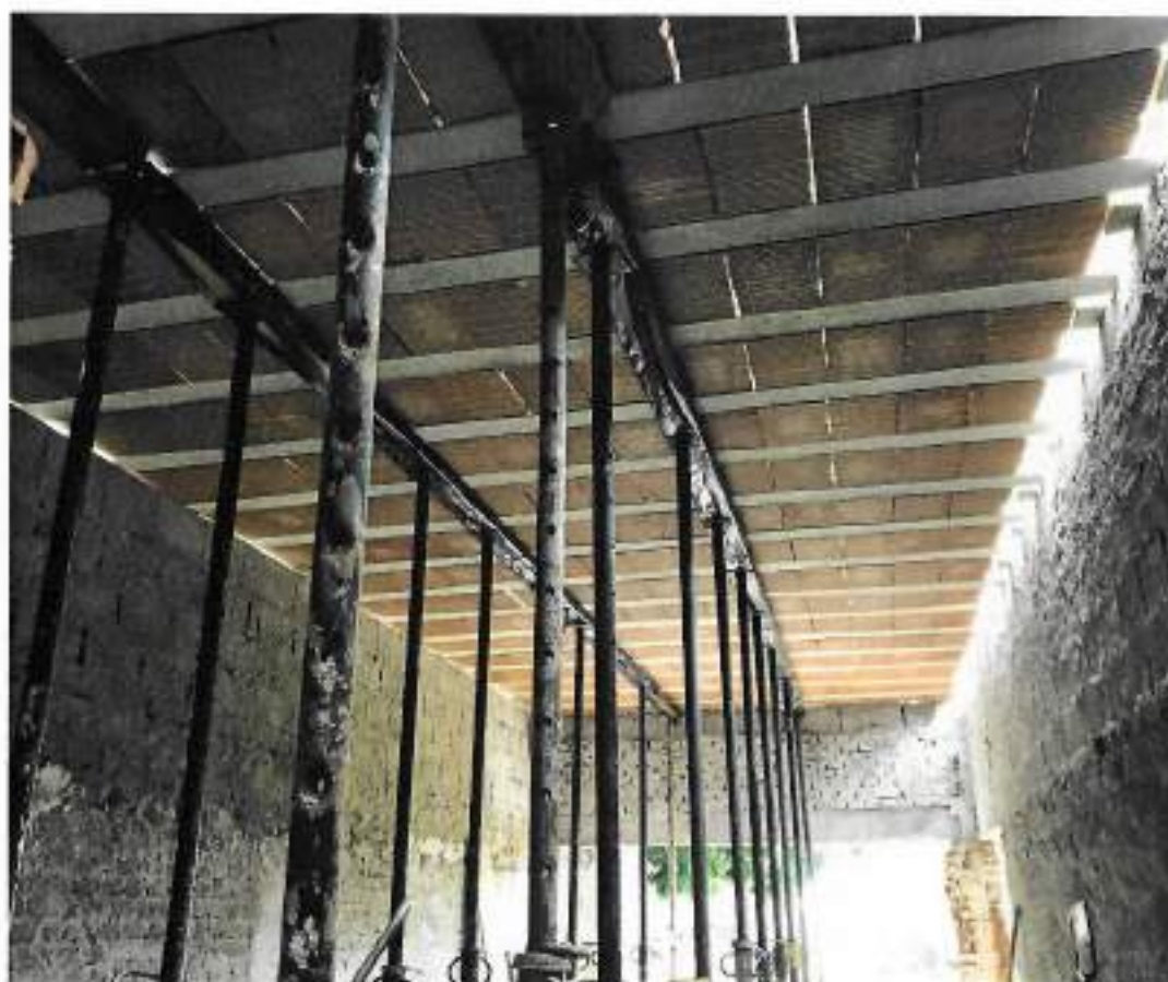
Foto 04 – Enchimento de laje com cerâmica – data: 04/03/2022
