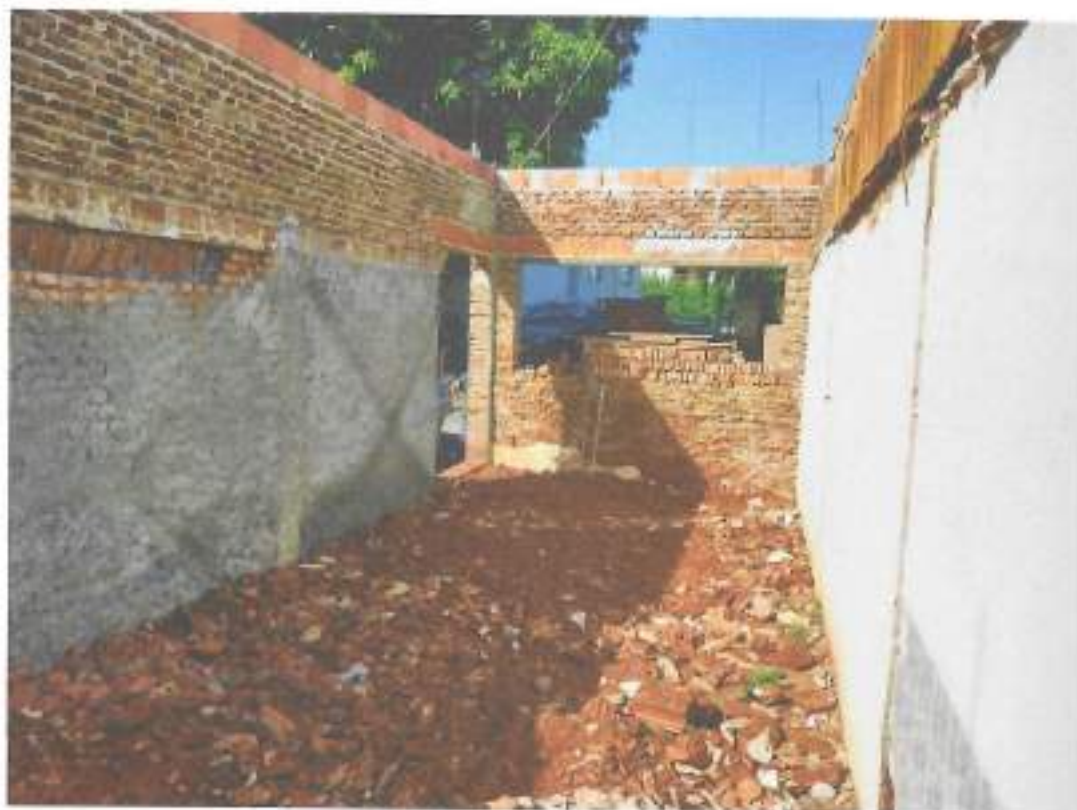
Foto 15 – Aterro do piso para cimentar – data: 25/01/2022
