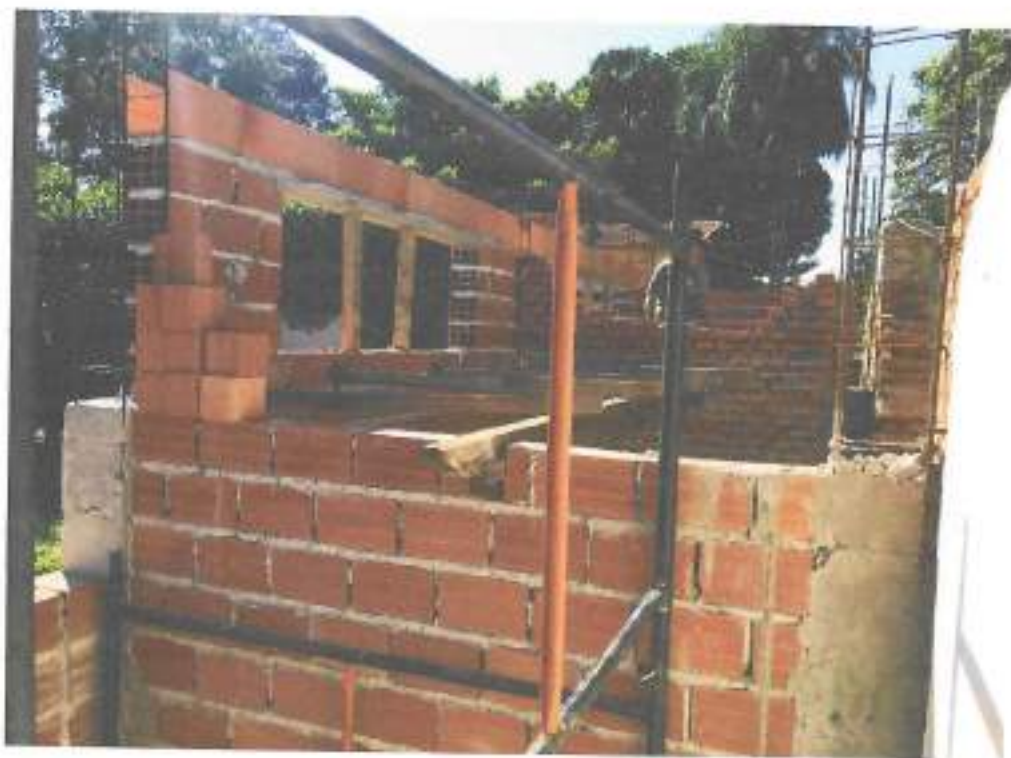
Foto 07 – Armação de pilar, concretagem e alvenaria de vedação – data: 12/11/2021
