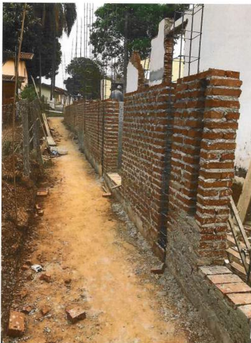
Foto 04 – Levantamento da parede externa de nivelamento – data: 03/09/2021
