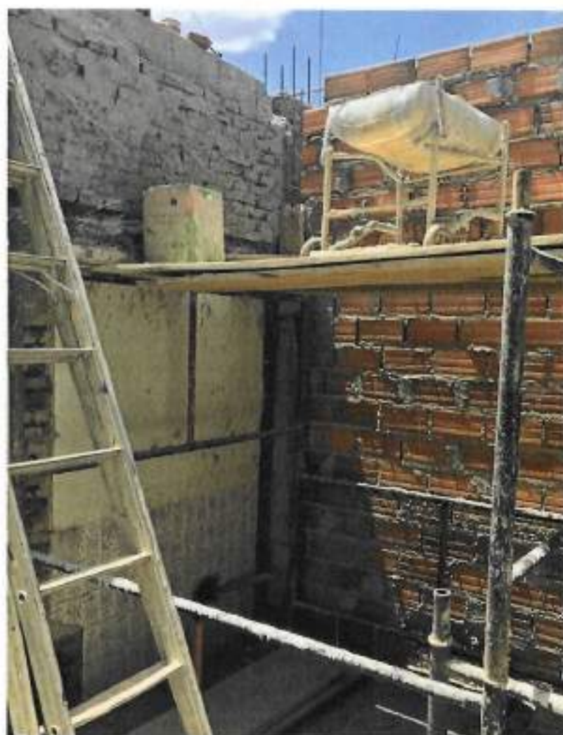
Foto 10 – Enchimento pilar de amarração – data: 22/02/2022
