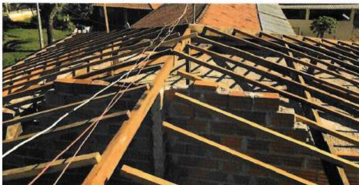
Foto 18 – Fabricação e Instalação de tesouras e caibros – data: 29/06/2022
