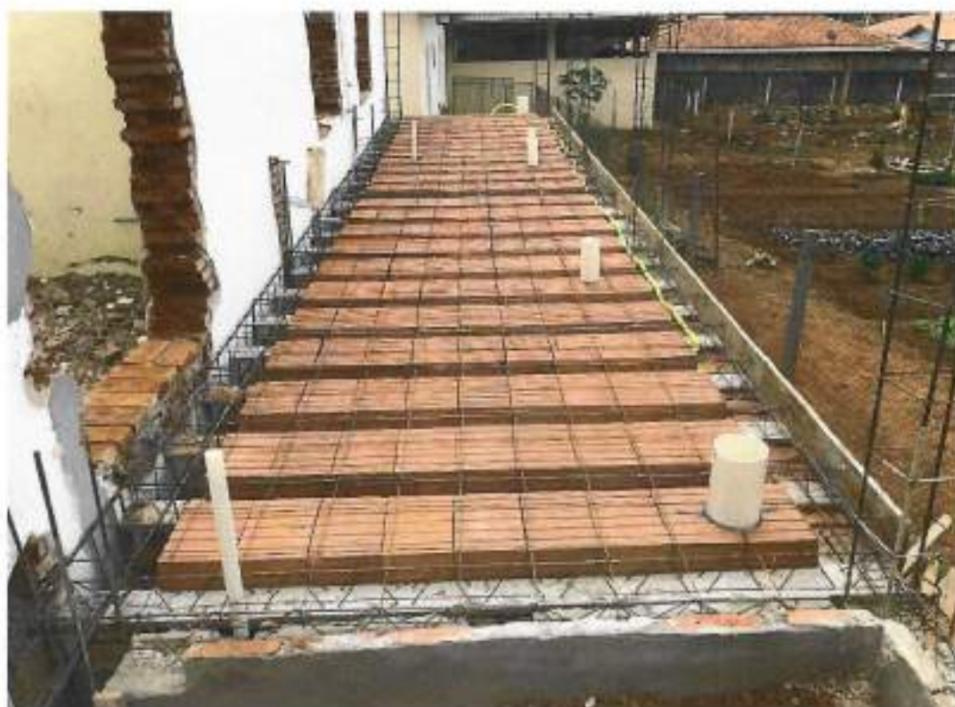
Foto 19 – preparação final tubulação esgoto e concretagem – data: 27/09/2021
