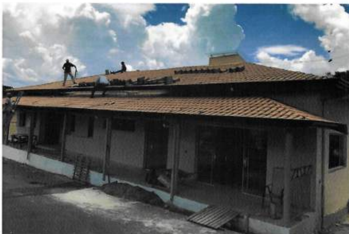
Foto 01 – Colocação de cumieira, espigão e emboço de argamassa – data: 01/11/2022
