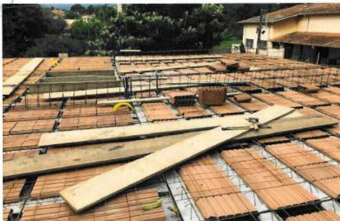
Foto 09 – Montagem de viga de sustentação da laje – data: 10/03/2022
