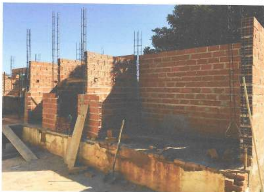
Foto 04 – Armação de pilar, concretagem e alvenaria de vedação – data: 05/11/2021
