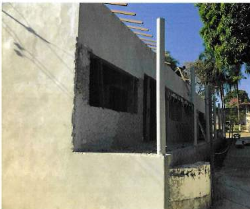
Foto 17 – Aplicação de argamassa em paredes externas – data: 29/06/2022
