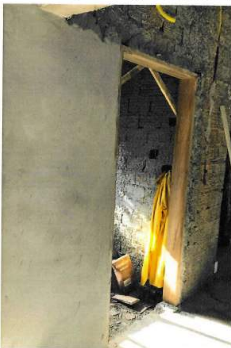
Foto 04 – Colocação de batente de porta e aplicação de argamassa – data: 06/05/2022
