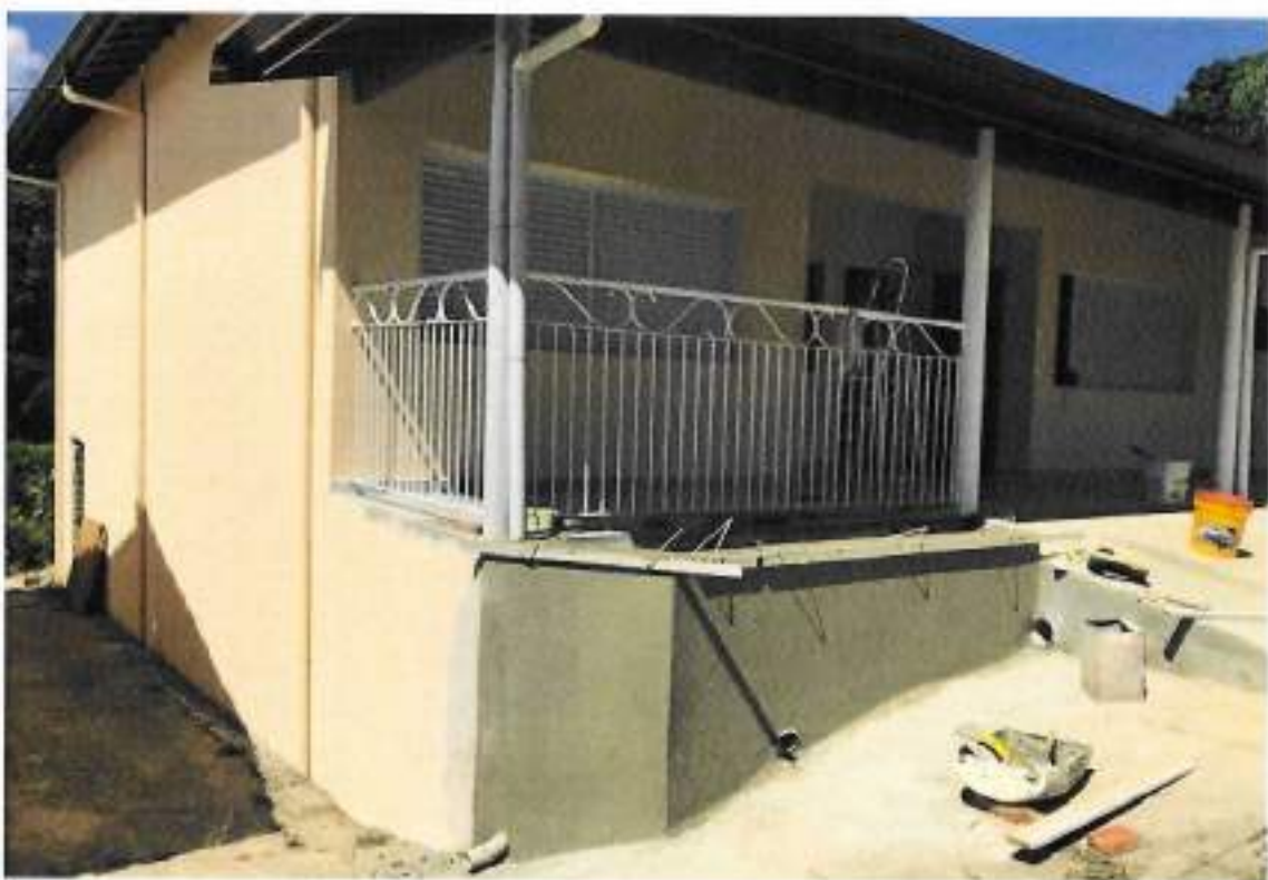
Foto 18 – Construção da floreira frontal e rampa do prédio – data: 28/11/2022
