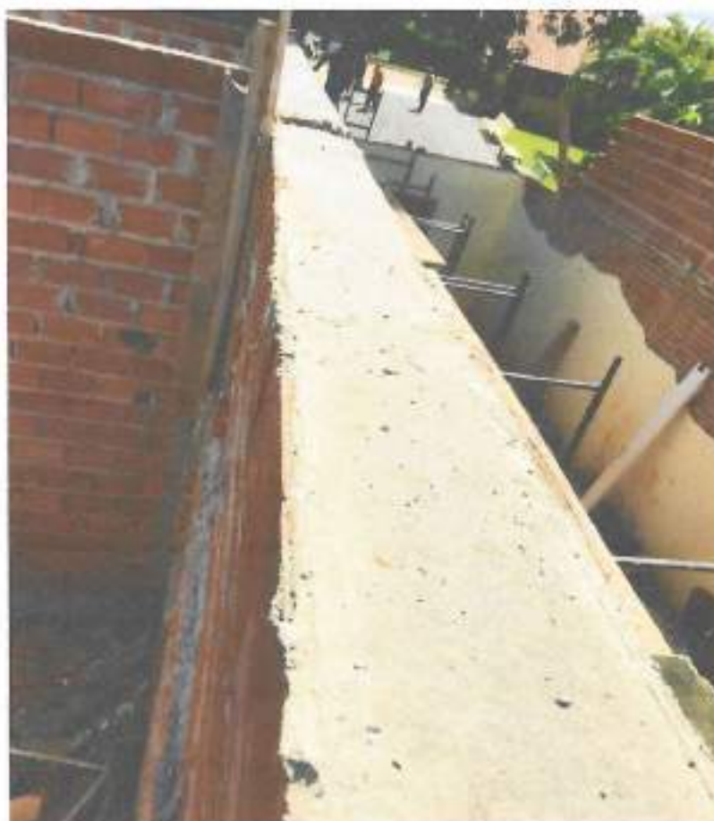
Foto 06 – Armação e concretagem de canaletas – data: 06/12/2021
