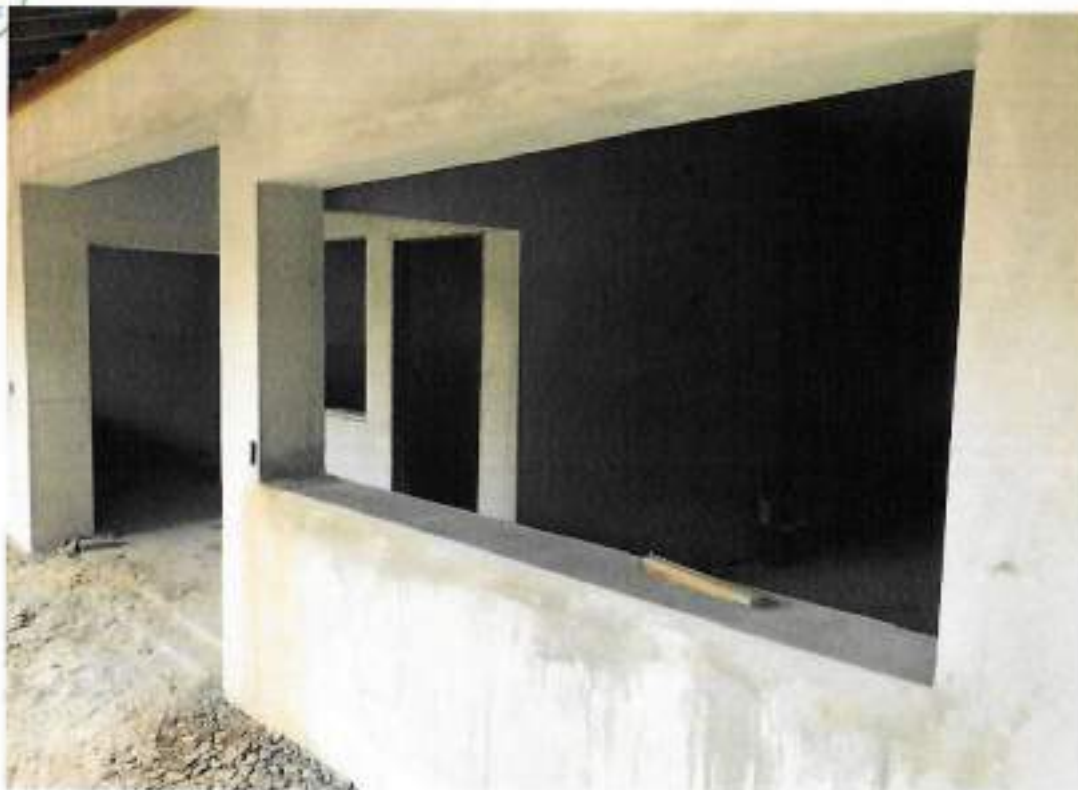
Foto 05 – Aplicação de argamassa em paredes internas e externa – data: 09/08/2022
