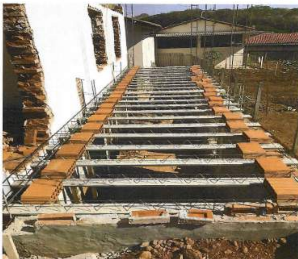
Foto 12 – montagem laje de piso da área de expansão – data: 16/09/2021
