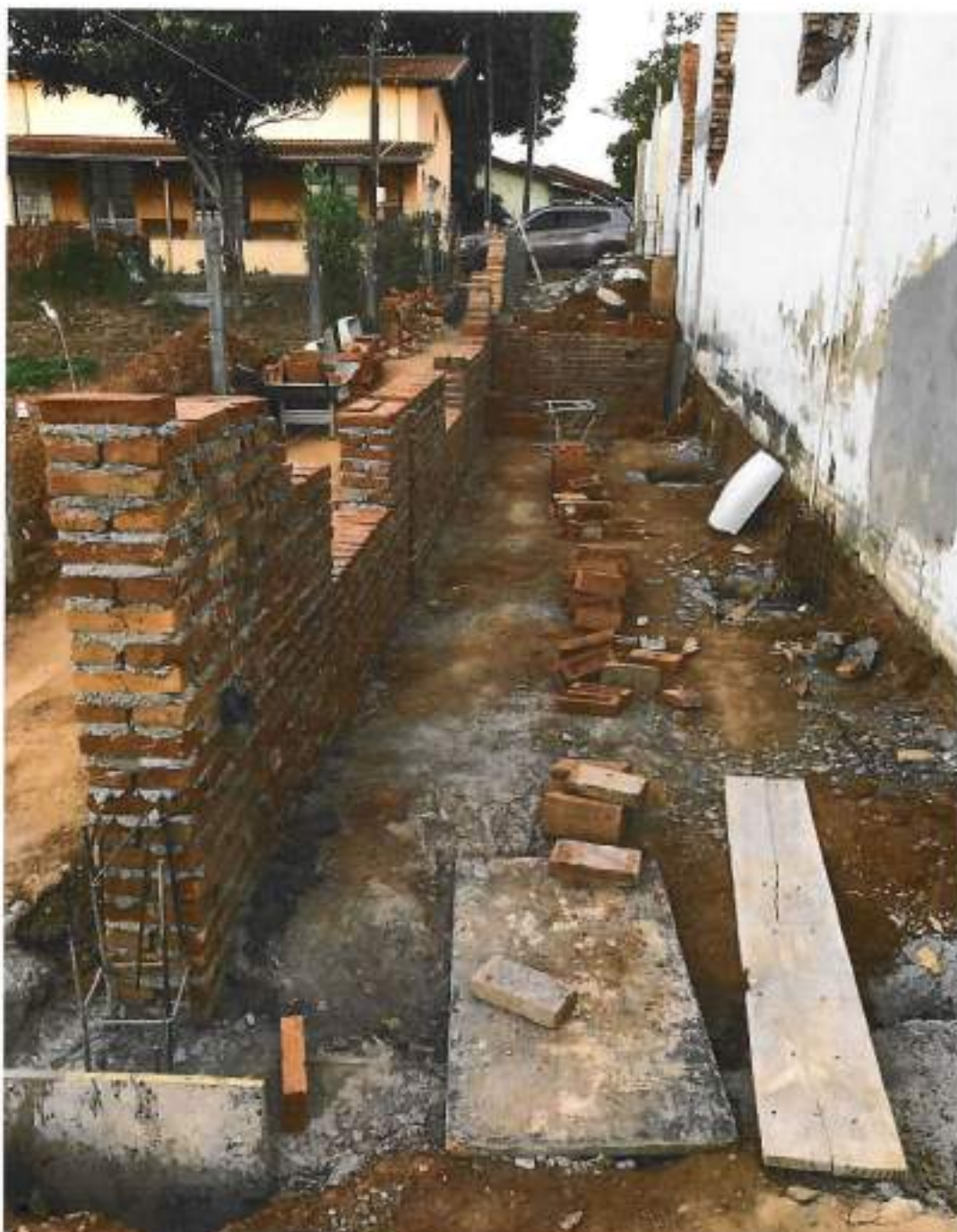
Foto 03 – Levantamento da parede externa de nivelamento – data: 02/09/2021
