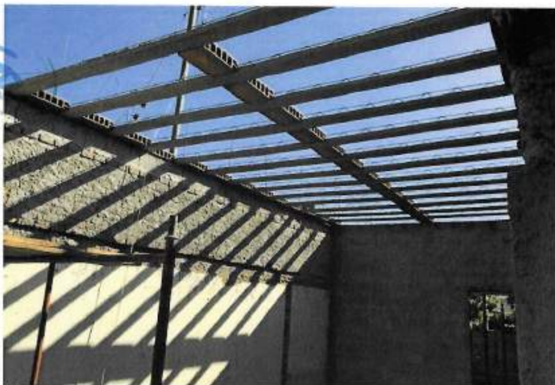
Foto 19 – Montagem da laje pré-moldada de forro – data: 28/02/2022
