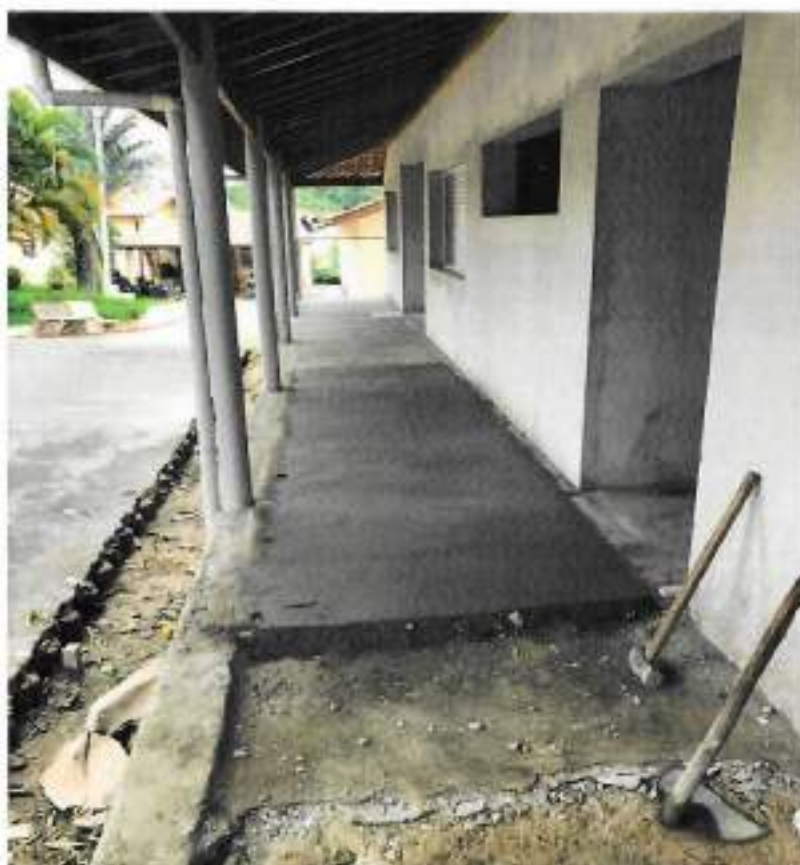
Foto 02 – Aplicação massa de nivelamento para piso cerâmico – data: 03/10/2022
