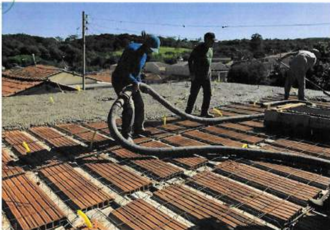
Foto 15 – Concretagem de vigas e laje – data: 23/03/2022
