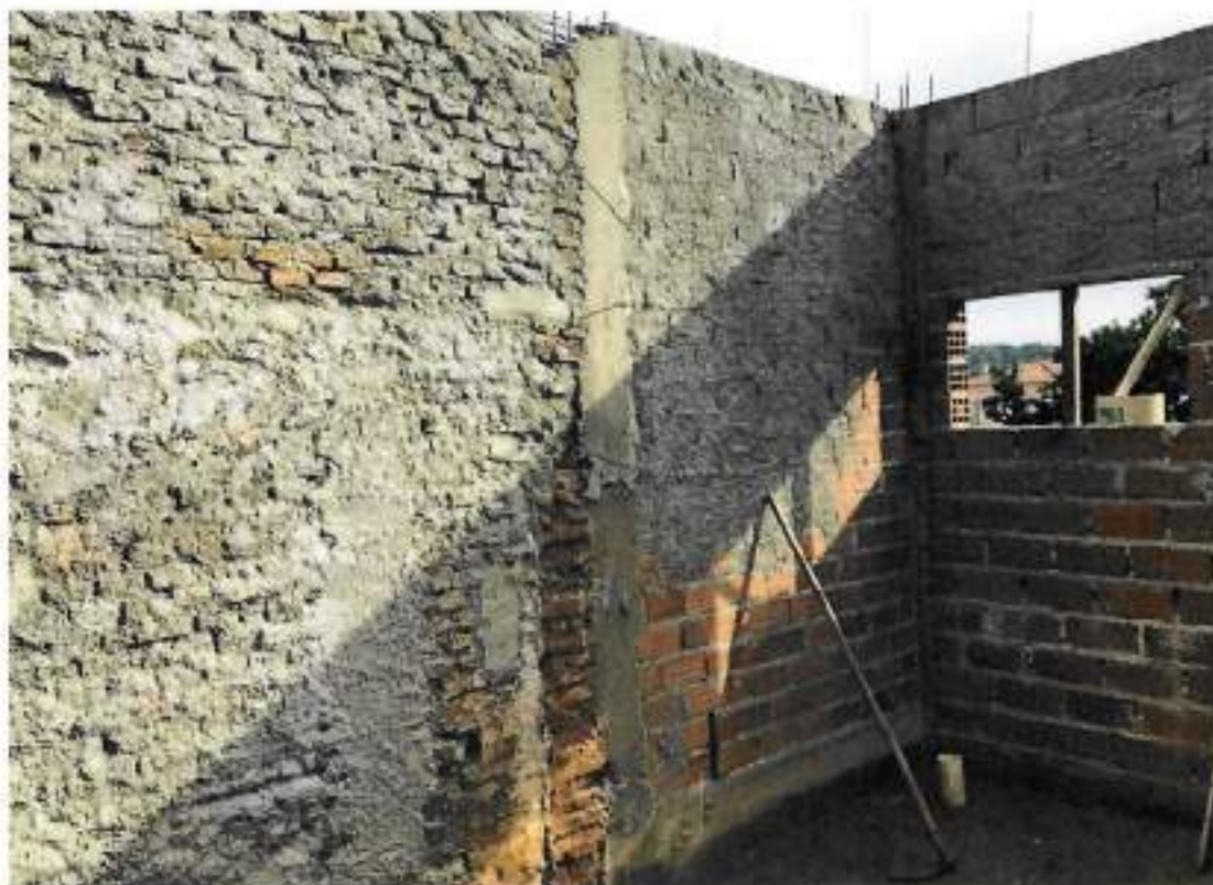
Foto 02 – Desmontagem de caixaria e chapisco – data: 03/02/2022
