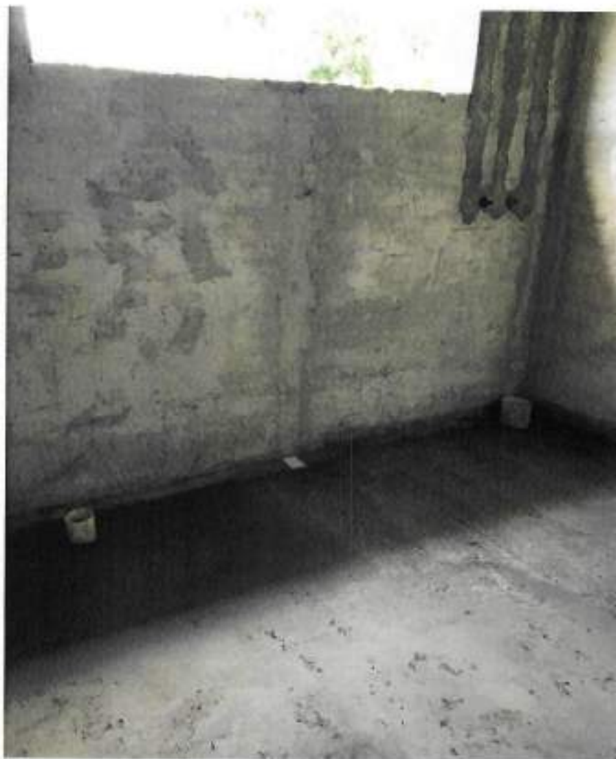
Foto 07 – Aplicação massa de nivelamento para piso cerâmico – data: 12/09/2022
