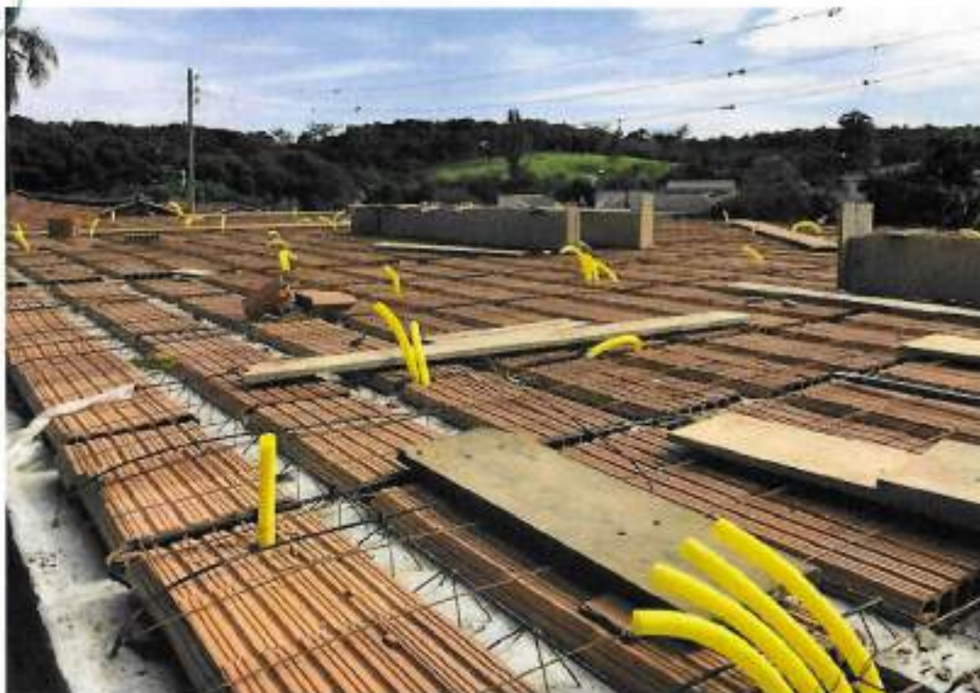
Foto 11 – Enchimento de laje com cerâmica e ferragens– data: 17/03/2022
