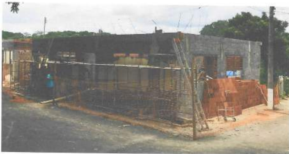
Foto 03 – Alvenaria de vedação, verga e contraverga – data: 10/01/2022
