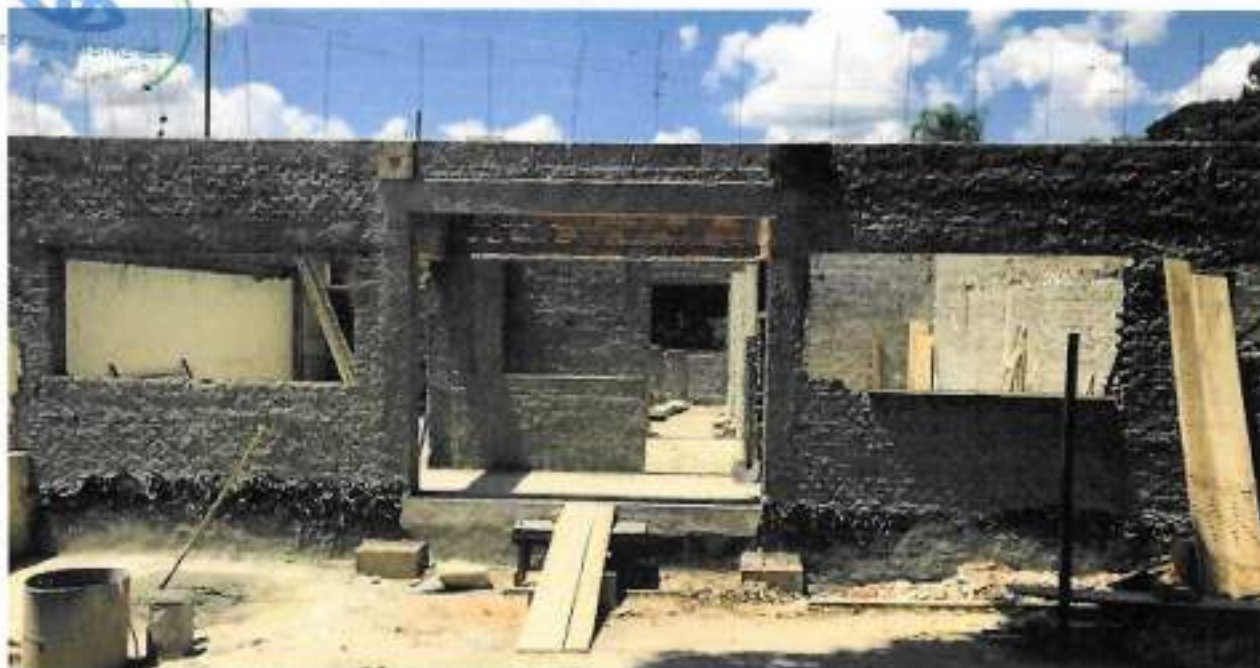
Foto 13 – Chapisco da parede – data: 23/02/2022
