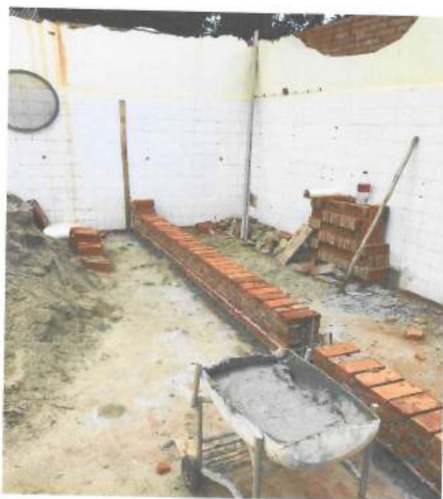
Foto 14 – Alvenaria baldrame da parede corredor – data: 25/11/2021
