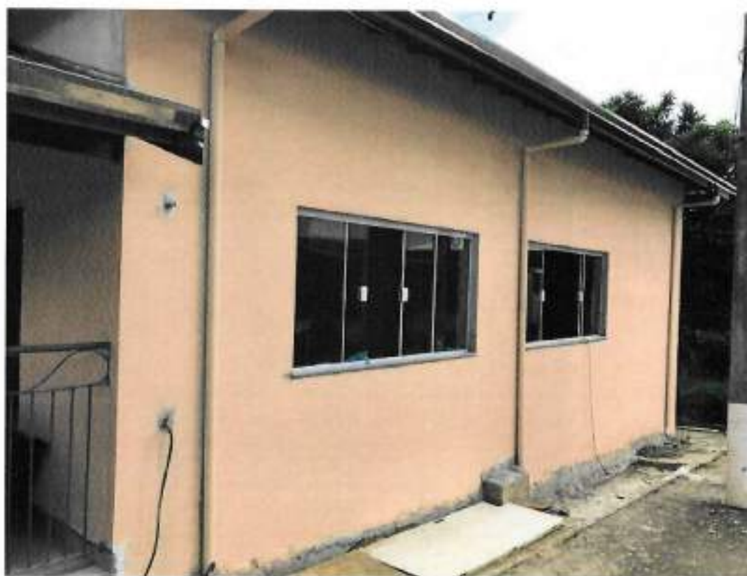
Foto 12 – Aplicação de fundo selador e latéx em paredes externas – data: 19/10/2022
