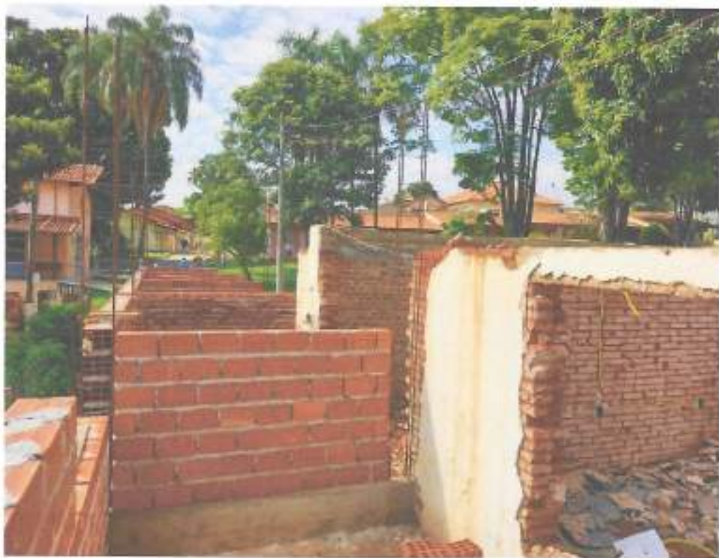
Foto 15 – Alvenaria de vedação de blocos furados – data: 27/10/2021
