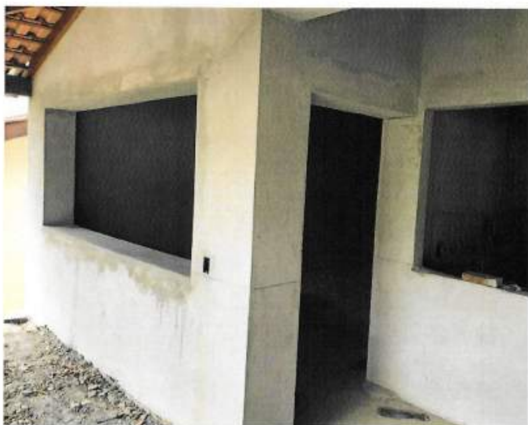
Foto 06 – Aplicação de argamassa em paredes internas e externa – data: 10/08/2022
