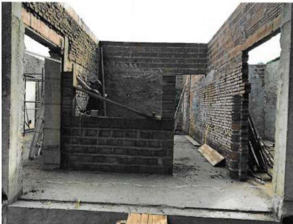
Foto 01 – Armação de pilar, concretagem e alvenaria de vedação – data: 02/02/2022
