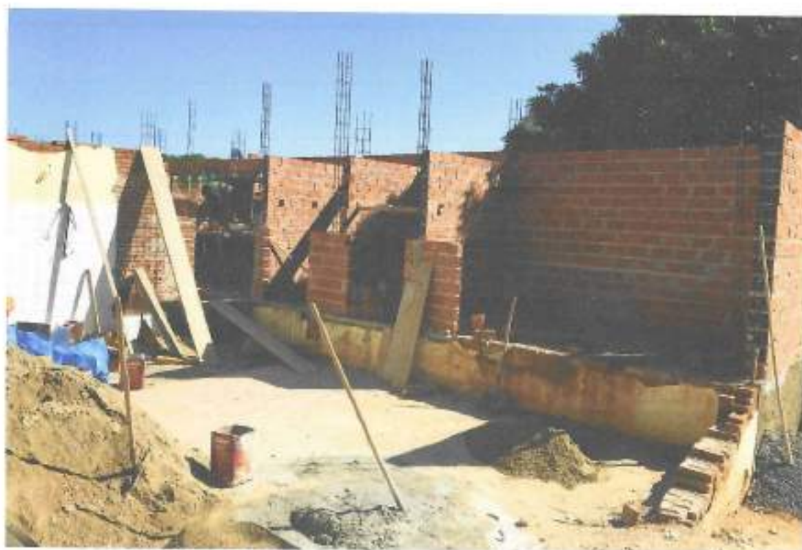
Foto 06 – Armação de pilar, concretagem e alvenaria de vedação – data: 10/11/2021
