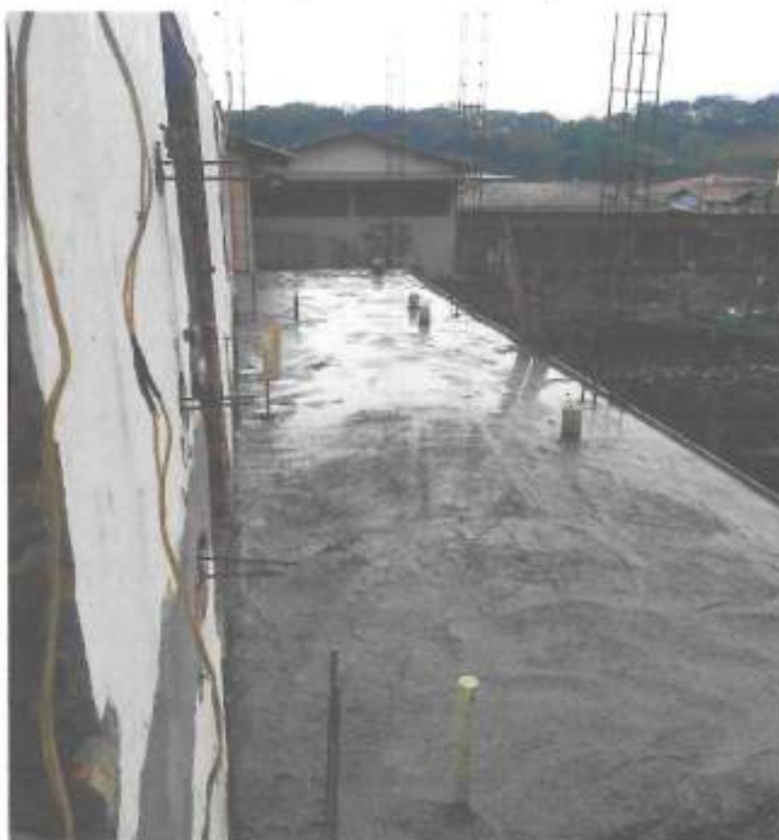
Foto 04 – Concretagem laje de piso da área de expansão – data: 05/10/2021
