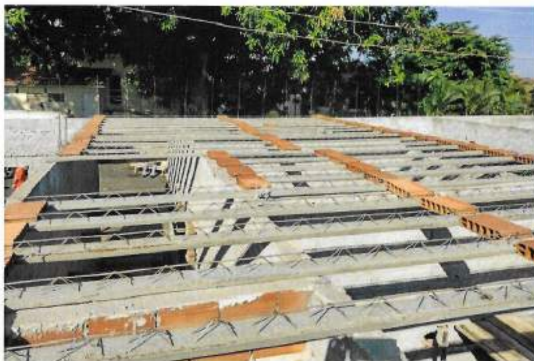
Foto 20 – Montagem da laje pré-moldada de forro – data: 28/02/2022
