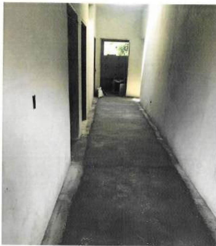
Foto 19 – Aplicação massa de nivelamento para piso cerâmico – data: 29/09/2022
