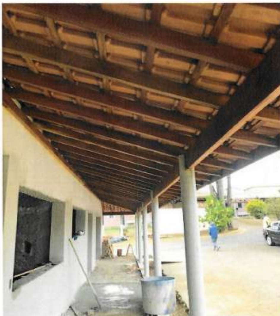
Foto 13 – Telhamento com telhas cerâmicas de encaixe no terraço – data: 25/07/2022
