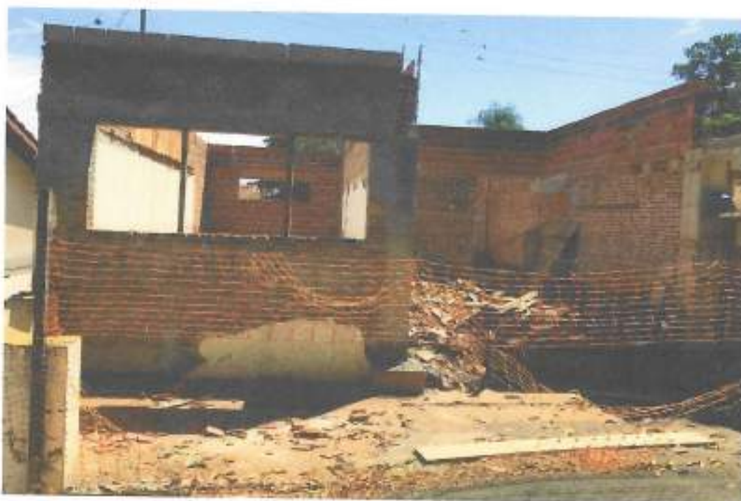
Foto 19 – Alvenaria de vedação, canaleta e chapisco – data: 29/12/2021
