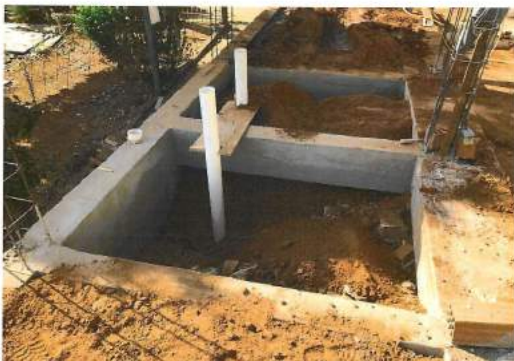
Foto 11 – impermeabilização de baldrame e vigas – data: 15/09/2021
