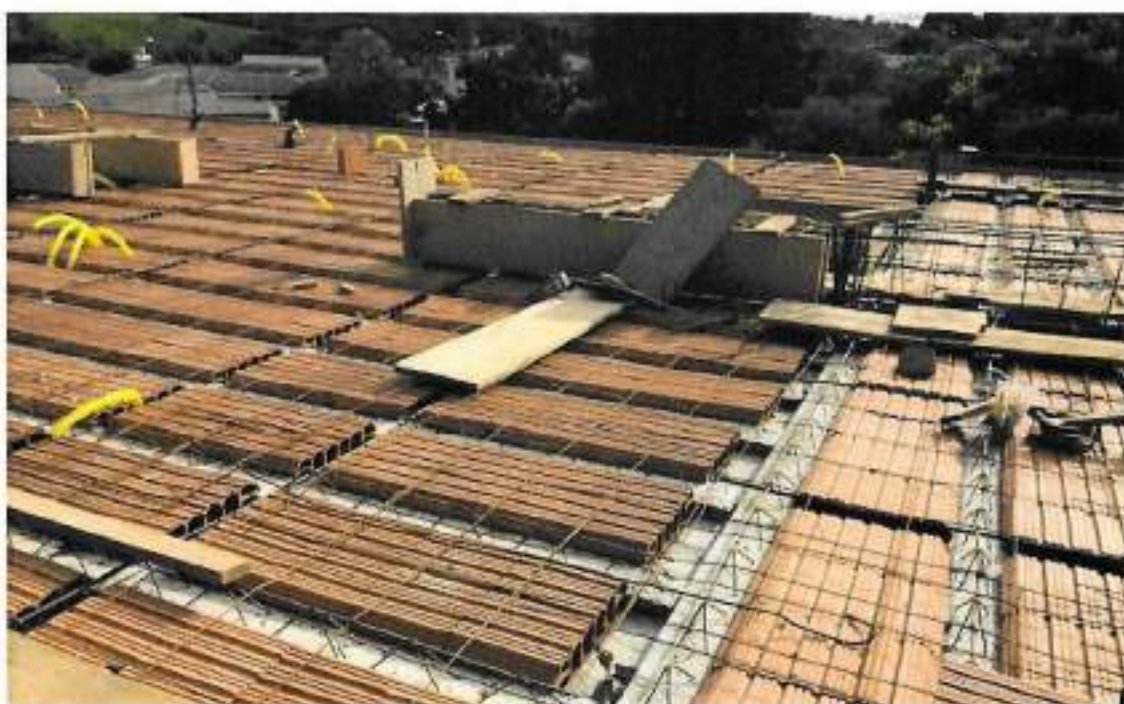
Foto 12 – Montagem de caixa de vigas – data: 21/03/2022
