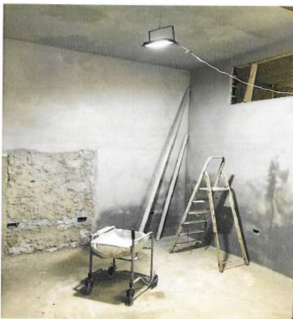
Foto 04 – Aplicação de argamassa em paredes internas – data: 05/08/2022
