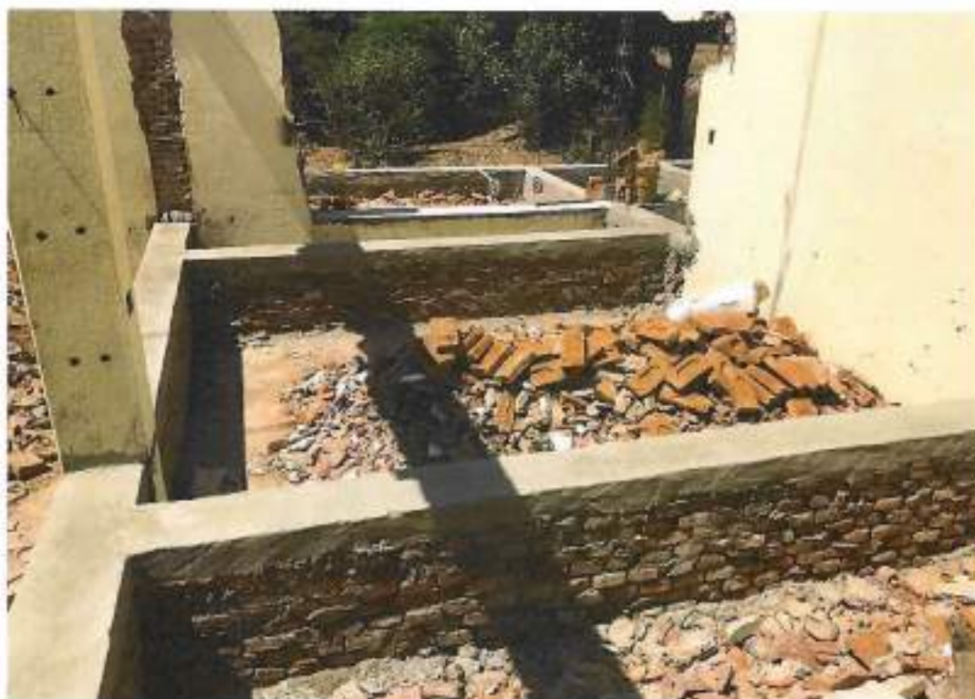
Foto 17 – enchimento e impermeabilização baldrames – data: 22/09/2021
