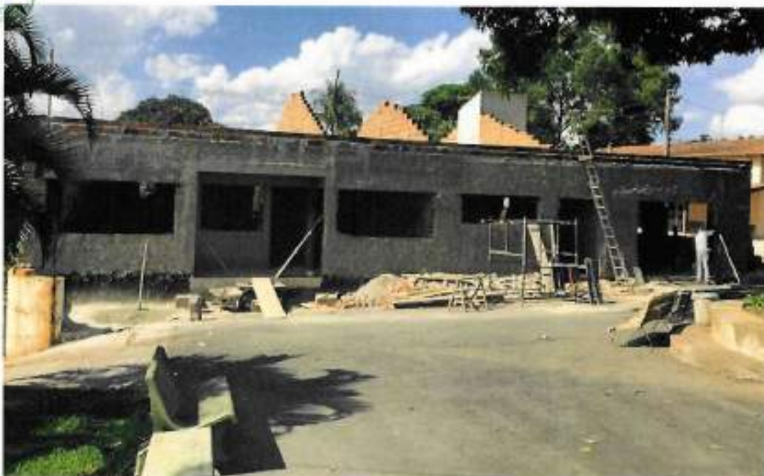
Foto 19 – Alvenaria de bloco furado da cobertura – data: 28/04/2022
