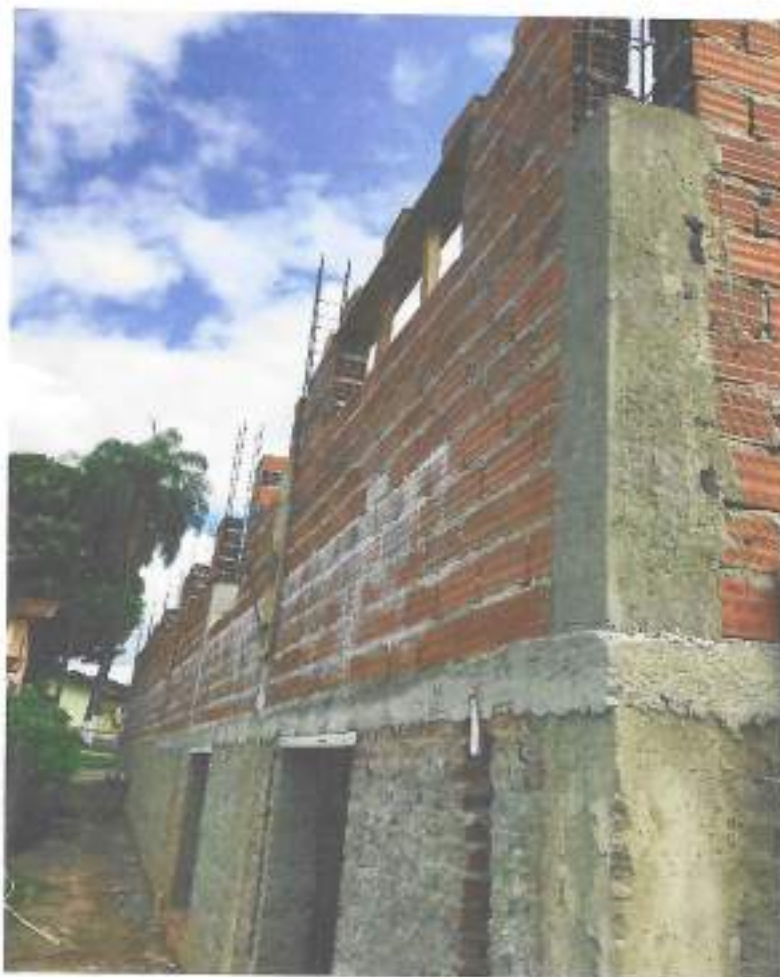
Foto 03 – Armação de pilar, concretagem e alvenaria de vedação – data: 05/11/2021
