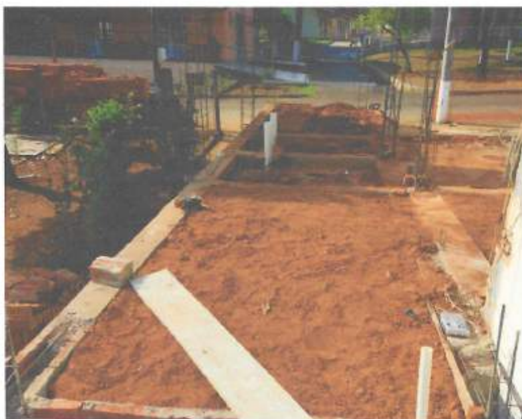
Foto 06 – Aterro manual da área de expansão – data: 07/10/2021
