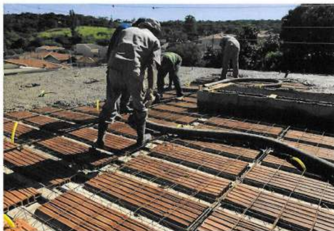
Foto 14 – Concretagem de vigas e laje – data: 23/03/2022
