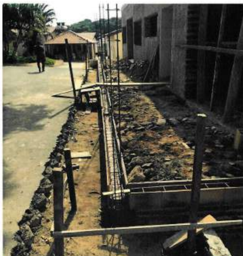
Foto 01 – Armação de ferragem de canaletas– data: 01/06/2022
