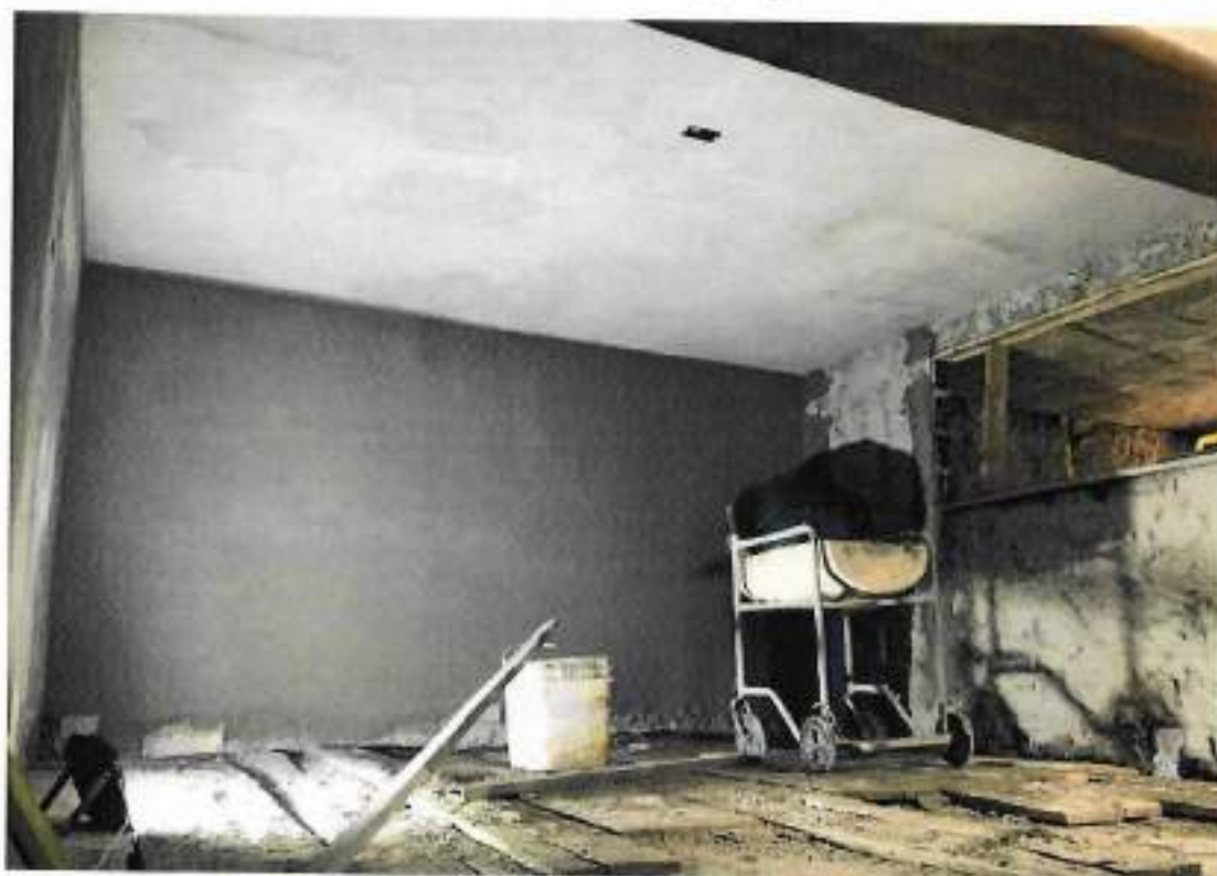
Foto 01 – Aplicação de argamassa em paredes internas – data: 01/08/2022
