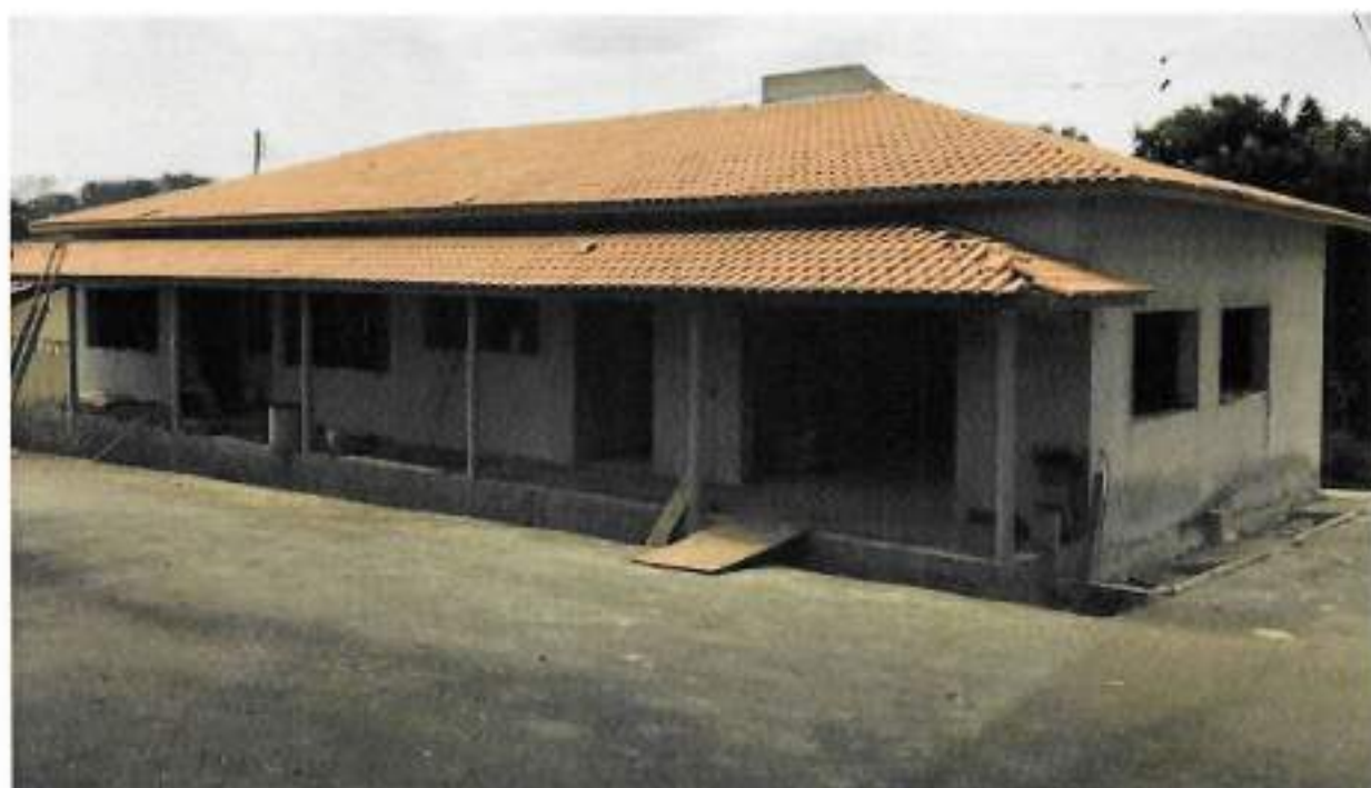
Foto 12 – Telhamento com telhas cerâmicas de encaixe no terraço – data: 25/07/2022
