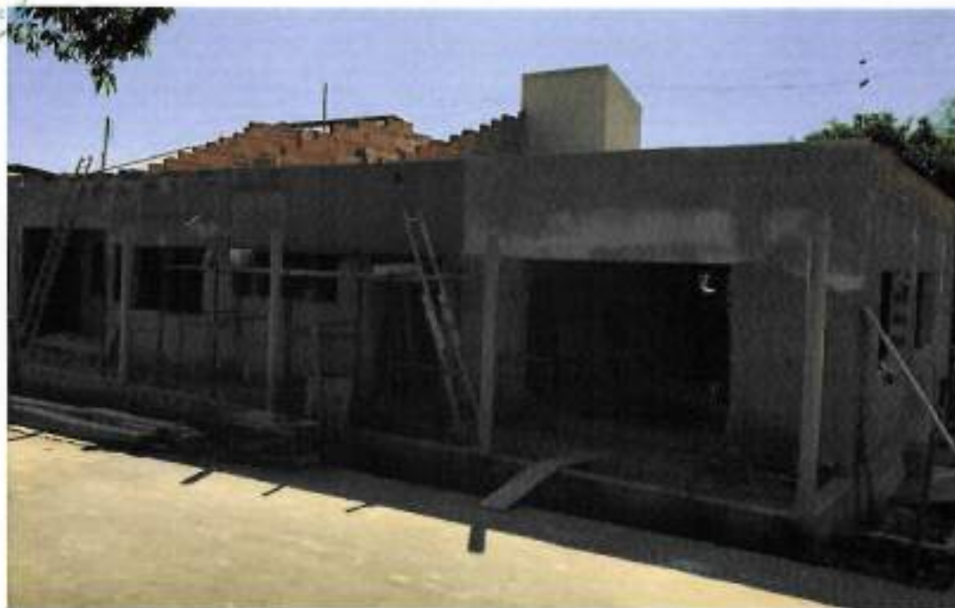
Foto 11 – Aplicação de argamassa em paredes externas – data: 17/06/2022
