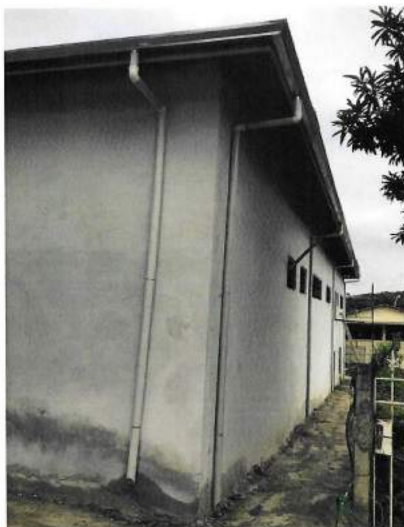
Foto 18 – Colocação de calhas de beiral, bocais e transportes verticais – data: 28/07/2022
