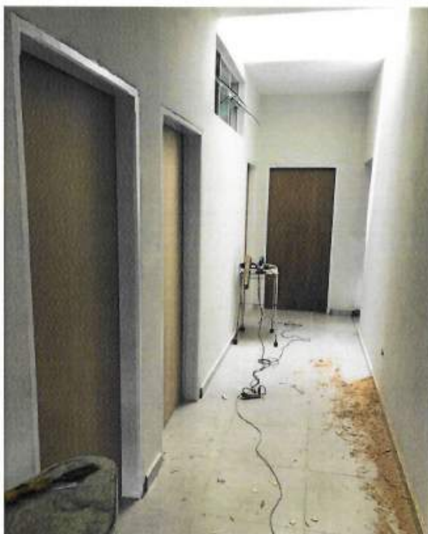
Foto 04 – Colocação dos kits de portas de madeira para pintura – data: 07/11/2022
