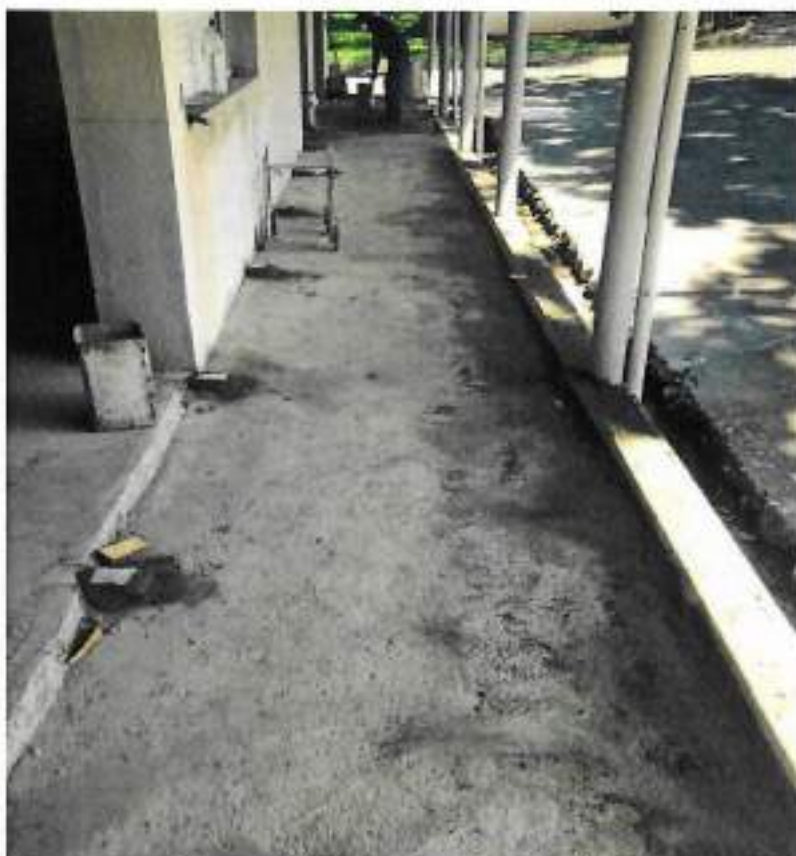
Foto 01 – Aplicação massa de nivelamento para piso cerâmico – data: 01/10/2022
