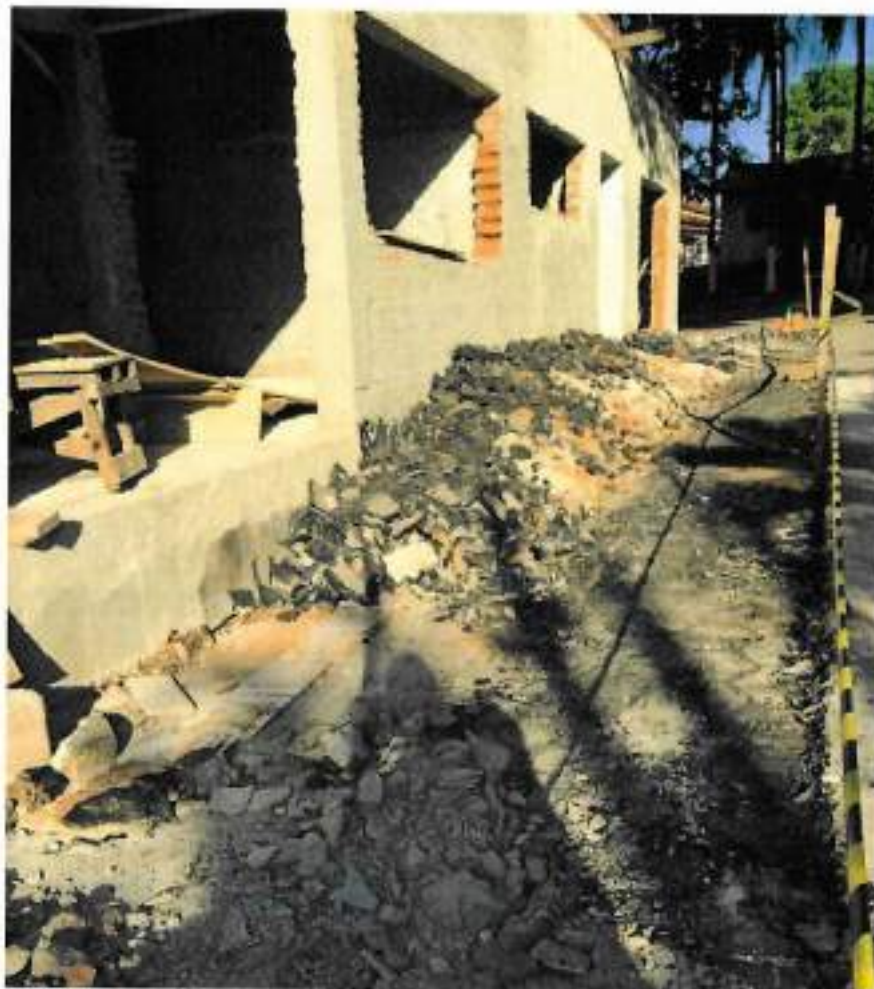
Foto 11 – Abertura baldrame do terraço frontal – data: 23/05/2022
