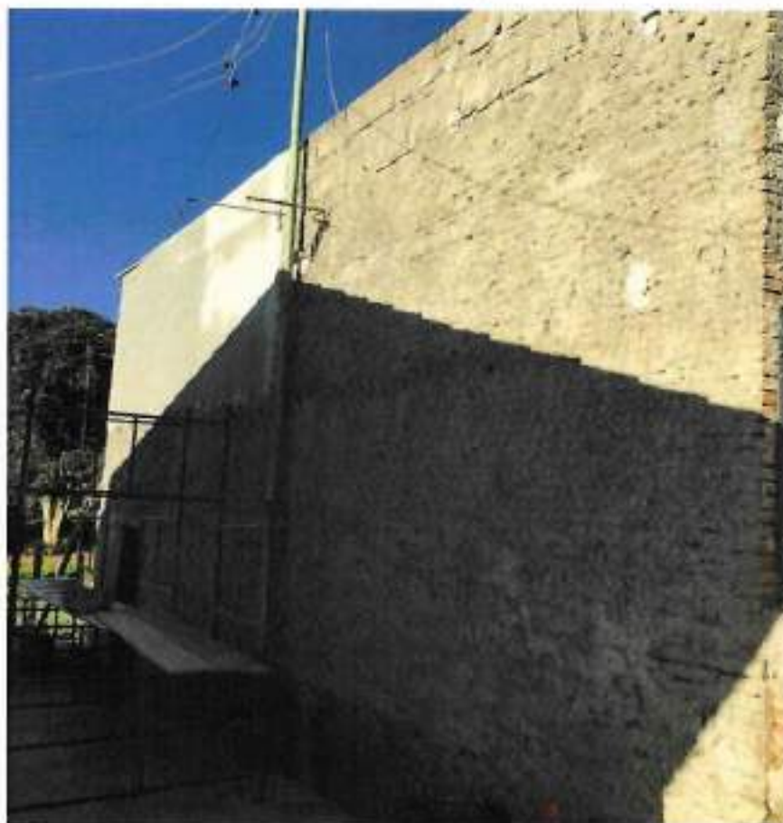
Foto 10 – Aplicação de argamassa em paredes externas – data: 16/06/2022
