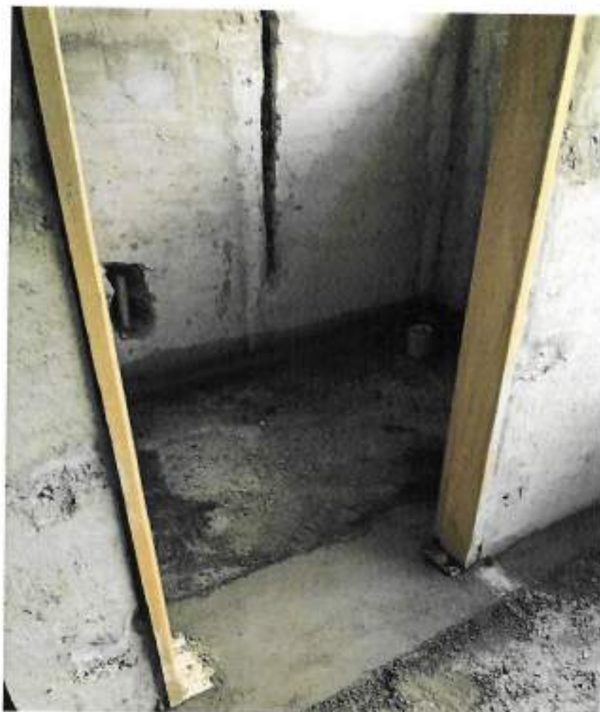
Foto 15 – Aplicação massa de nivelamento para piso cerâmico – data: 26/08/2022
