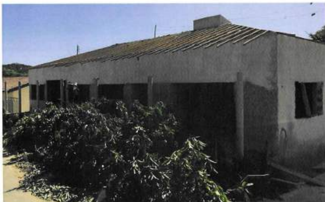
Foto 04 – Fabricação e Instalação de tesouras e caibros – data: 06/07/2022
