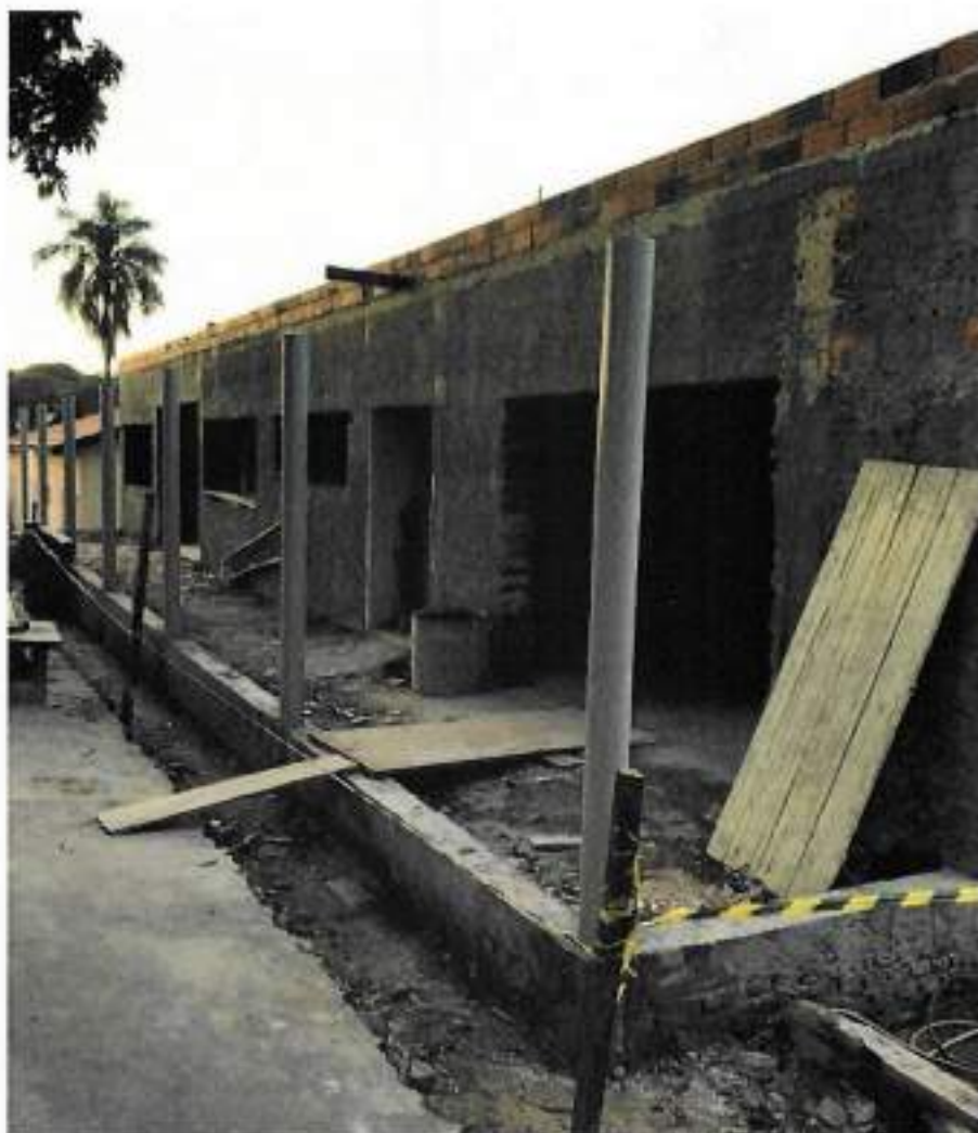
Foto 09 – Concretagem de pilares do terraço frontal – data: 15/06/2022
