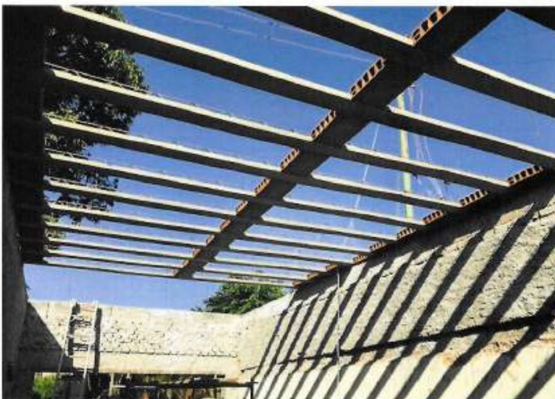
Foto 18 – Montagem da laje pré-moldada de forro – data: 25/02/2022
