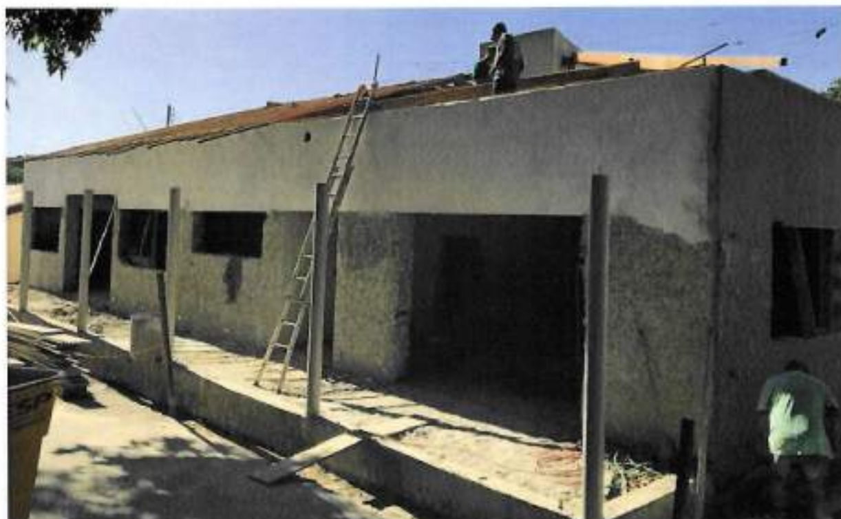
Foto 01 – Aplicação de argamassa e madeiramento do telhado – data: 01/07/2022
