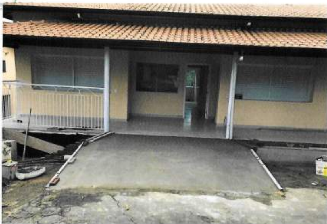
Foto 17 – Construção da floreira frontal e rampa do prédio – data: 25/11/2022
