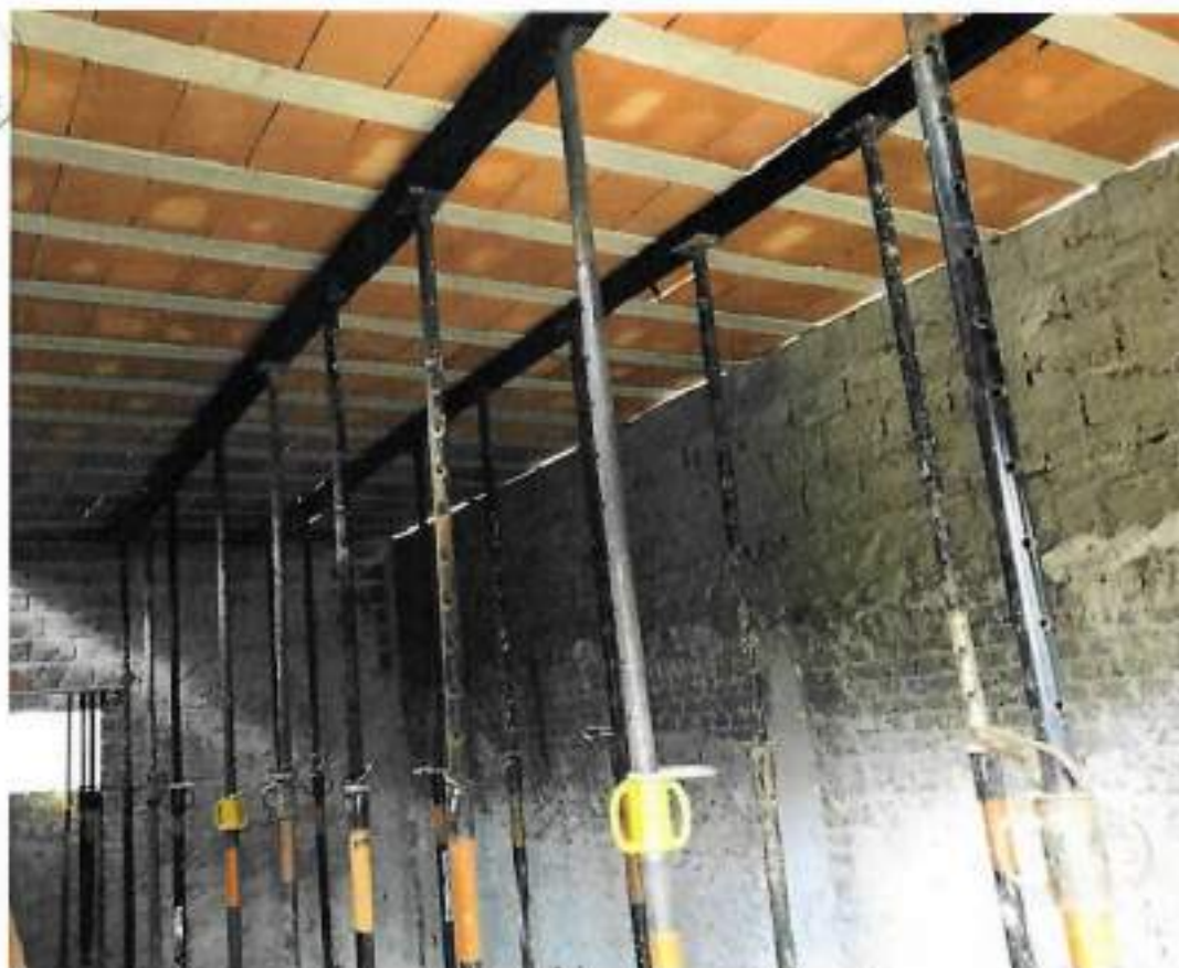
Foto 03 – Enchimento de laje com cerâmica – data: 03/03/2022
