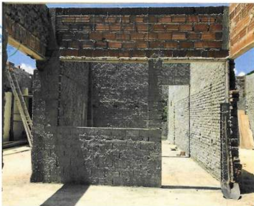
Foto 09 – Chapisco da parede – data: 22/02/2022
