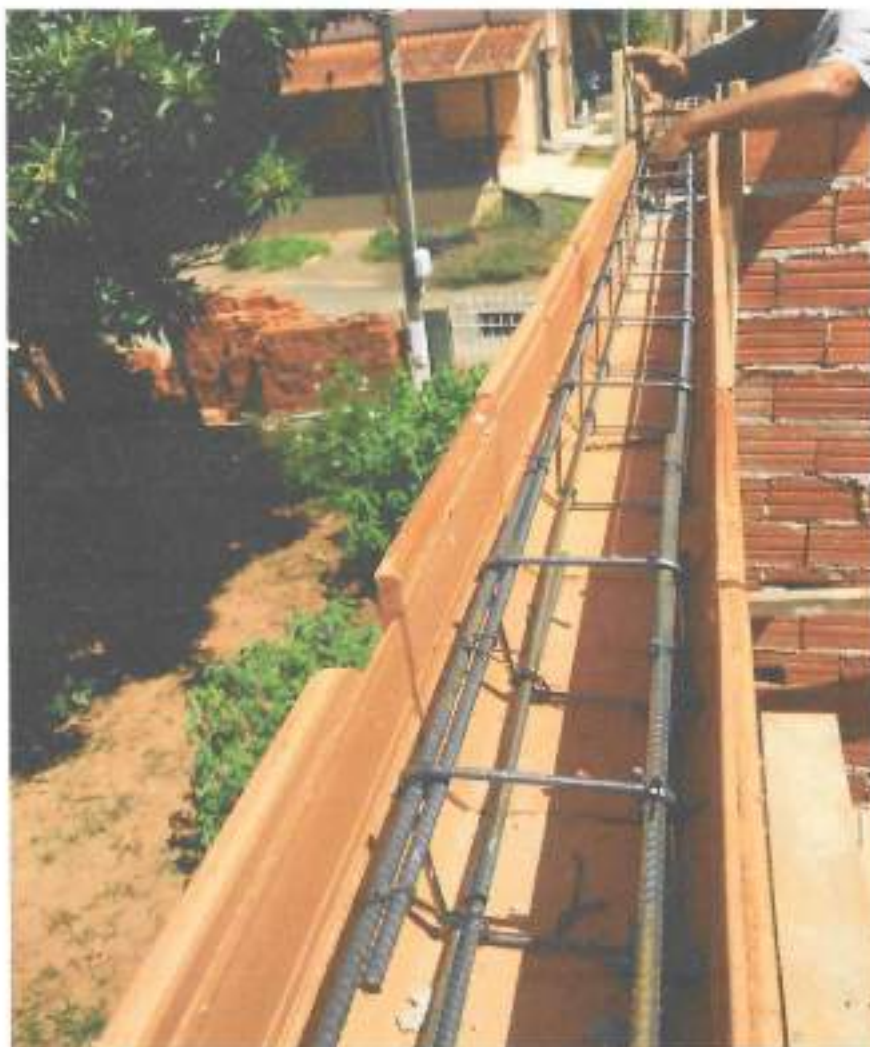
Foto 07 – Armação e concretagem de canaletas – data: 07/12/2021
