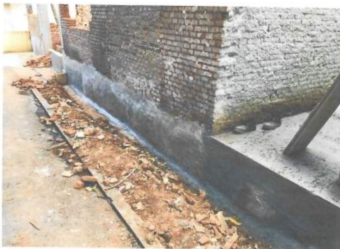
Foto 09 – Impermeabilização de alicerce da parede – data: 19/01/2022
