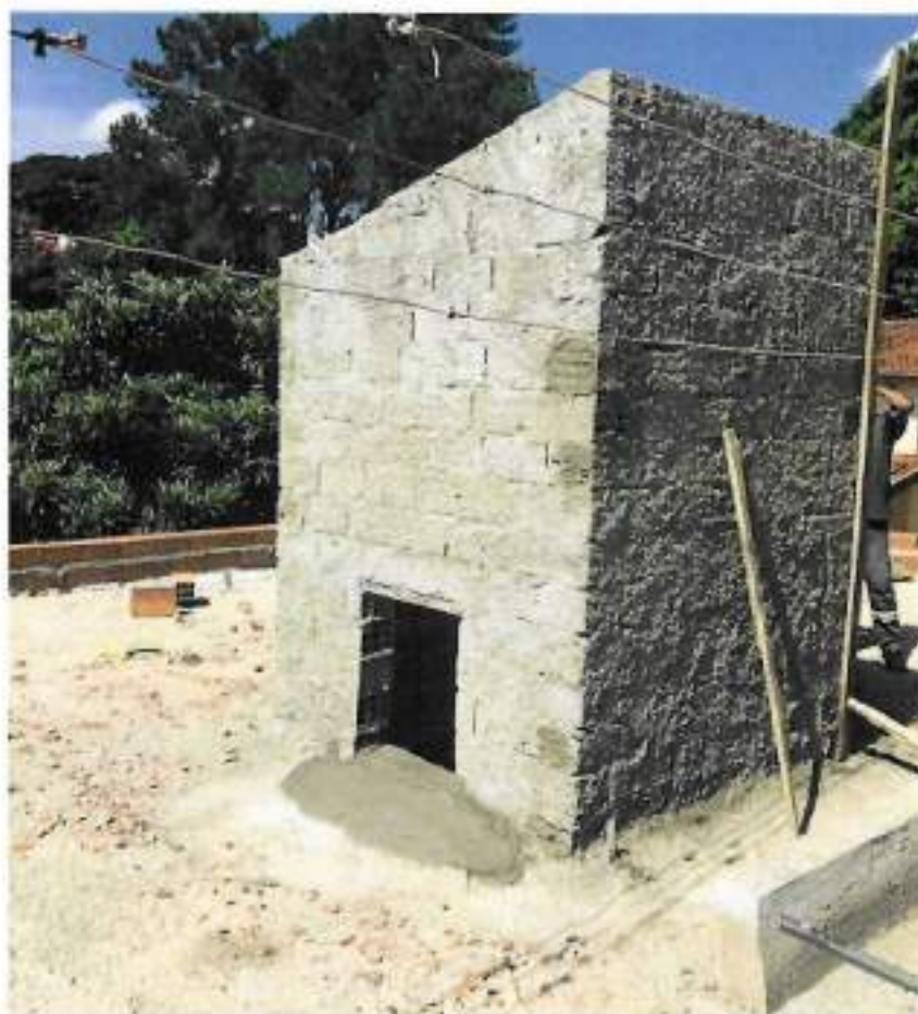
Foto 04 – Alvenaria de blocos furados do Domus – data: 07/04/2022
