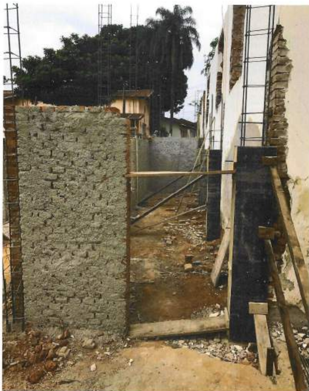
Foto 08 – Montagem e concretagem de pilares – data: 10/09/2021
