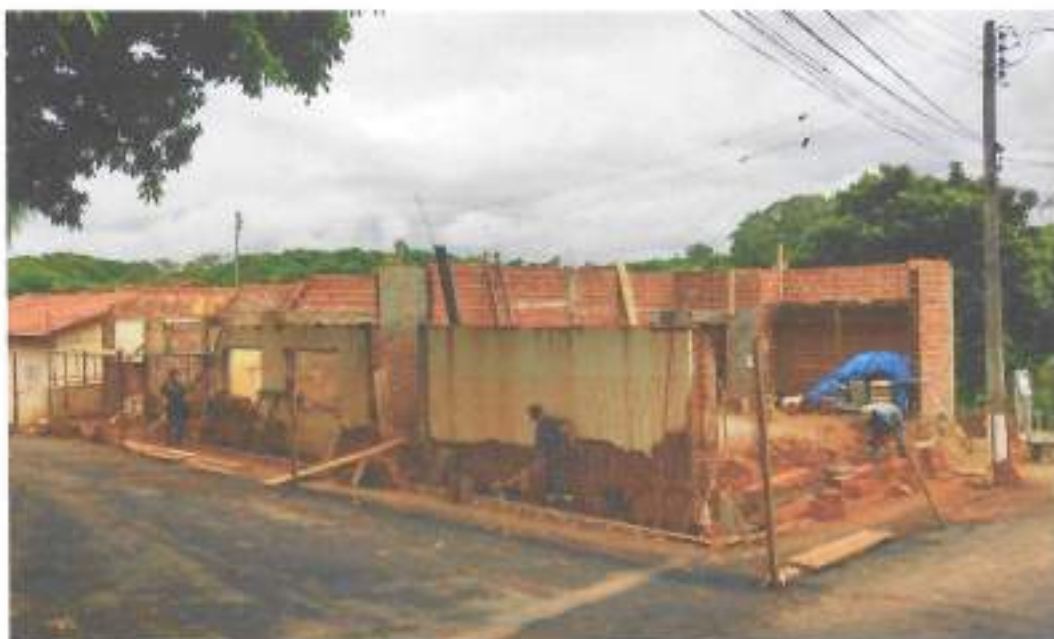
Foto 09 – Alvenaria baldrame da parede – data: 08/12/2021
