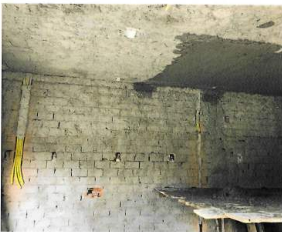
Foto 08 – Aplicação de argamassa em faces internas – data: 16/05/2022
