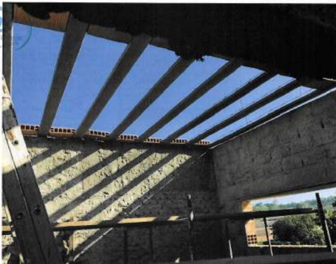
Foto 15 – Montagem da laje pré-moldada de forro – data: 24/02/2022
