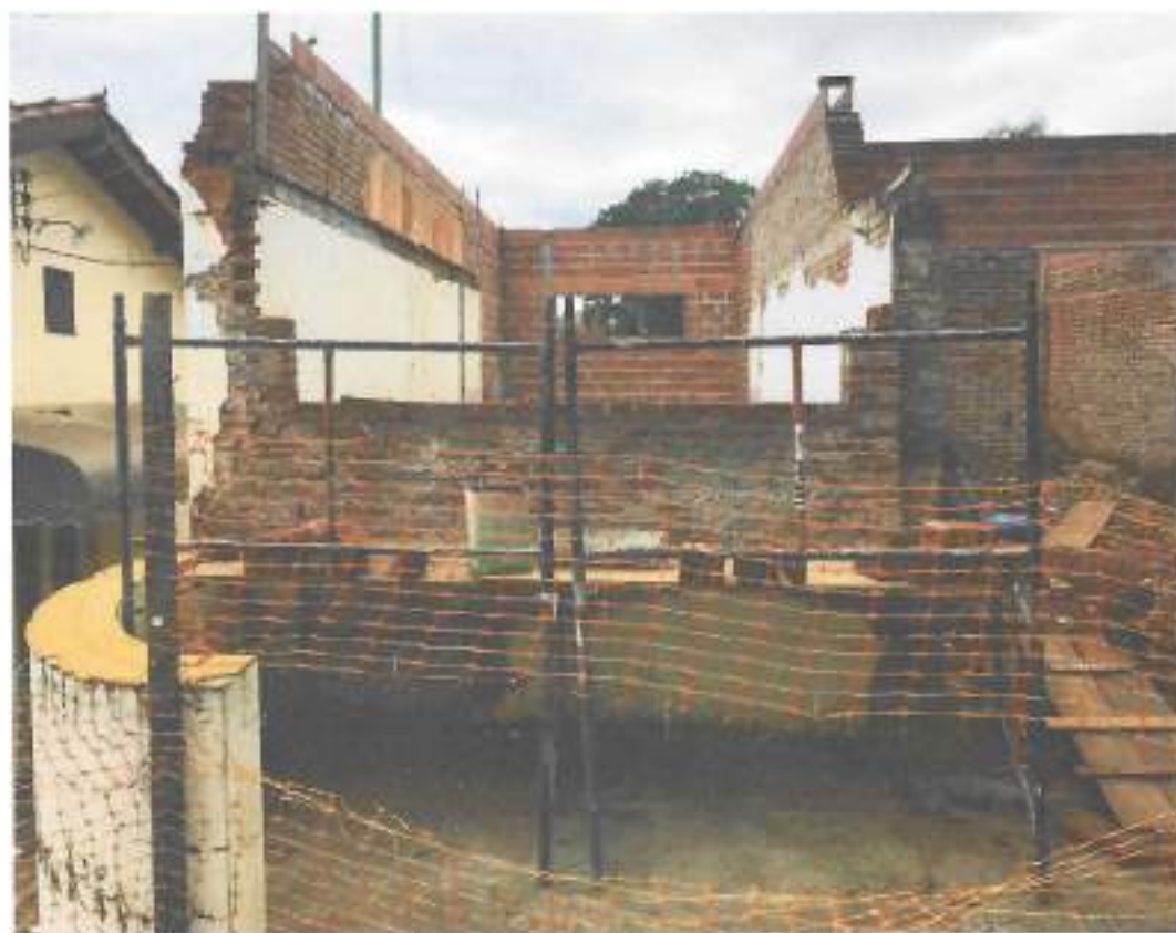
Foto 10 – Alvenaria de vedação e janela frontal – data: 08/12/2021
