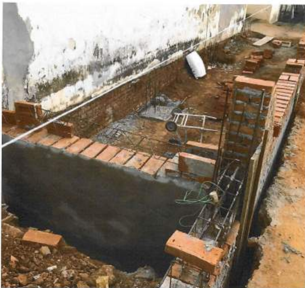
Foto 02 – Impermeabilizando as paredes do baldrame – data: 02/09/2021
