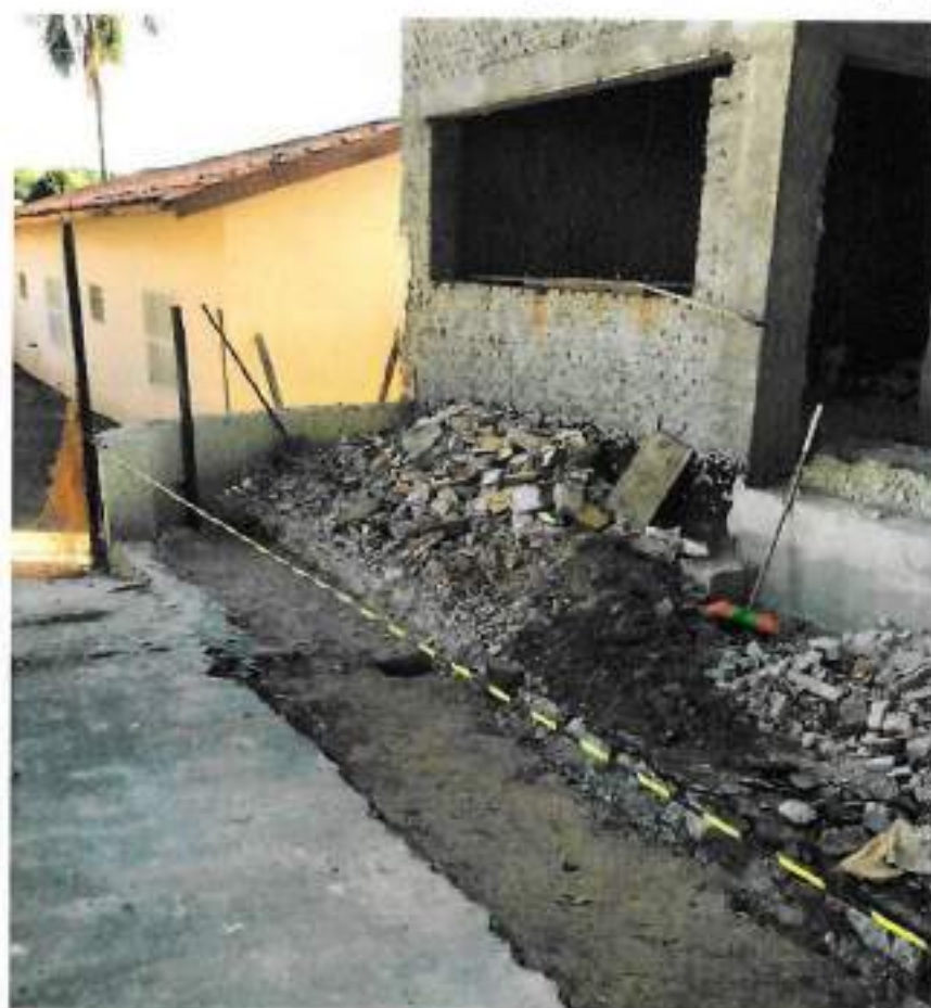
Foto 12 – Abertura baldrame e brocas do terraço frontal – data: 24/05/2022
