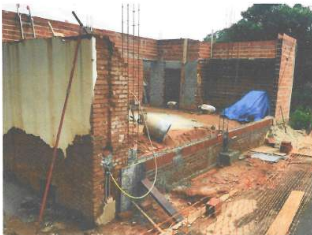
Foto 13 – Alvenaria baldrame da parede – data: 15/12/2021
