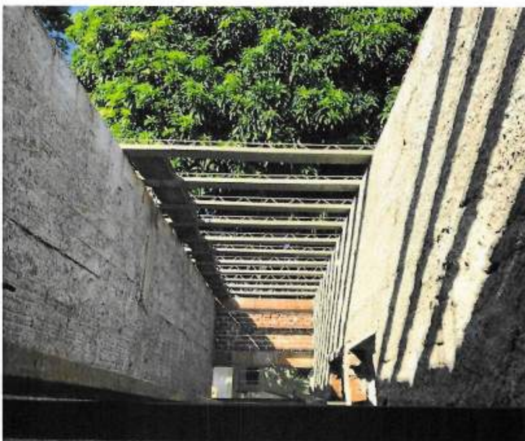
Foto 16 – Montagem da laje pré-moldada de forro – data: 25/02/2022
