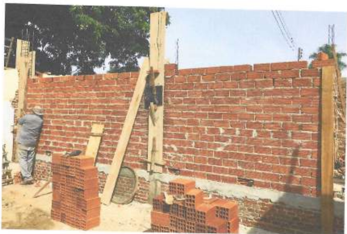
Foto 17 – Alvenaria de vedação de blocos furados – data: 29/11/2021
