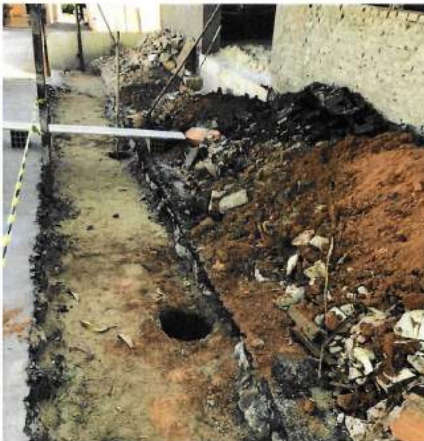
Foto 14 – Abertura baldrame e brocas do terraço frontal – data: 24/05/2022
