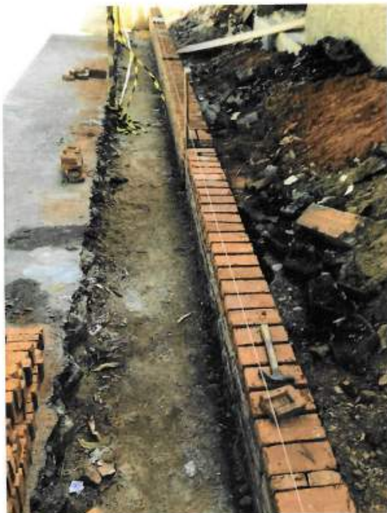
Foto 17 – Alvenaria do baldrame do terraço frontal – data: 27/05/2022
