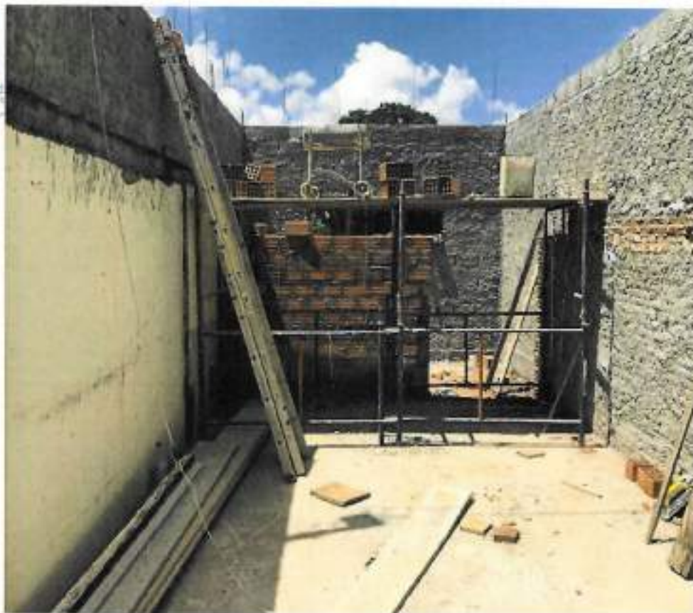
Foto 07 – Alvenaria de vedação – data: 18/02/2022
