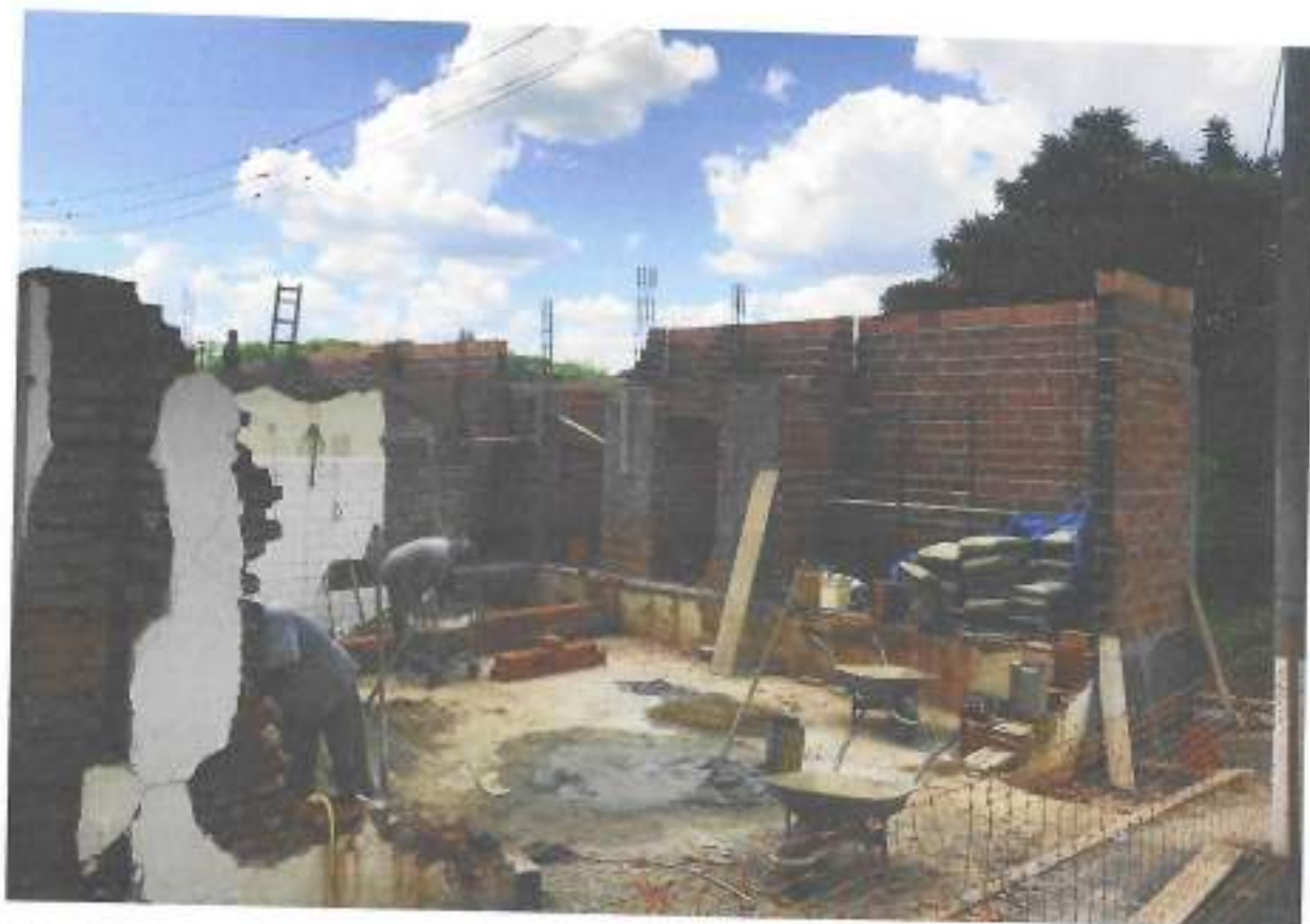
Foto 13 – Alvenaria de vedação e verga moldada de canaletas – data: 22/11/2021
