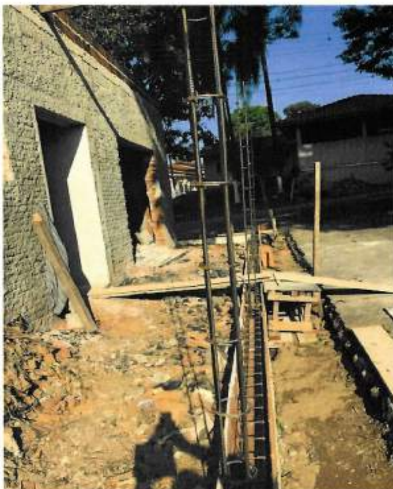
Foto 03 – Armação de ferragem de canaletas – data: 03/06/2022
