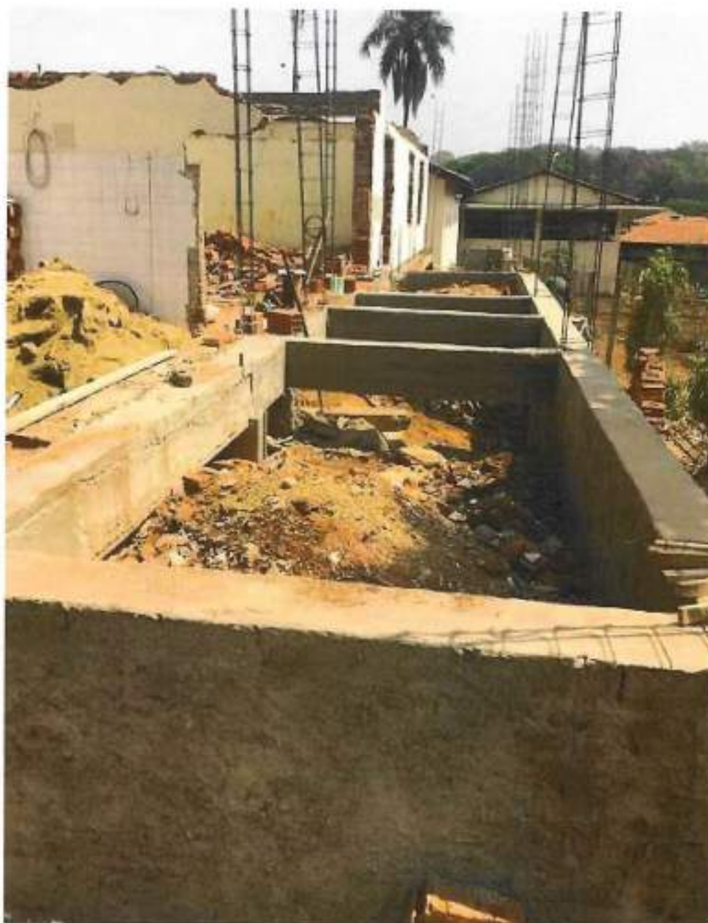
Foto 10 – desmontagem de formas de vigas e pilares – data: 14/09/2021
