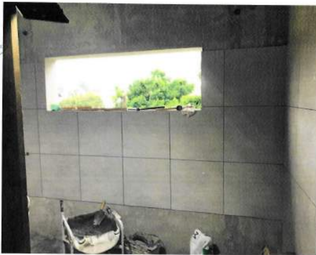
Foto 05 – Revestimento cerâmico para paredes internas – data: 07/10/2022
