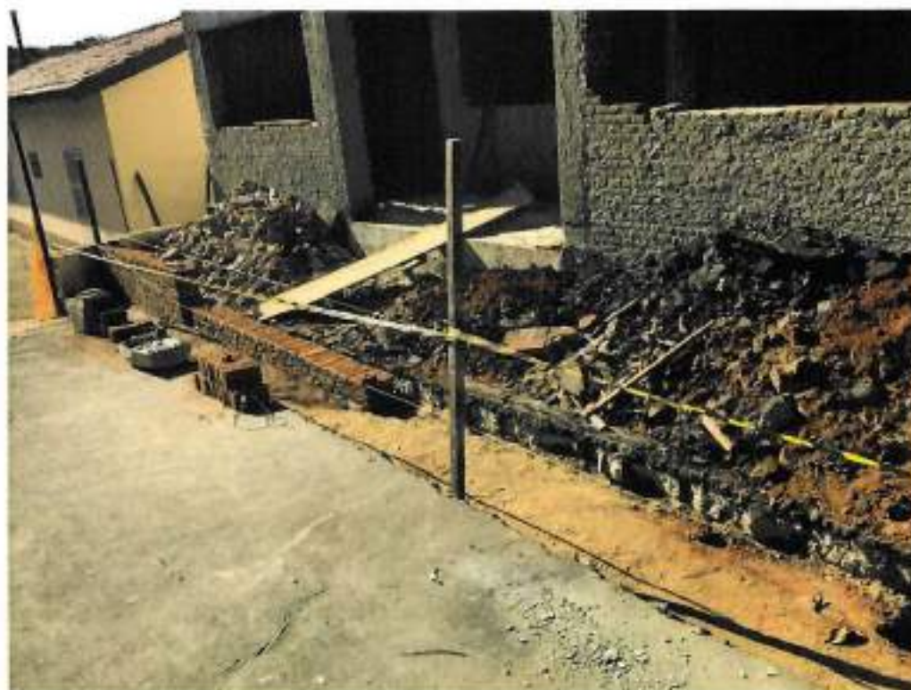
Foto 16 – Alvenaria do baldrame do terraço frontal – data: 26/05/2022
