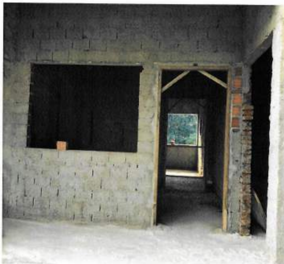
Foto 01 – Colocação de batente de porta – data: 02/05/2022
