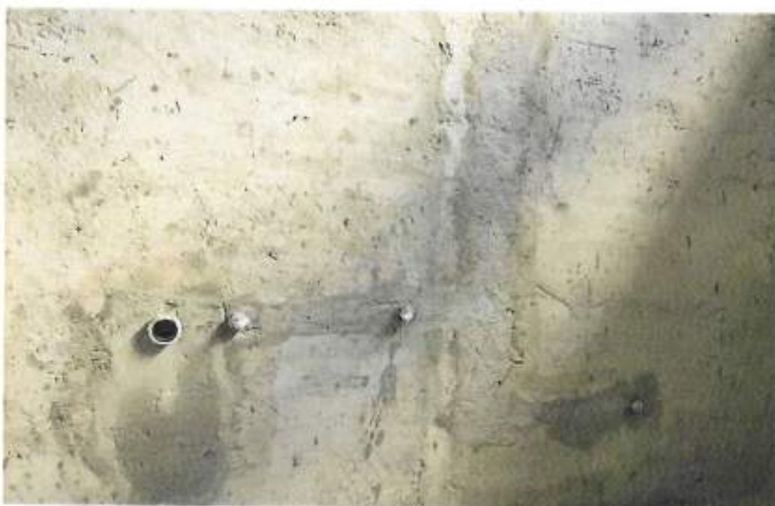
Foto 20 – Emboço para recebimento de cerâmica na parede interna – data: 31/08/2022
