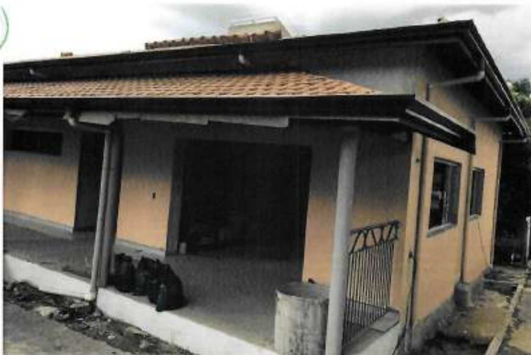
Foto 13 – Aplicação de fundo selador e latéx em paredes externas – data: 19/10/2022
