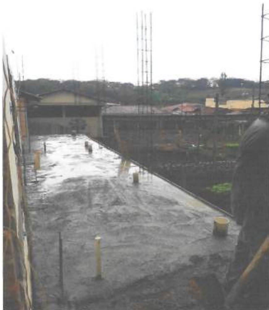
Foto 03 – Concretagem laje de piso da área de expansão – data: 05/10/2021
