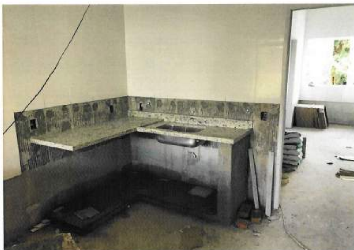
Foto 08 – Colocação da bancada de granito – data: 11/11/2022
