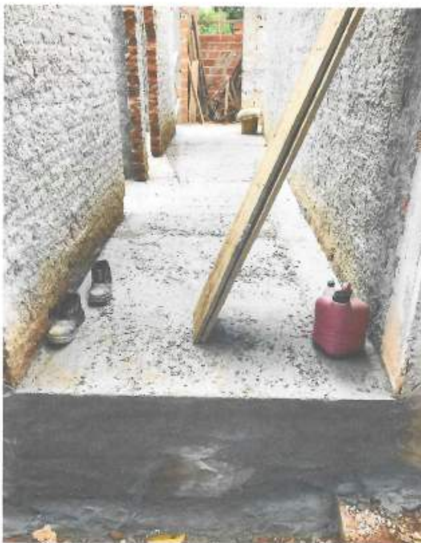
Foto 08 – Chapisco e concretagem do contrapiso – data: 18/01/2022
