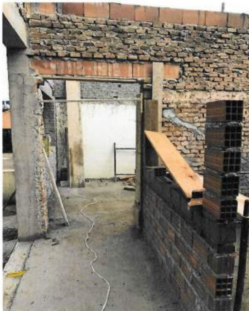
Foto 05 – Caixaria de pilar e concretagem – data: 11/02/2022
