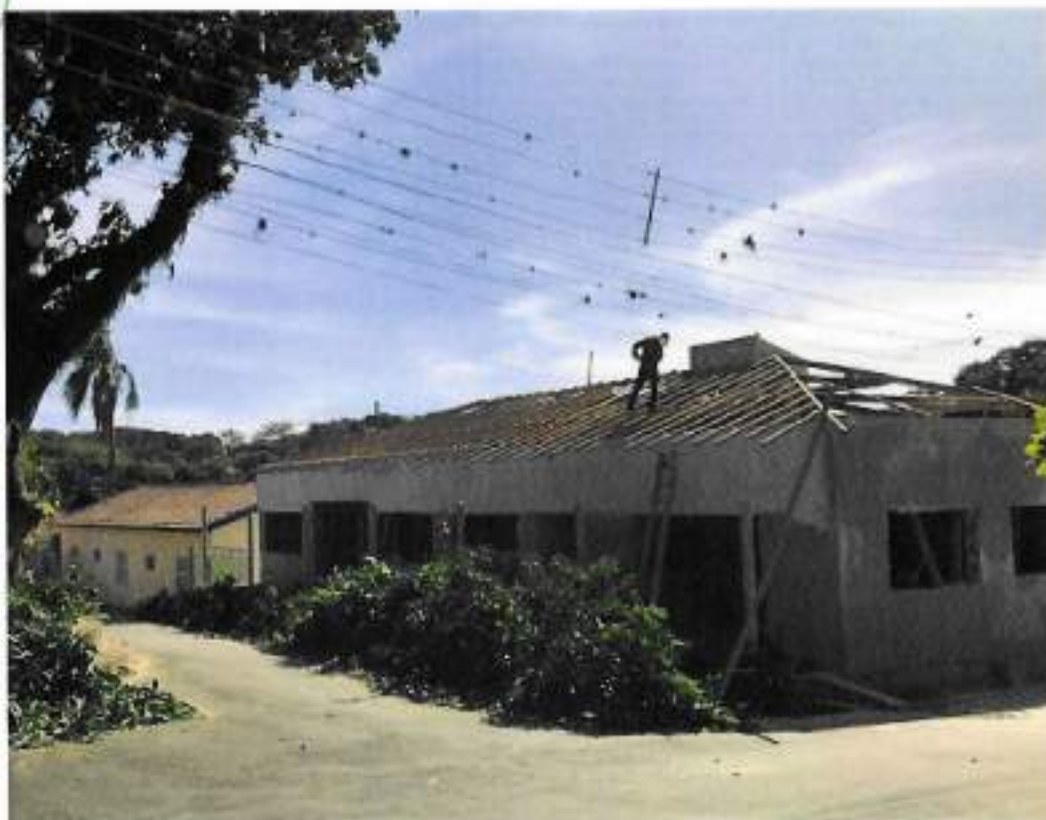
Foto 03 – Fabricação e Instalação de tesouras e caibros – data: 05/07/2022
