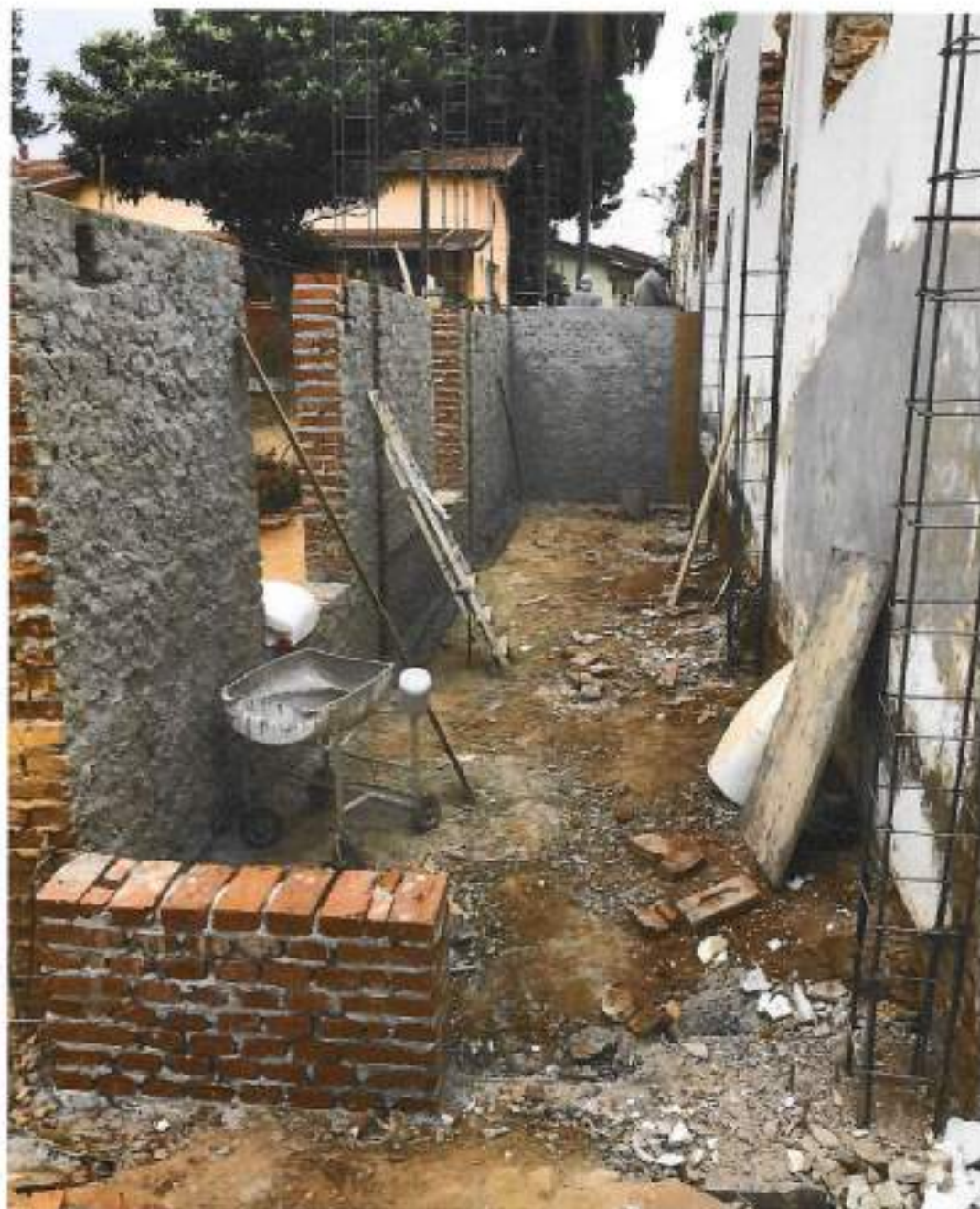
Foto 06 – Chapisco interno e externo da parede externa – data: 06/09/2021
