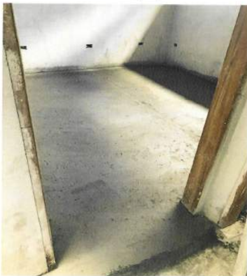
Foto 10 – Aplicação massa de nivelamento para piso cerâmico – data: 15/09/2022
