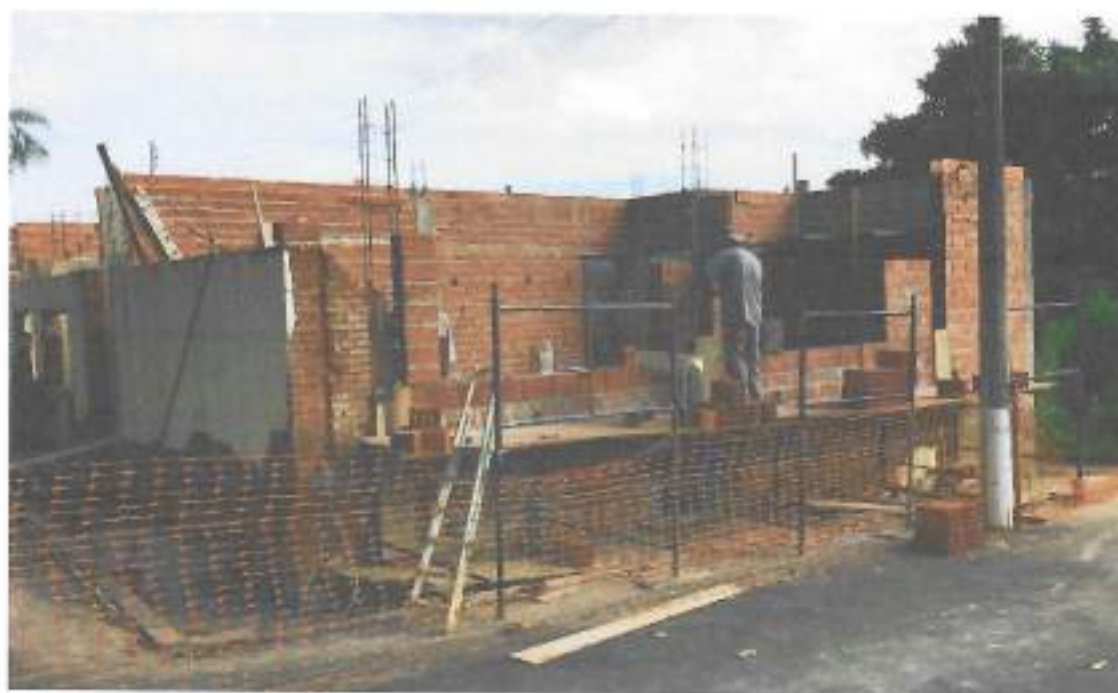
Foto 16 – Alvenaria de vedação de blocos furados – data: 22/12/2021
