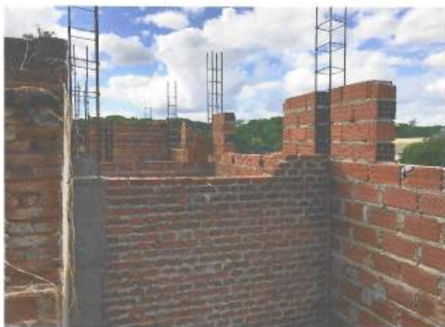
Foto 01 – Armação de pilar e concretagem – data: 01/11/2021
