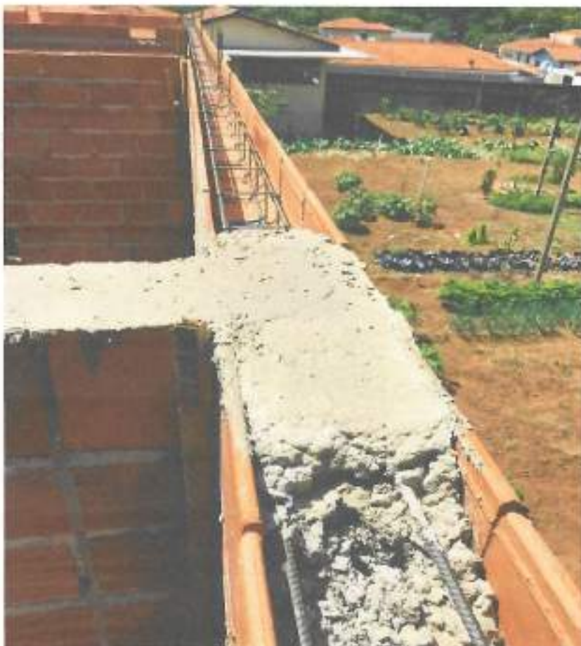
Foto 05 – Armação e concretagem de canaletas – data: 06/12/2021
