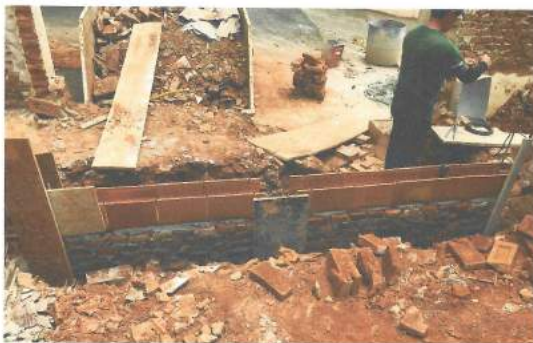
Foto 18 – Alvenaria baldrame e canaletas – data: 26/01/2022
