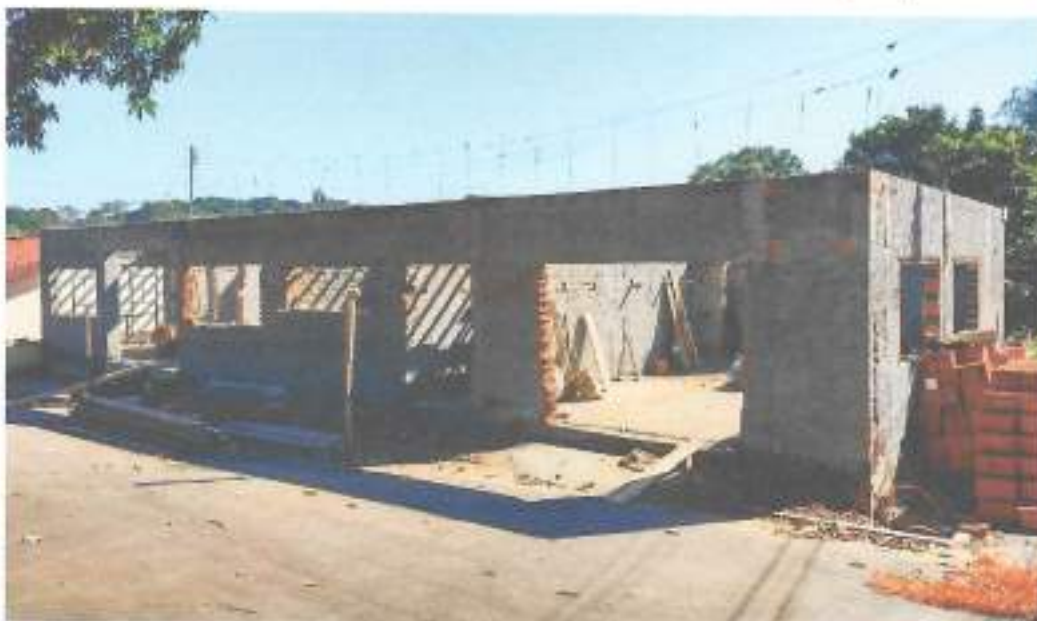
Foto 20 – Alvenaria de vedação e chapisco – data: 31/01/2022
