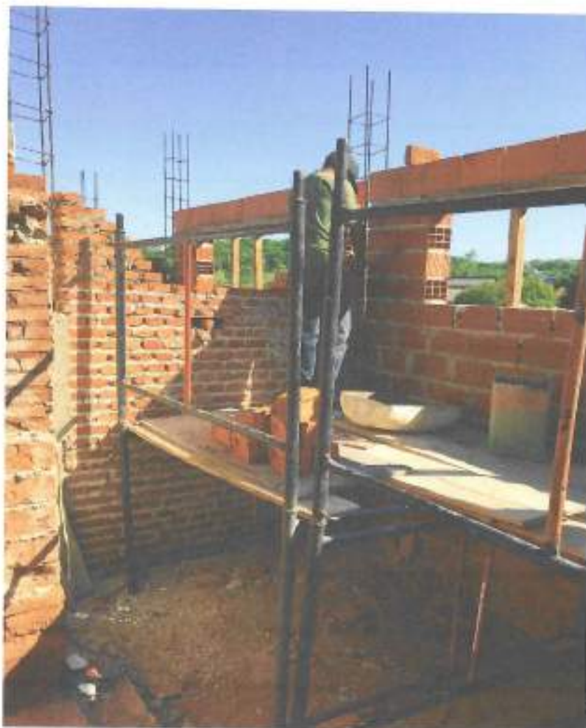
Foto 05 – Armação de pilar, concretagem e alvenaria de vedação – data: 09/11/2021
