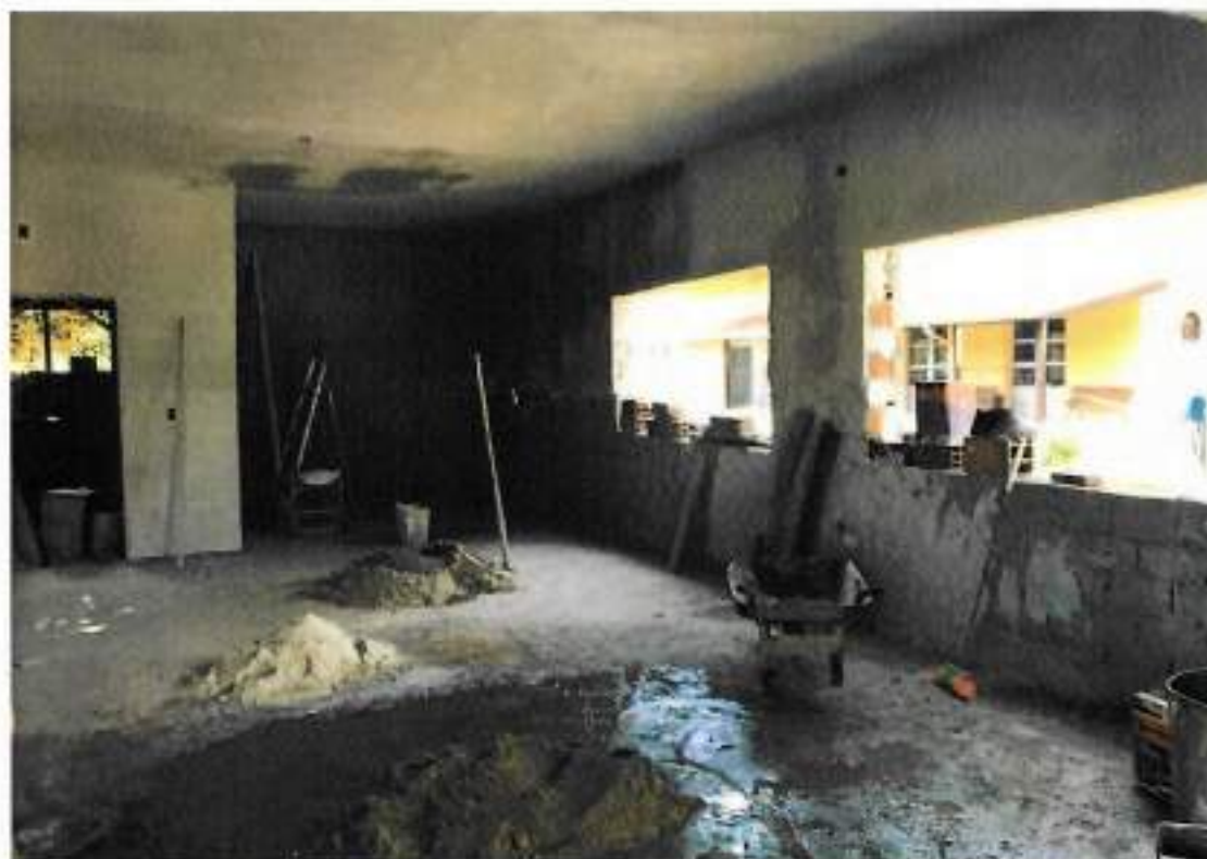
Foto 06 – Aplicação de argamassa em paredes internas– data: 08/06/2022
