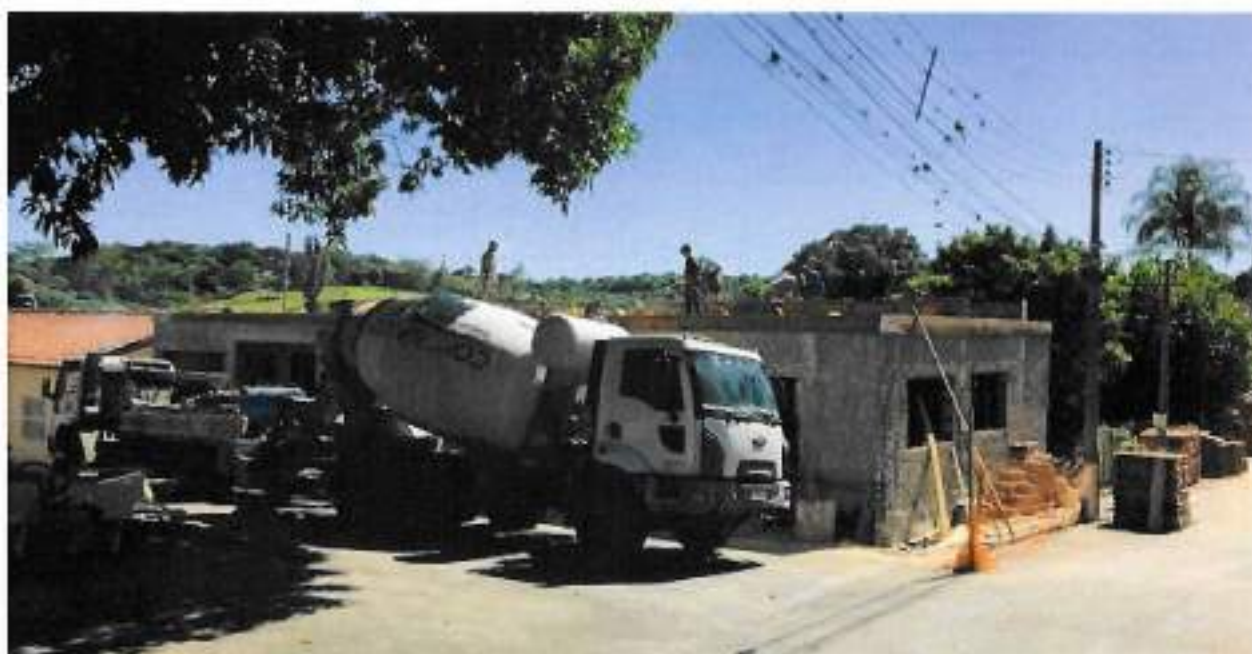
Foto 16 – Concretagem de vigas e laje – data: 23/03/2022
