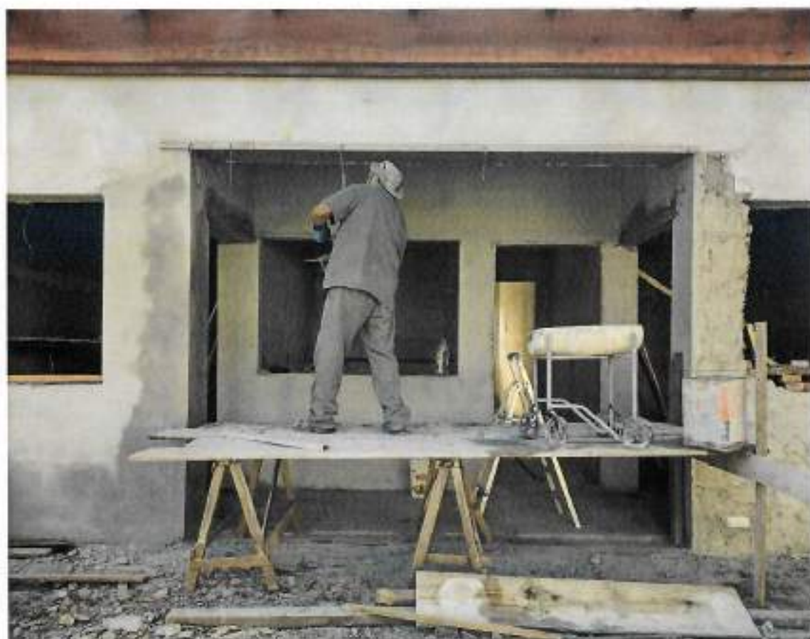
Foto 14 – Aplicação de argamassas – data: 26/07/2022
