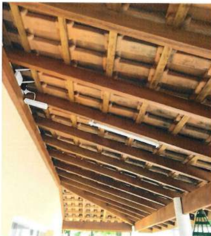
Foto 11 – Colocação de luminárias e luzes de emergência – data: 14/12/2022
