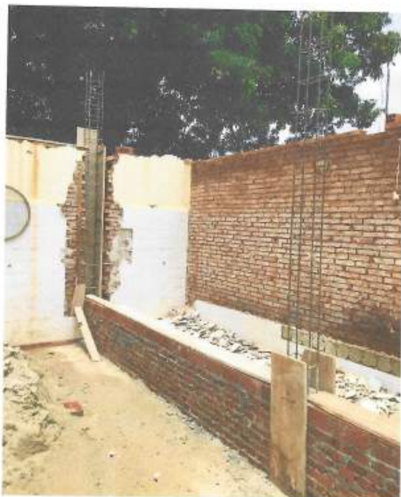
Foto 15 – Alvenaria baldrame da parede corredor – data: 26/11/2021
