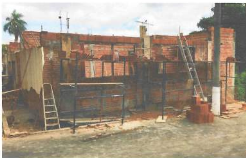
Foto 18 – Alvenaria de vedação, canaletas e pilar – data: 22/12/2021
