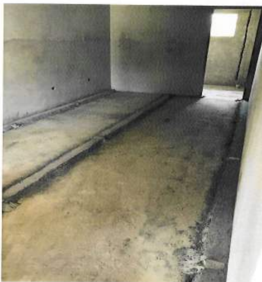
Foto 16 – Aplicação massa de nivelamento para piso cerâmico – data: 29/08/2022
