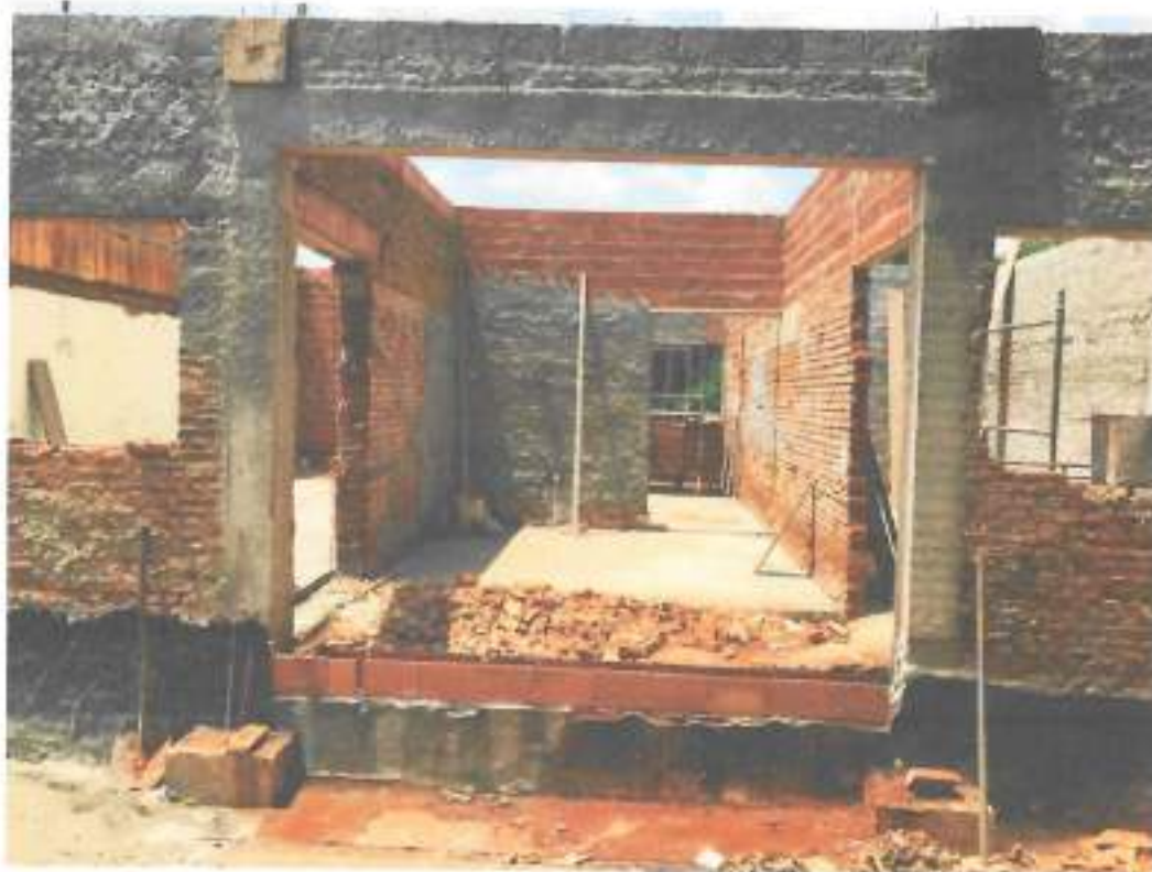
Foto 19 – Alvenaria baldrame e canaletas – data: 27/01/2022
