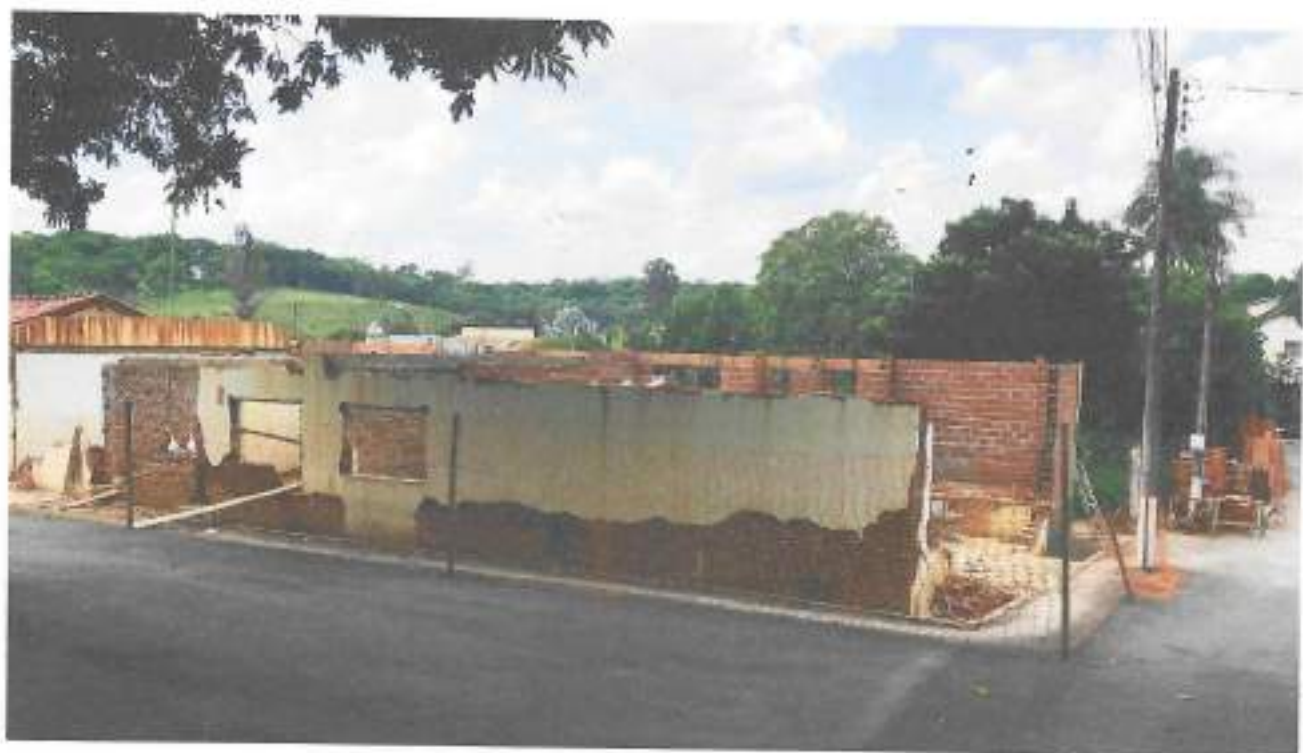
Foto 08 – Armação de pilar, concretagem e alvenaria de vedação – data: 12/11/2021
