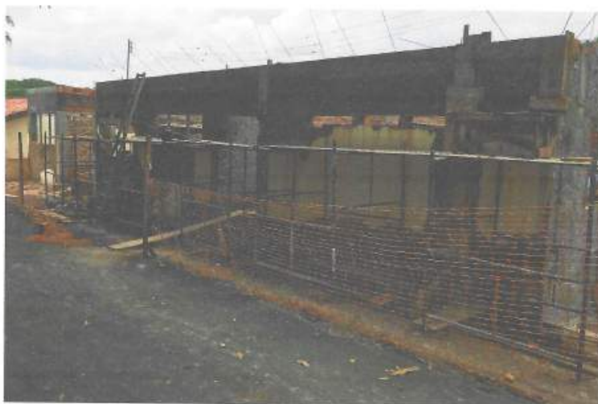
Foto 04 – Alvenaria de vedação, verga e contraverga – data: 10/01/2022
