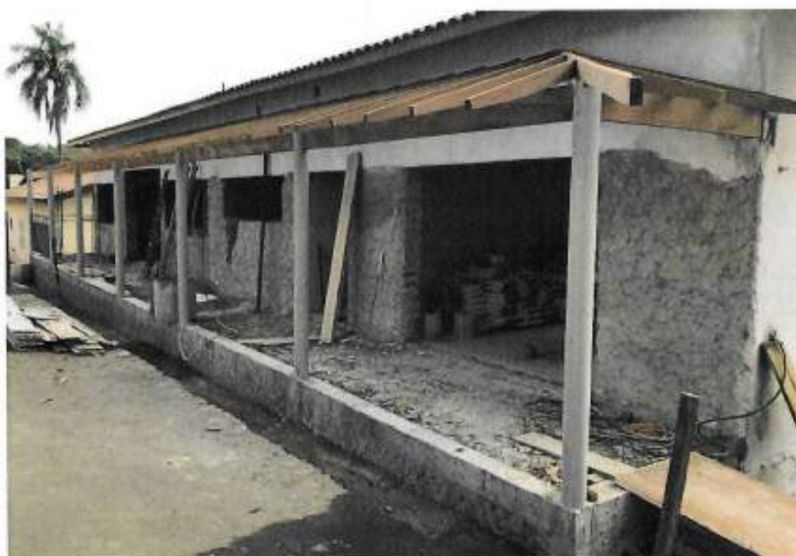
Foto 08 – Fabricação e instalação do telhado do terraço frontal – data: 14/07/2022
