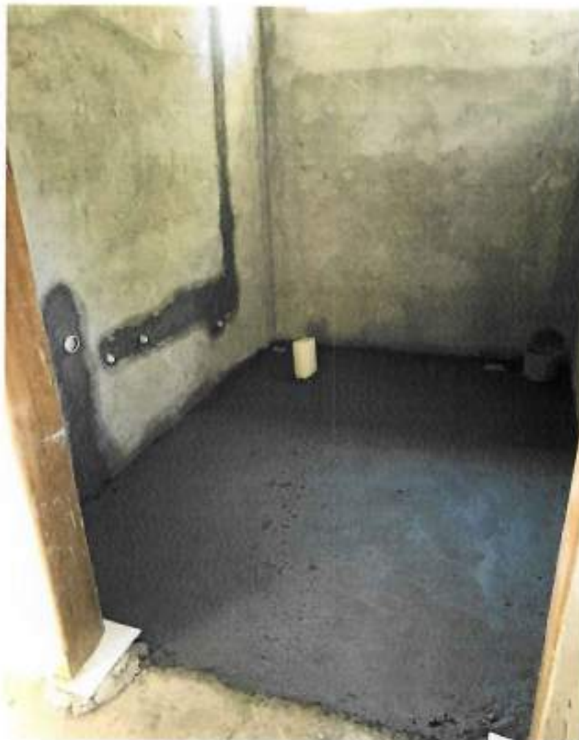
Foto 15 – Aplicação massa de nivelamento para piso cerâmico – data: 20/09/2022
