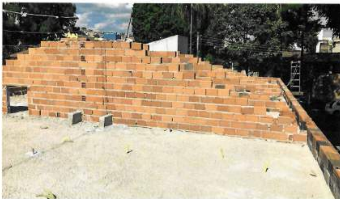
Foto 13 – Alvenaria de bloco furado da cobertura – data: 22/04/2022
