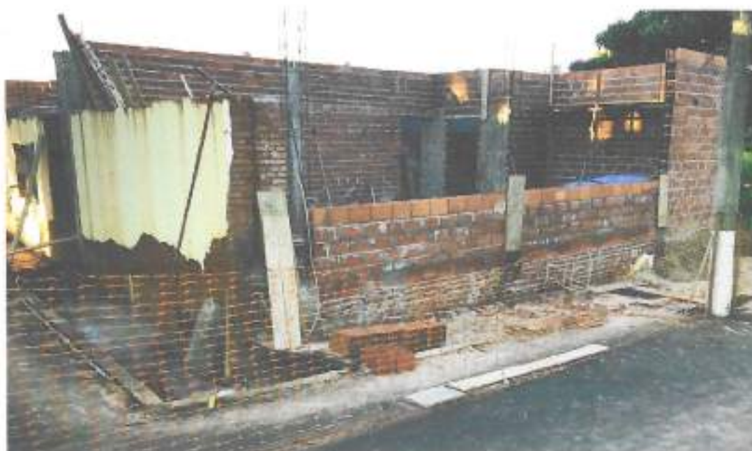
Foto 14 – Alvenaria de vedação de blocos furados – data: 19/12/2021
