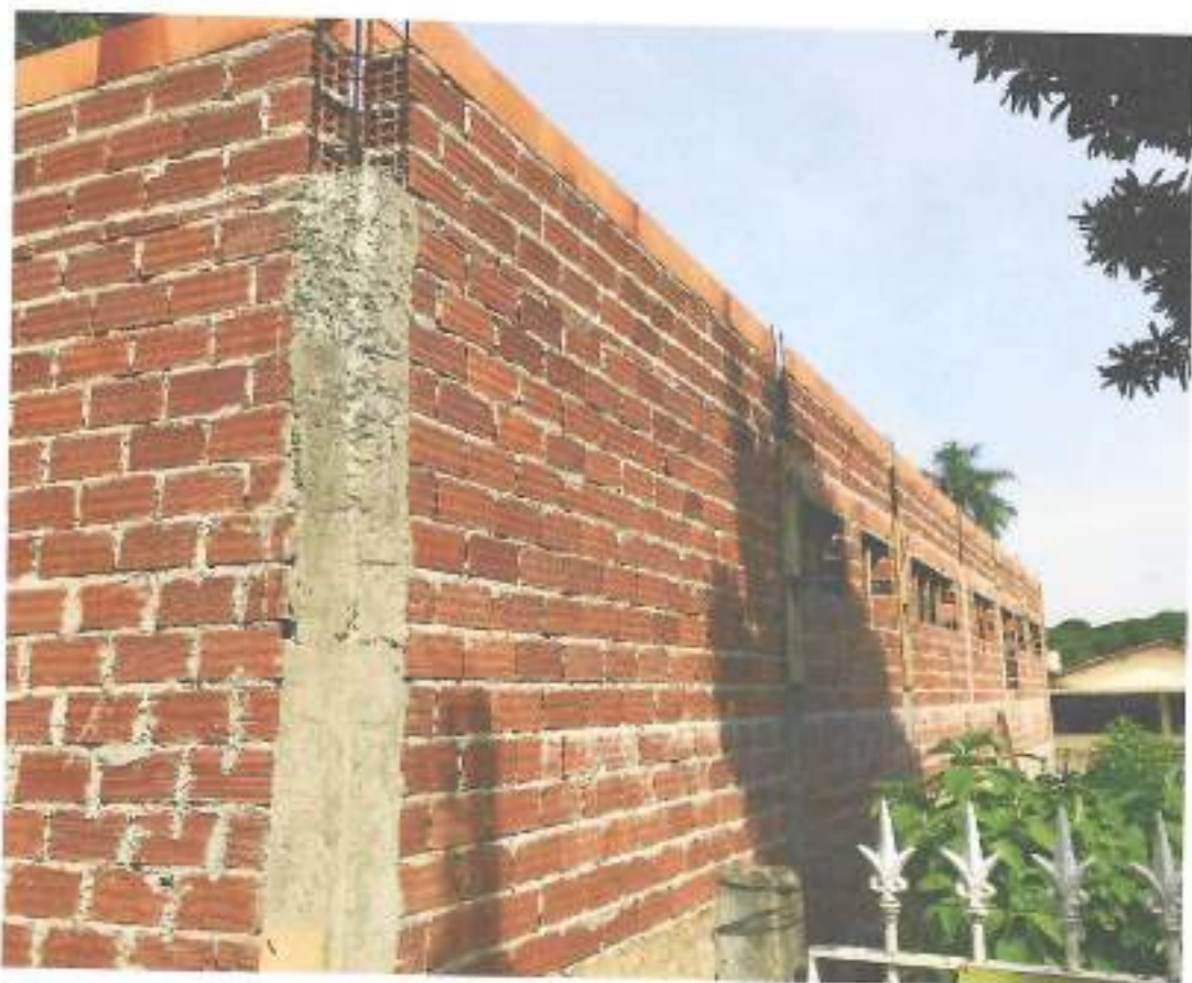
Foto 18 – Alvenaria de vedação e canaletas – data: 30/11/2021
