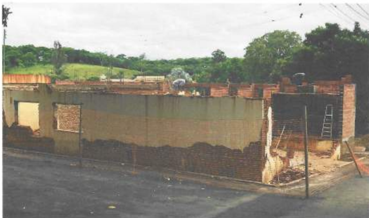
Foto 12 – Alvenaria de vedação e verga moldada de canaletas – data: 22/11/2021
