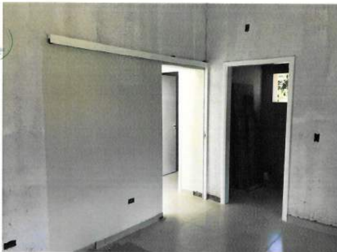
Foto 09 – Aplicação de fundo selador de paredes e esmalte em madeira – data: 14/11/2022
