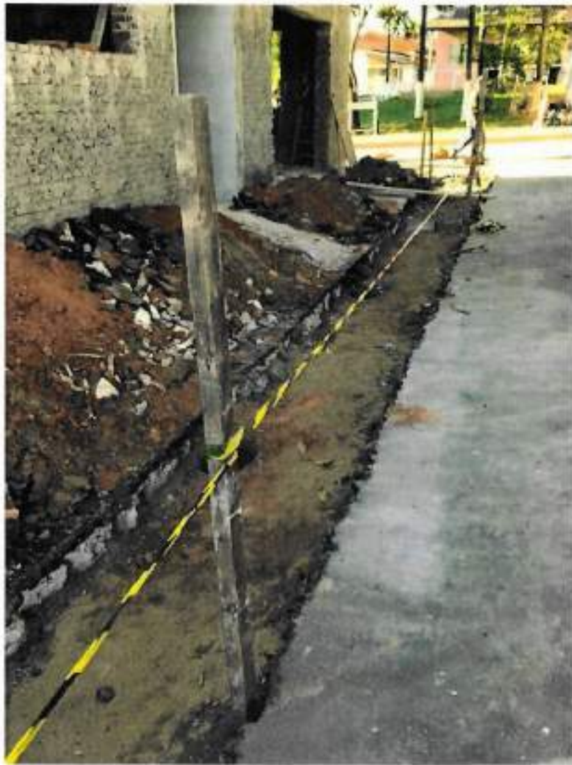
Foto 13 – Abertura baldrame e brocas do terraço frontal – data: 24/05/2022
