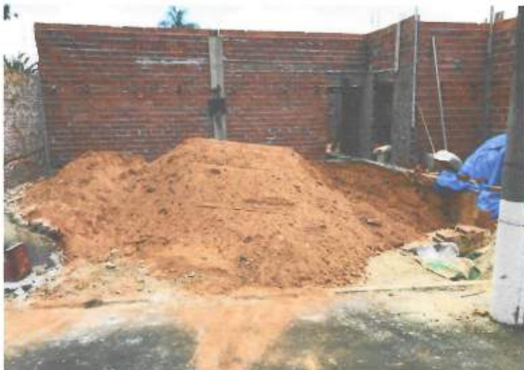
Foto 03 – Aterro de valas com solo e compactação – data: 04/12/2021
