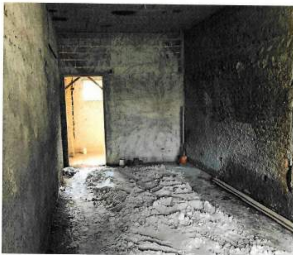
Foto 03 – Colocação de batente de porta e secagem areia argamassa – data: 04/05/2022
