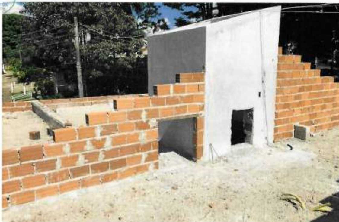
Foto 15 – Alvenaria de bloco furado da cobertura – data: 25/04/2022
