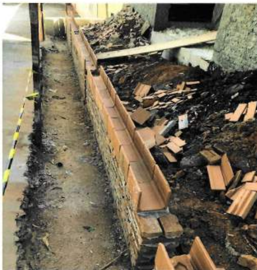
Foto 19 – Alvenaria do baldrame do terraço frontal – data: 30/05/2022
