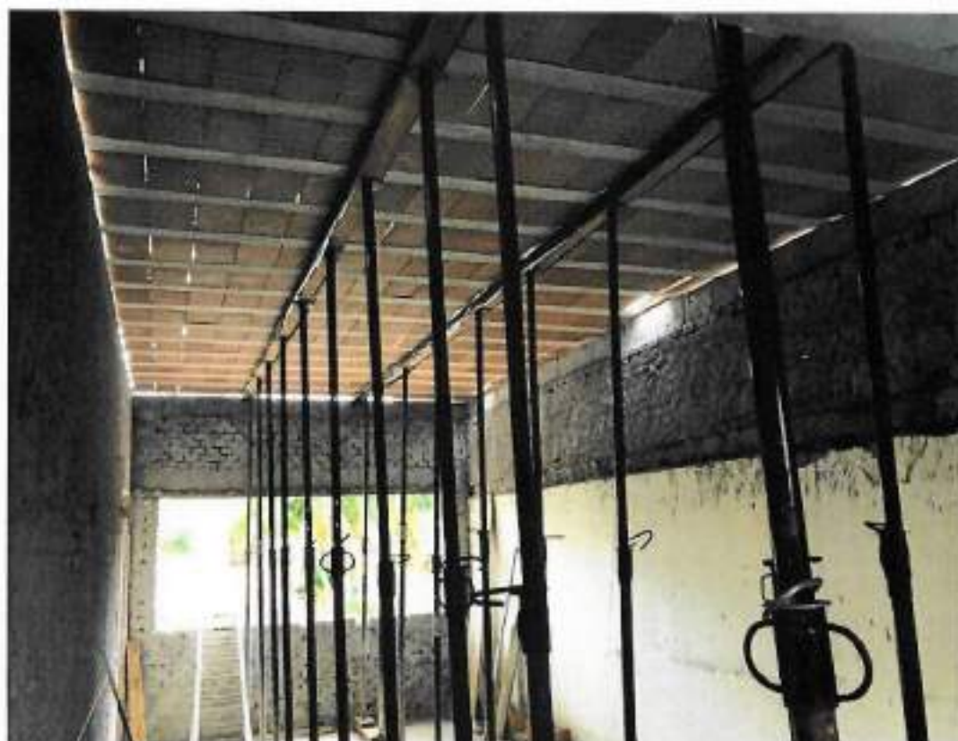
Foto 02 – Enchimento de laje com cerâmica – data: 03/03/2022
