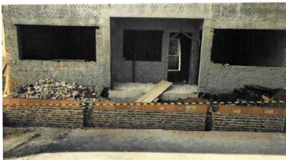
Foto 18 – Alvenaria do baldrame do terraço frontal – data: 30/05/2022
