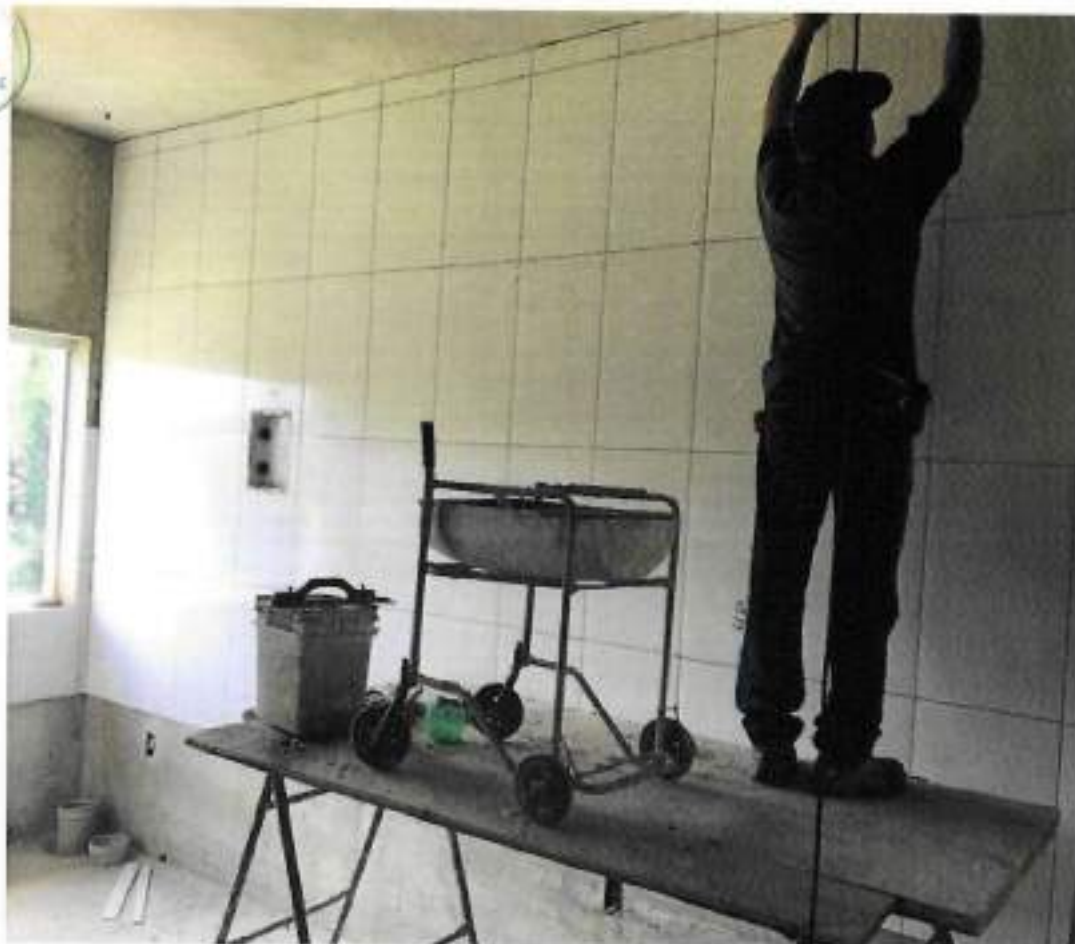
Foto 17 – Revestimento cerâmico para paredes internas – data: 26/10/2022
