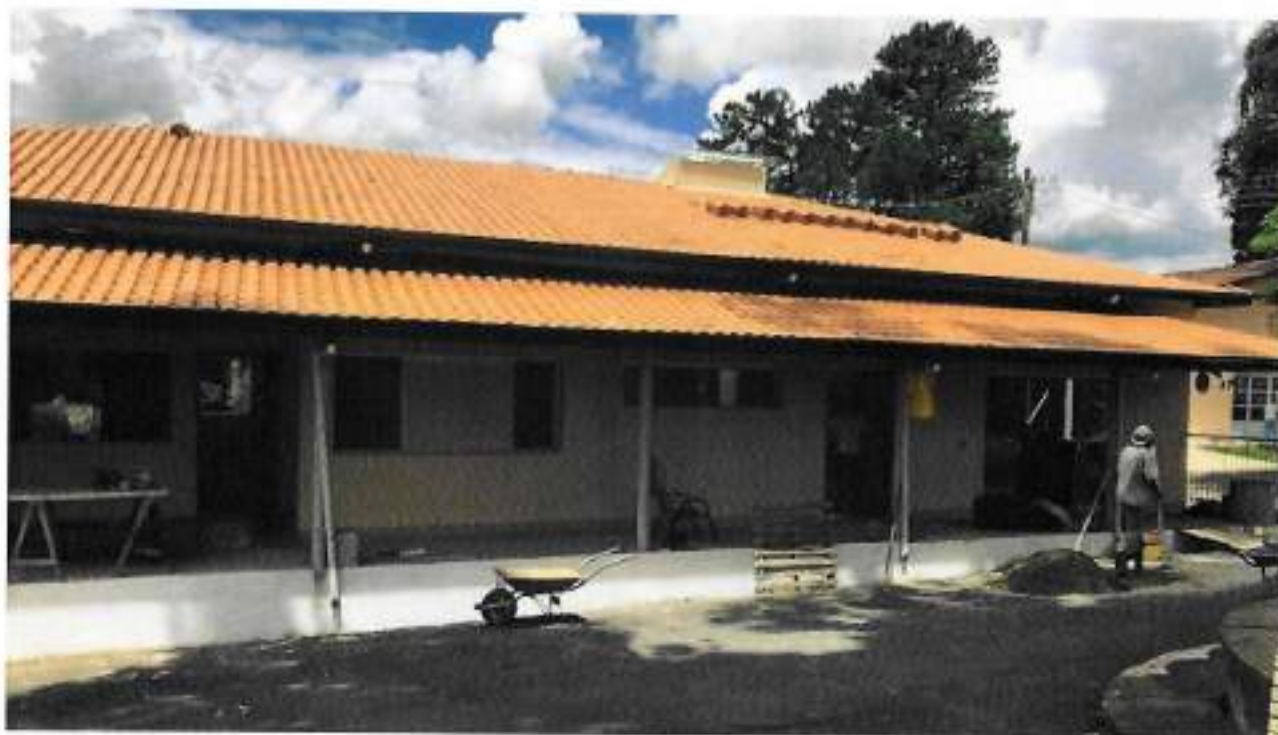
Foto 20 – Aplicação de fundo selador e latéx em paredes externas – data: 31/10/2022
