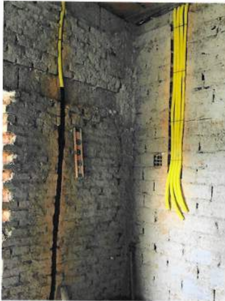
Foto 09 – Abertura para colocação de eletroduto e tubulação – data: 15/04/2022
