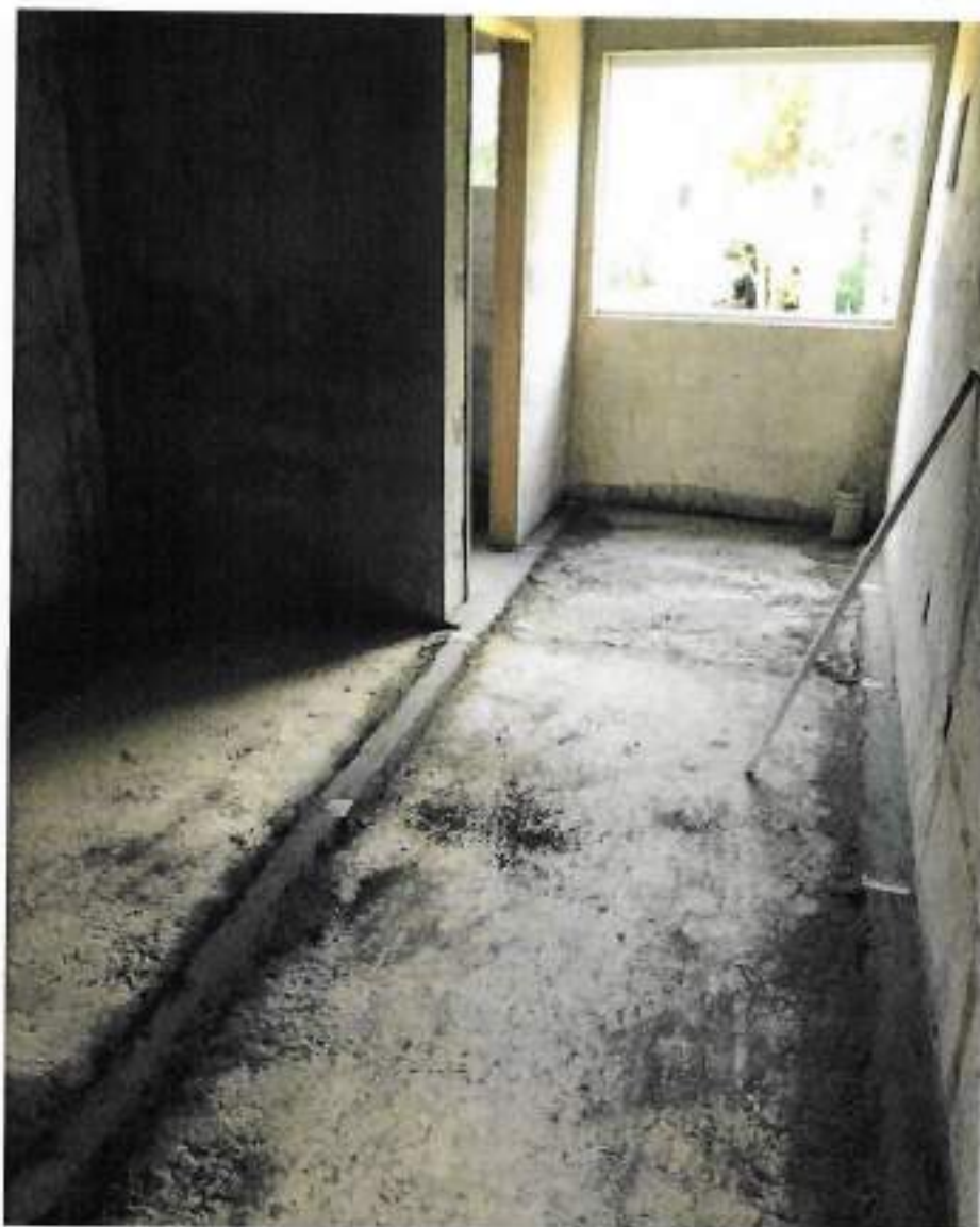
Foto 14 – Aplicação massa de nivelamento para piso cerâmico – data: 26/08/2022
