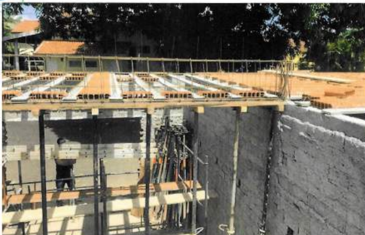
Foto 07 – Montagem de viga de sustentação da laje – data: 08/03/2022
