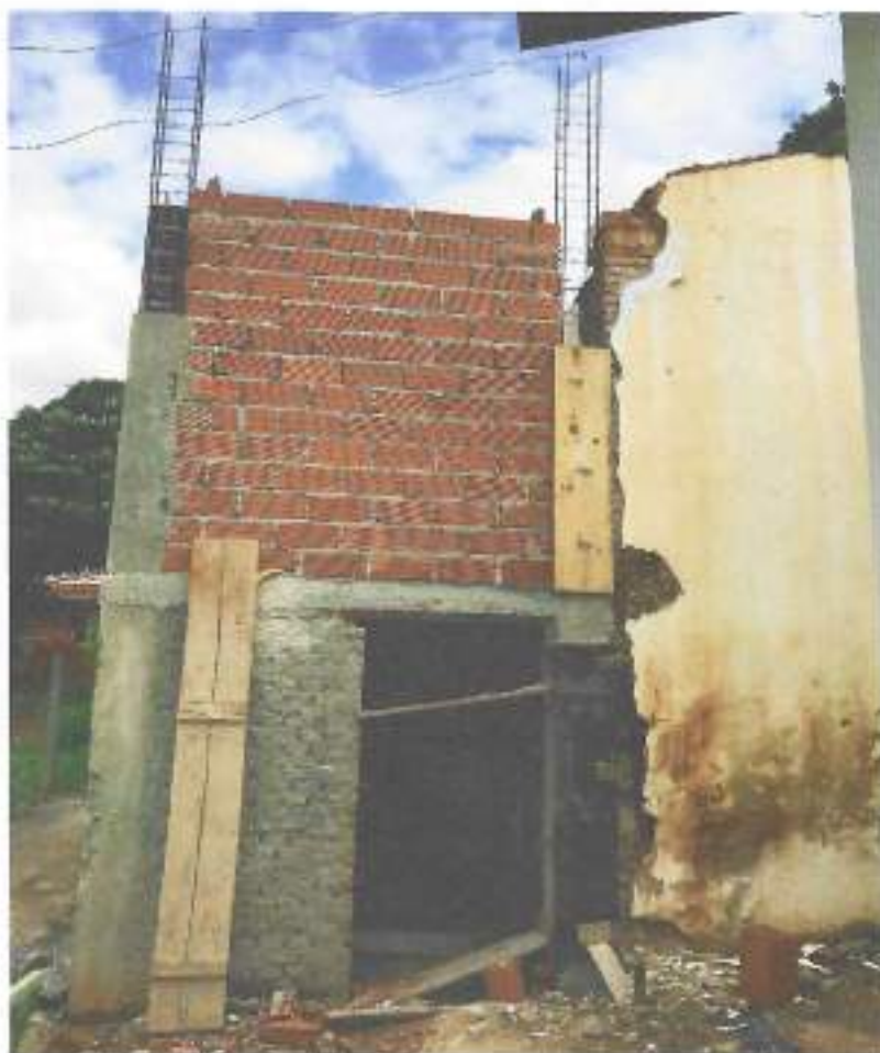
Foto 02 – Armação de pilar e concretagem – data: 03/11/2021
