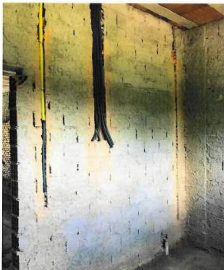
Foto 07 – Abertura para colocação de eletroduto e tubulação – data: 11/04/2022
