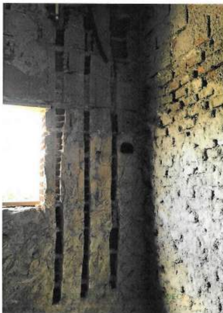
Foto 07 – Abertura para colocação de eletroduto e tubulação – data: 11/04/2022
