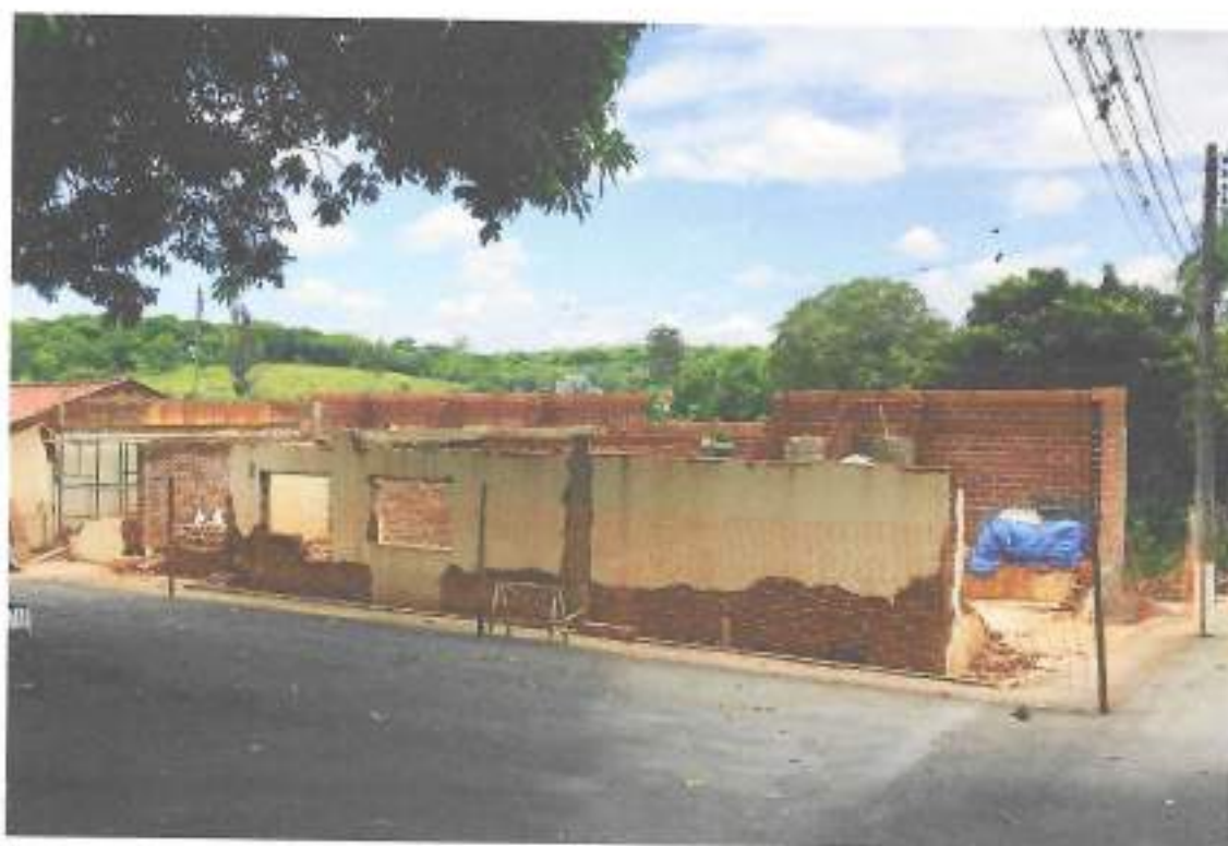
Foto 16 – Alvenaria de vedação e verga – data: 26/11/2021
