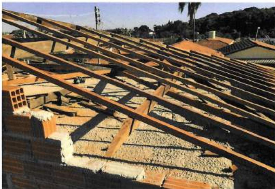
Foto 14 – Fabricação e Instalação de tesouras e caibros – data: 24/06/2022
