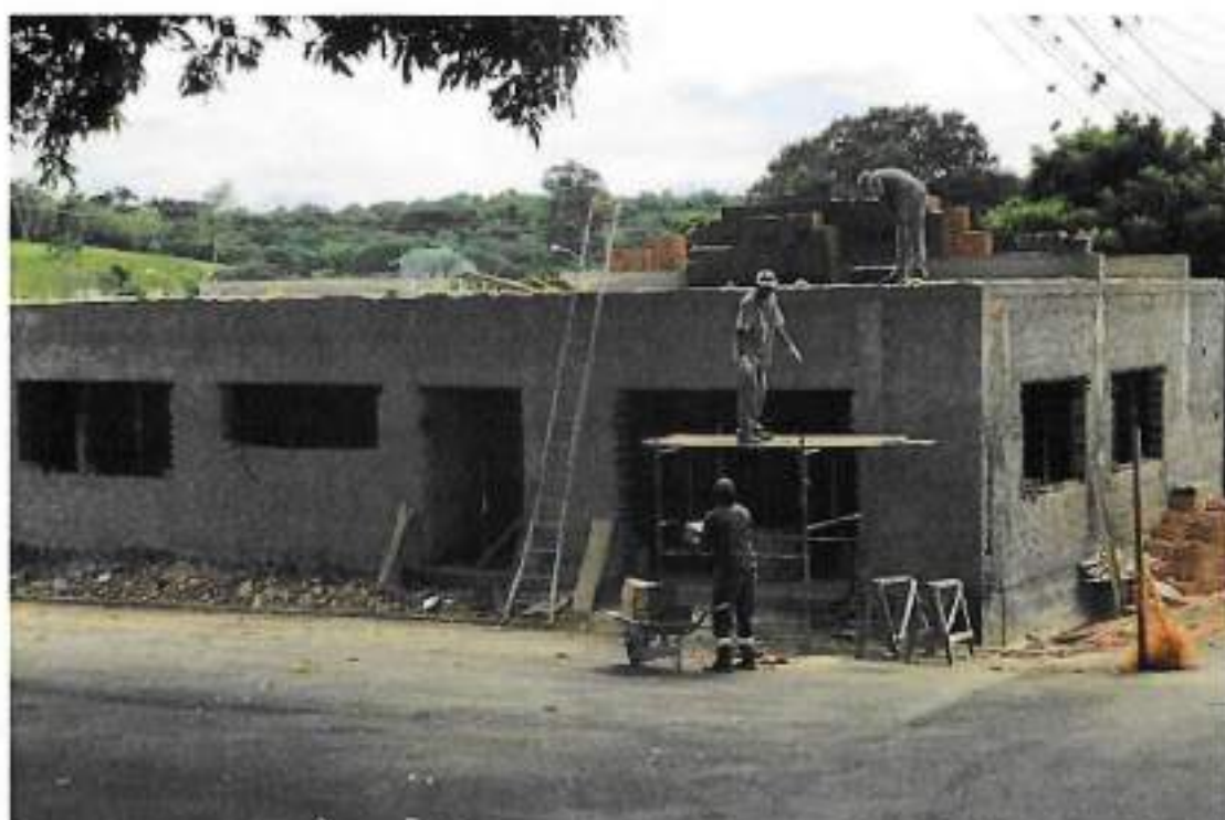
Foto 20 – Elevação manual de blocos cerâmicos furados – data: 31/03/2022
