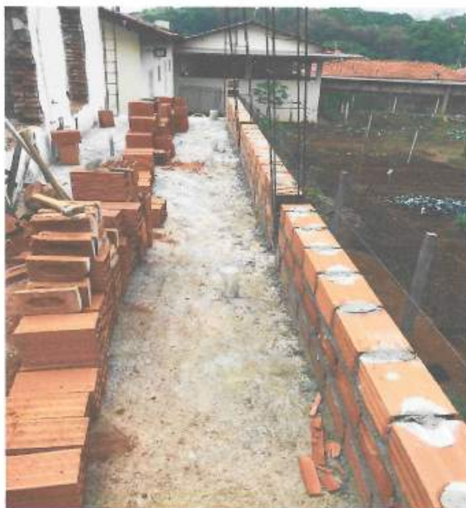
Foto 10 – Alvenaria de vedação de blocos furados – data: 14/10/2021
