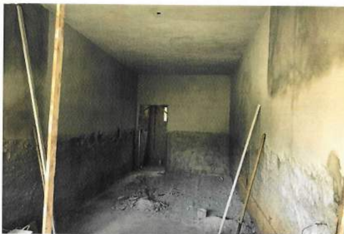
Foto 02 – Aplicação de argamassa em paredes internas – data: 03/08/2022
