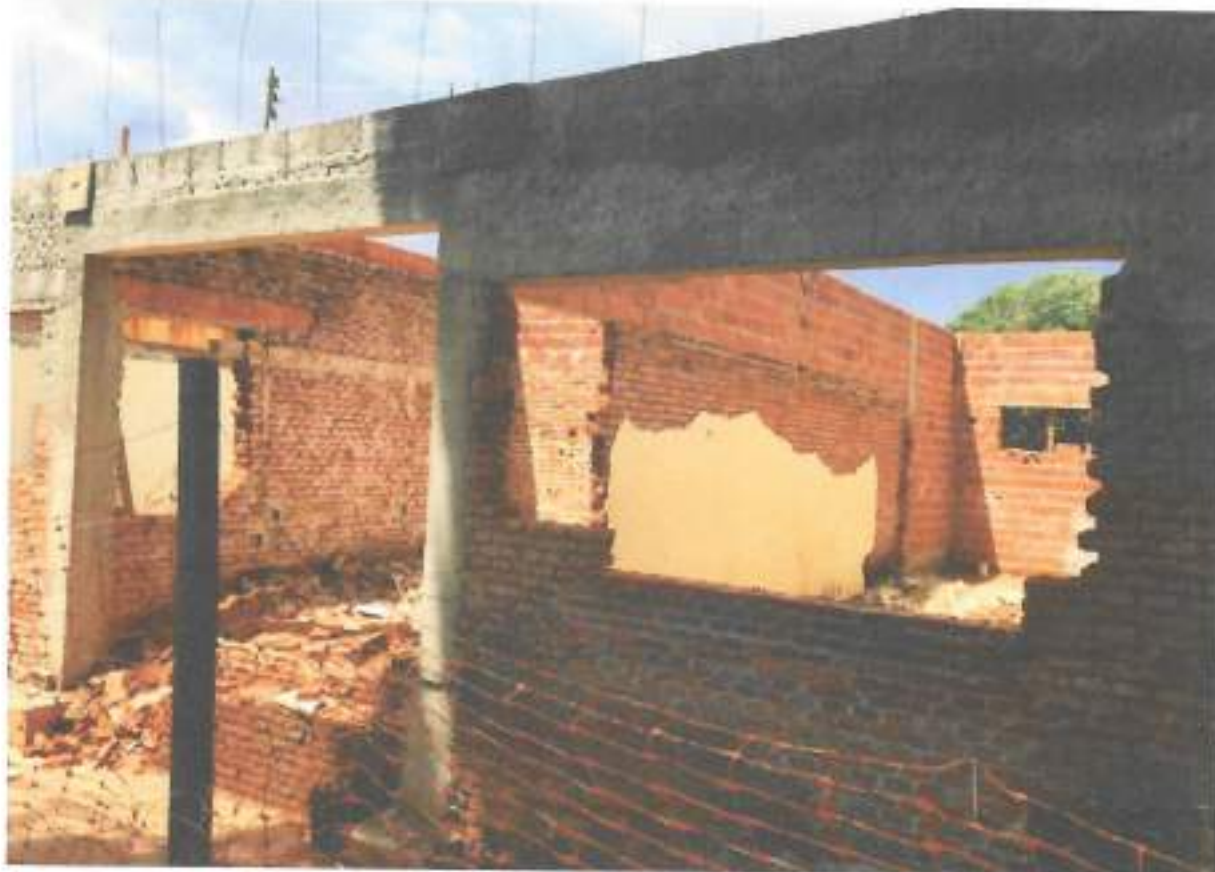
Foto 07 – Desmontagem caixaria e alvenaria de contraverga – data: 17/01/2022
