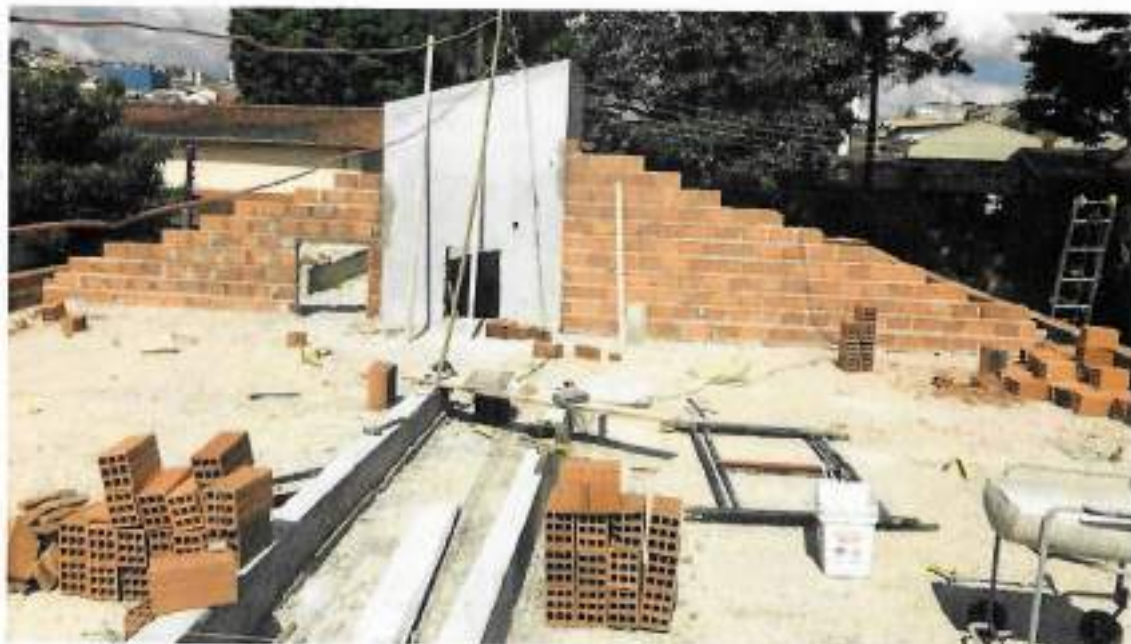
Foto 10 – Alvenaria de bloco furado da cobertura – data: 19/04/2022
