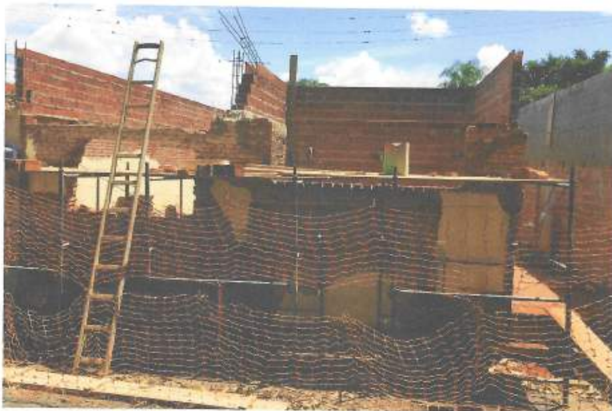
Foto 01 – Armação de pilar e concretagem – data: 04/01/2022
