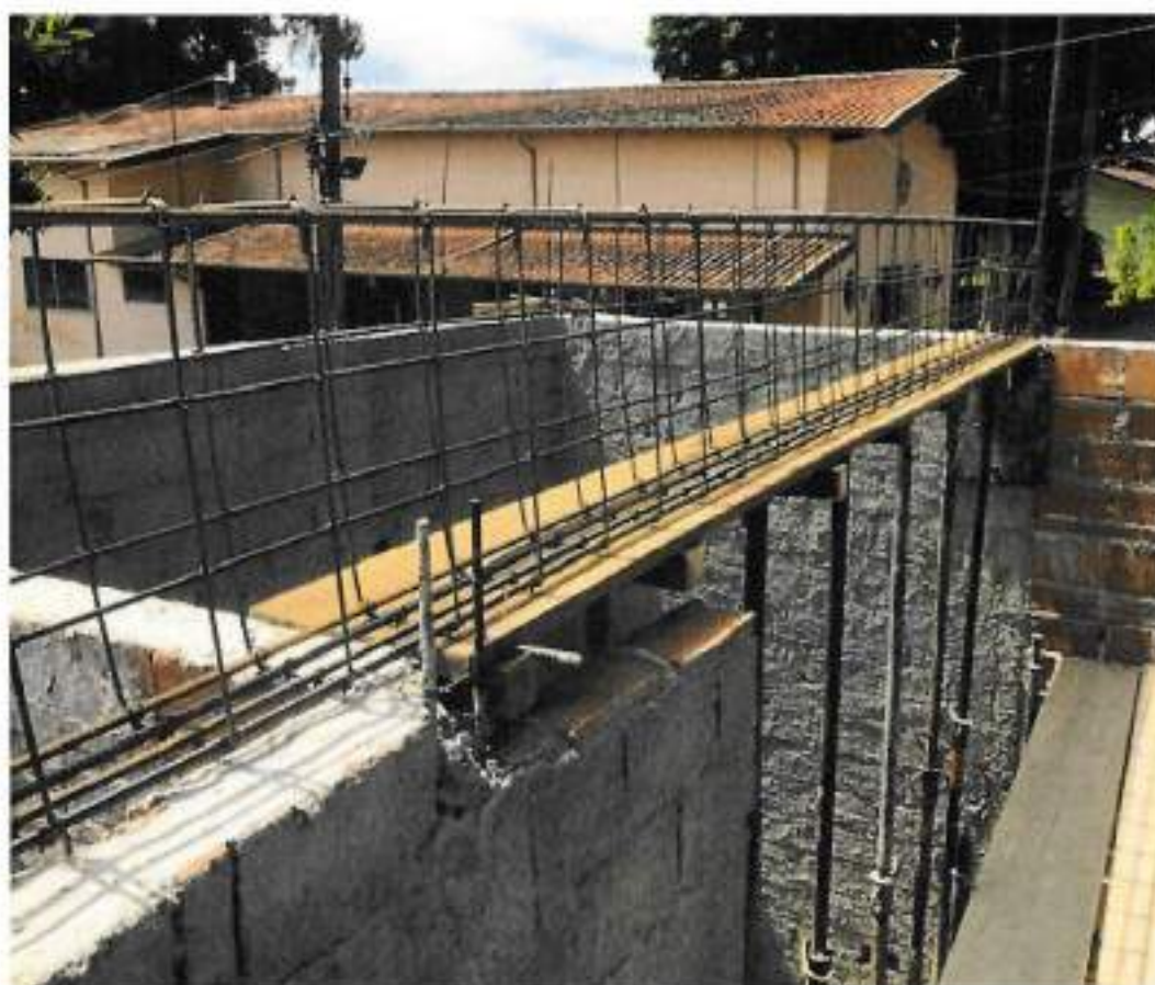
Foto 08 – Montagem de viga de sustentação da laje – data: 08/03/2022
