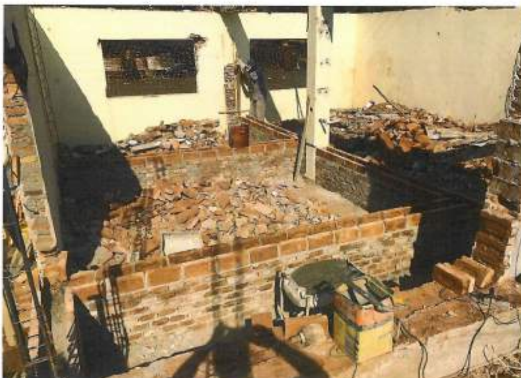
Foto 16 – construção do baldrame e canaletas de salas internas – data: 20/09/2021
