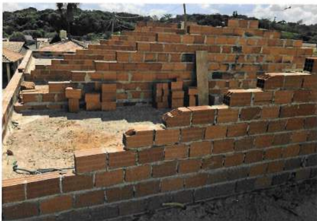
Foto 11 – Alvenaria de bloco furado da cobertura – data: 20/04/2022
