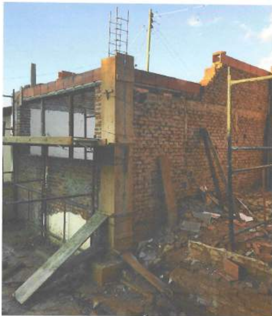
Foto 15 – Concretagem de pilar e canaleta da janela – data: 21/12/2021
