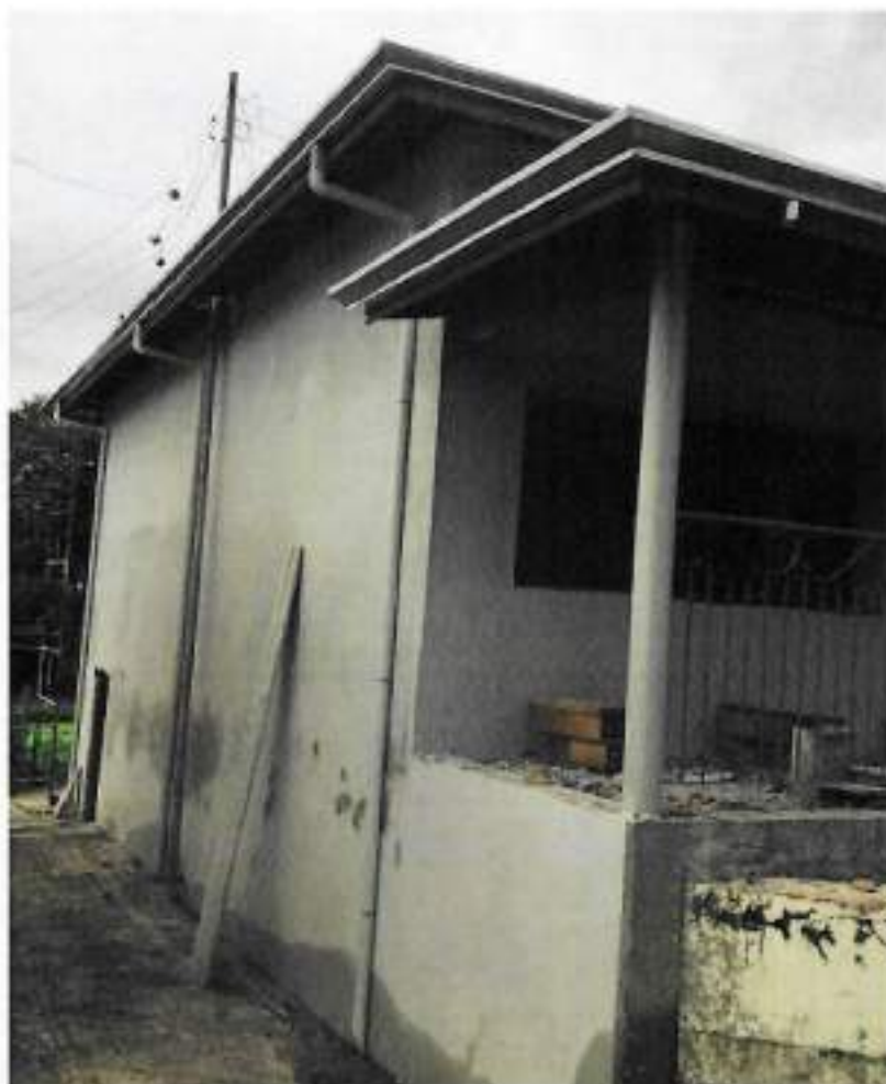
Foto 19 – Colocação de calhas de beiral, bocais e transportes verticais – data: 29/07/2022
