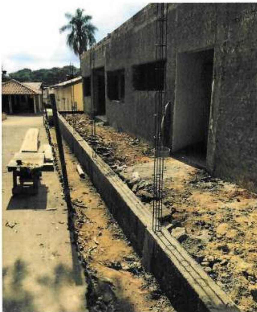
Foto 05 –Concretagem de canaletas do terraço frontal – data: 06/06/2022
