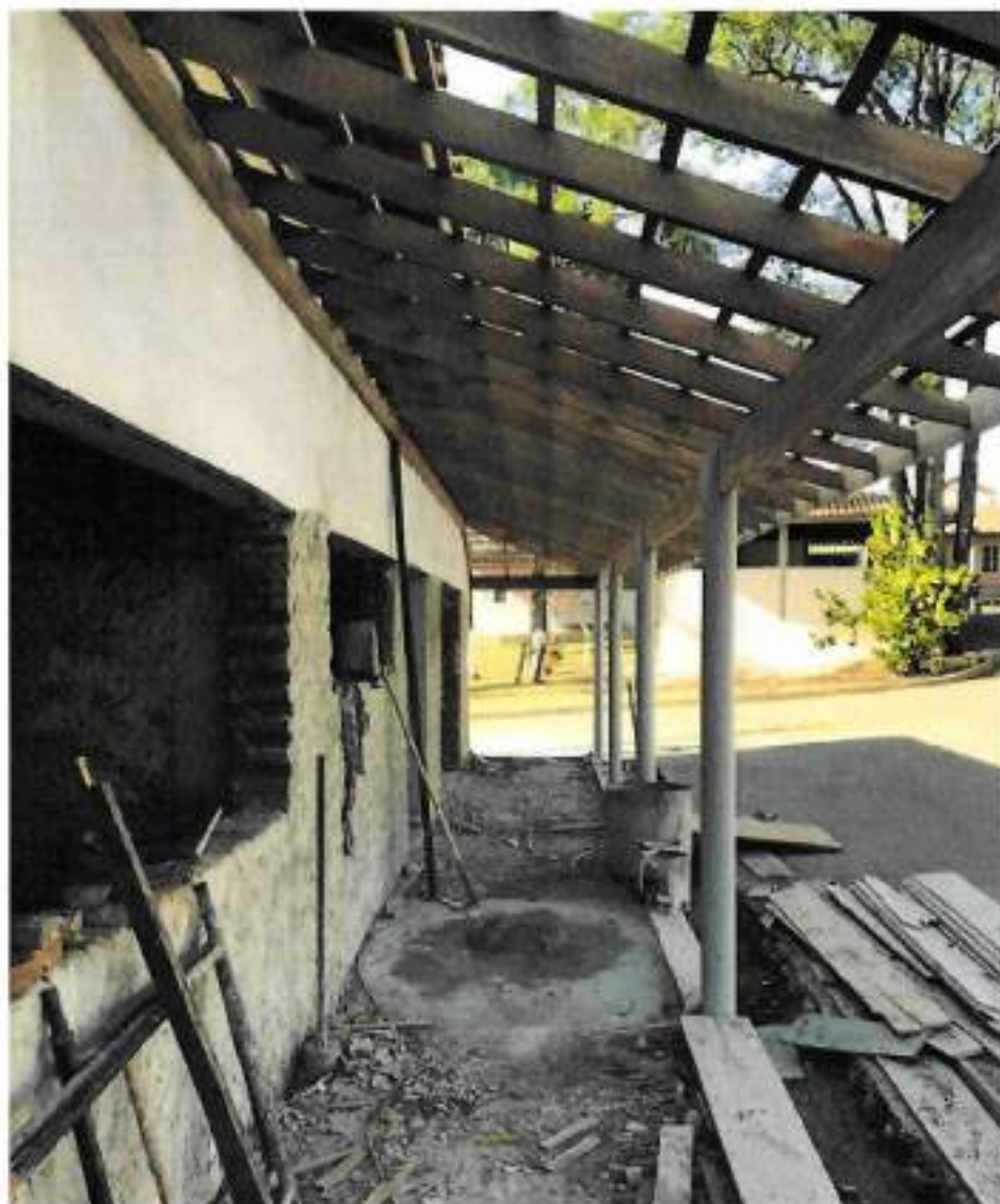
Foto 09 – Fabricação e instalação do telhado do terraço frontal – data: 15/07/2022
