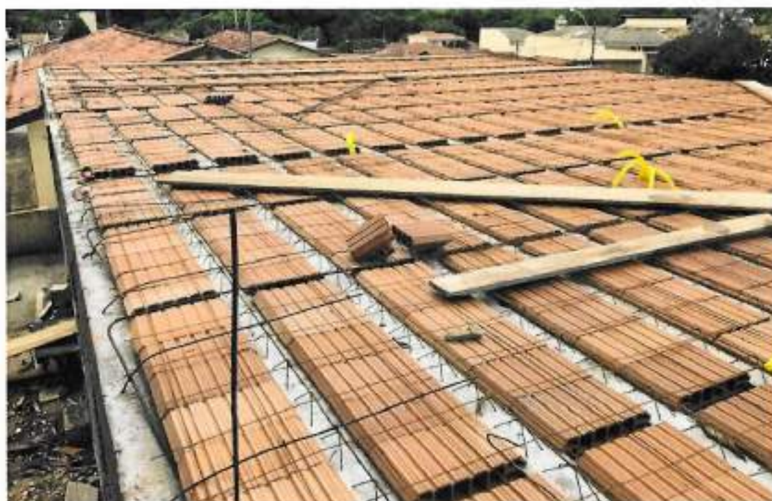
Foto 10 – Enchimento de laje com cerâmica e ferragens – data: 14/03/2022
