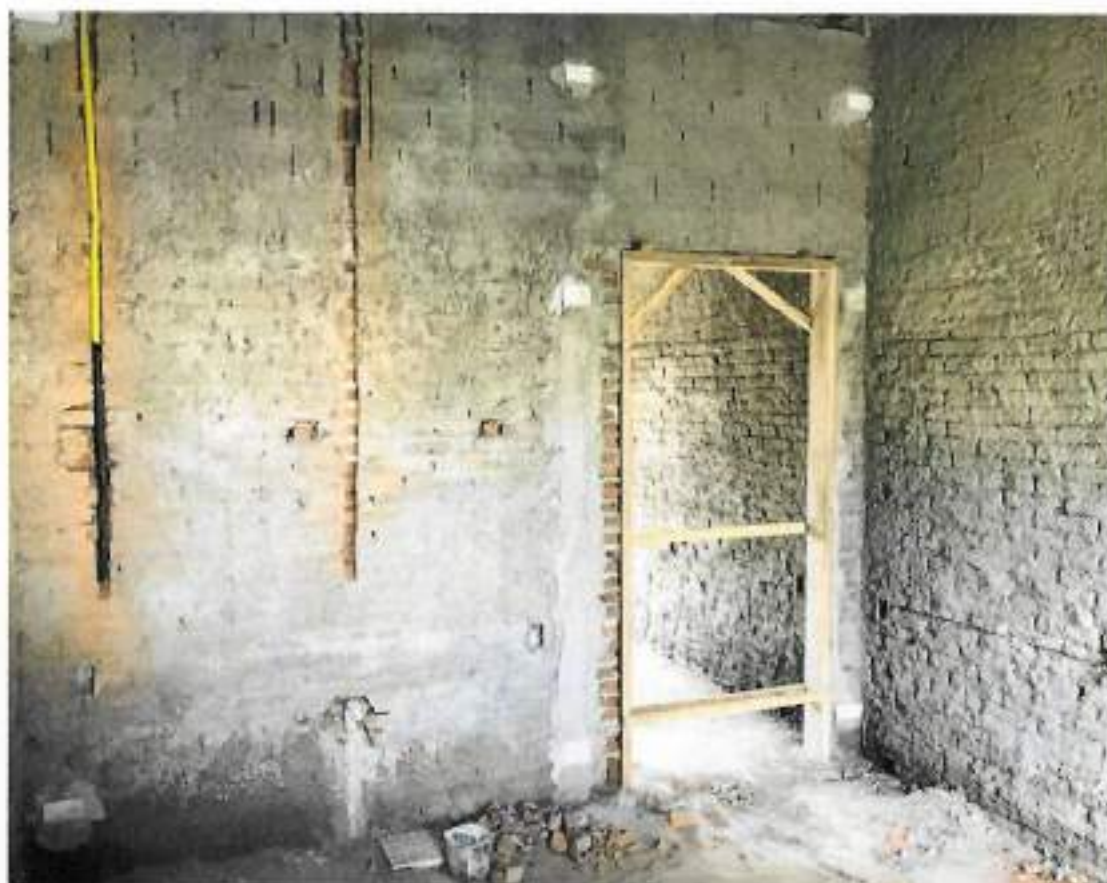
Foto 20 – Colocação de batente de porta – data: 29/04/2022
