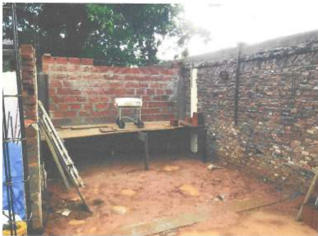
Foto 13 – Alvenaria de vedação de blocos furados – data: 25/10/2021
