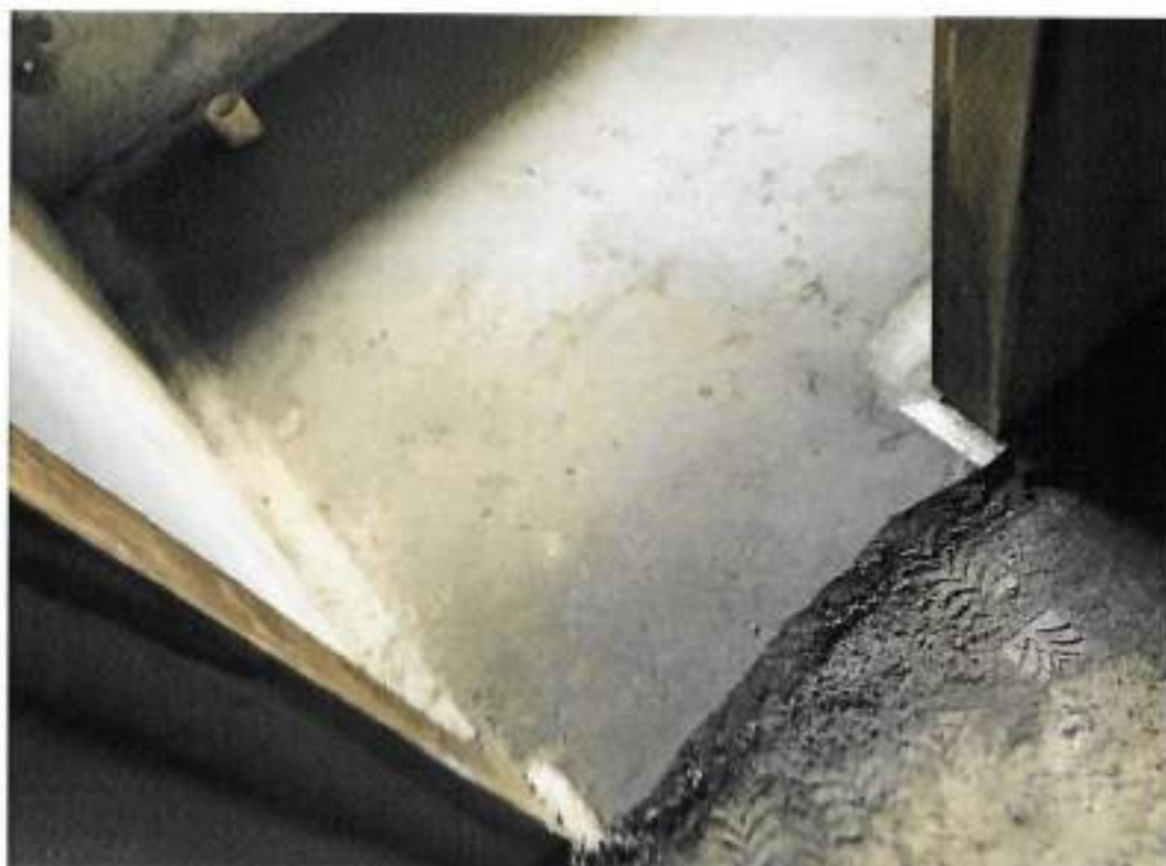
Foto 06 – Aplicação massa de nivelamento para piso cerâmico – data: 09/09/2022
