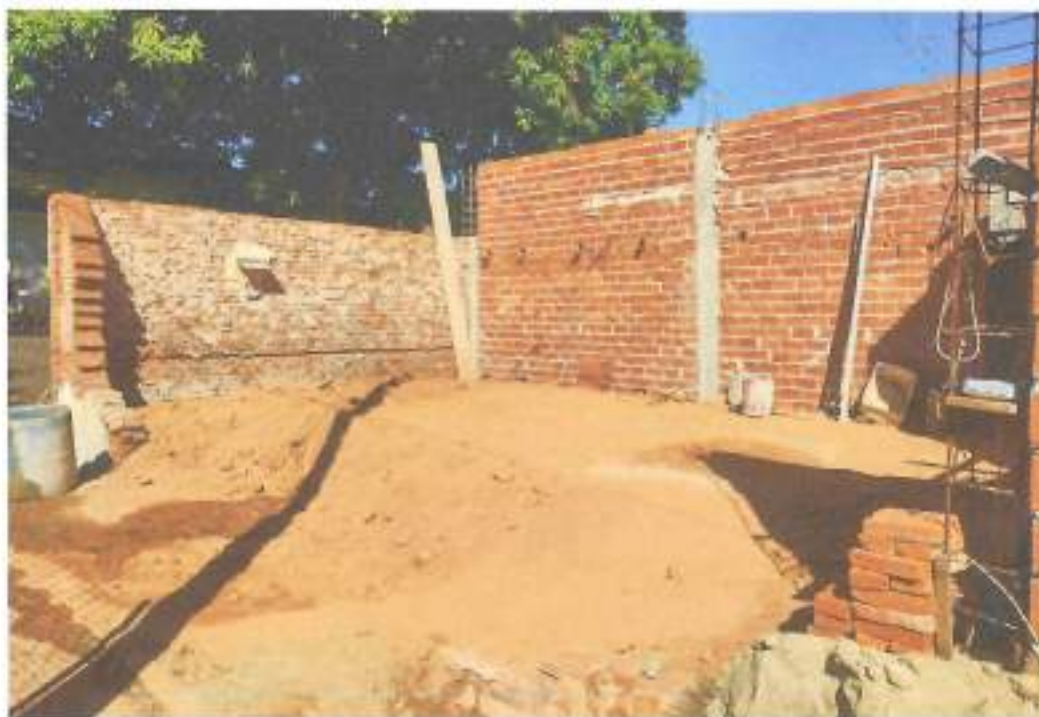
Foto 04 – Aterro de valas com solo e compactação – data: 04/12/2021
