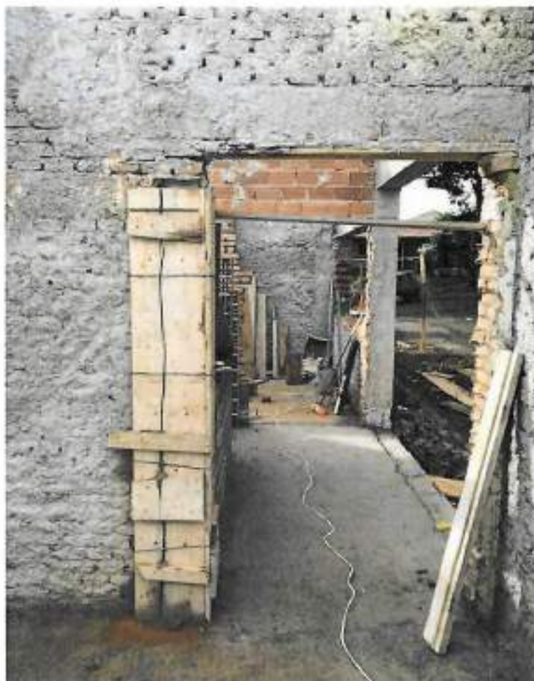
Foto 04 – Caixaria de pilar e concretagem – data: 10/02/2022
