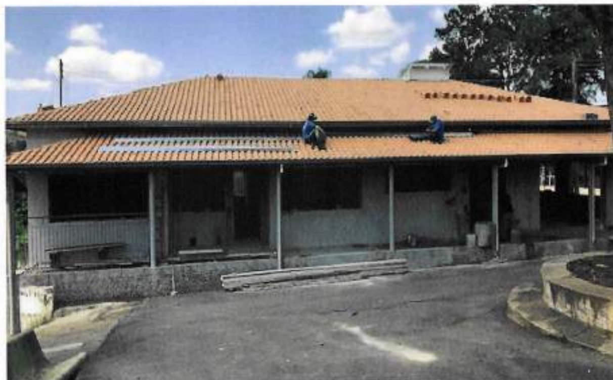
Foto 16 – Colocação de calhas de beiral – data: 28/07/2022
