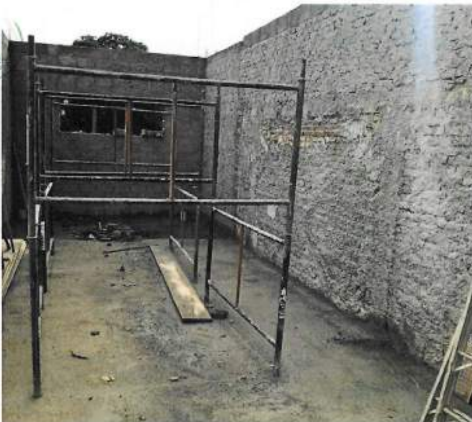
Foto 03 – Desmontagem de caixaria e chapisco – data: 08/02/2022
