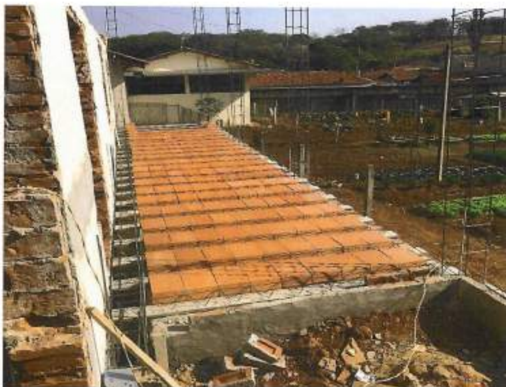
Foto 14 – colocação lajotas no piso da área expansão – data: 16/09/2021
