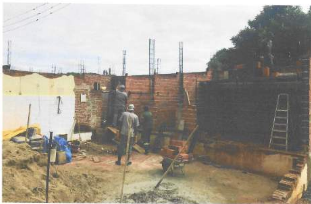
Foto 10 – Alvenaria de vedação de blocos furados – data: 18/11/2021
