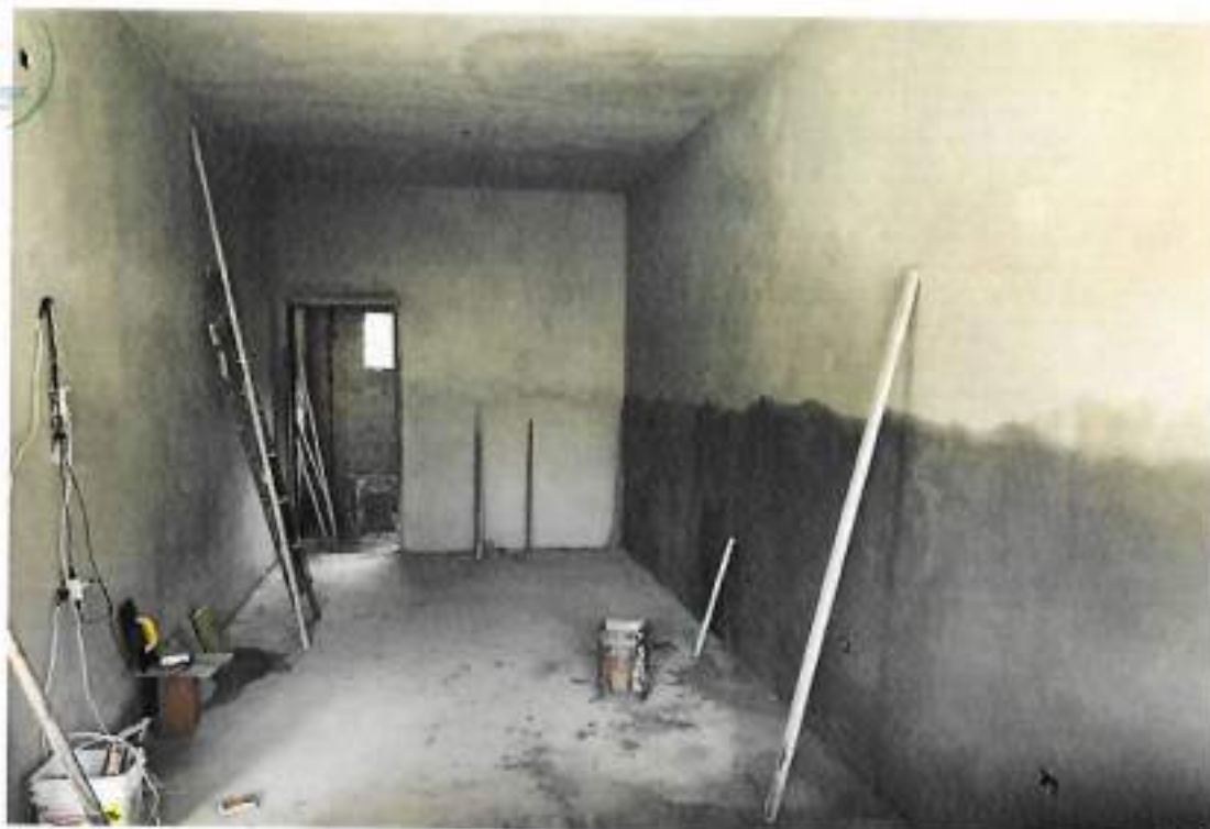
Foto 03 – Aplicação de argamassa em paredes internas – data: 04/08/2022
