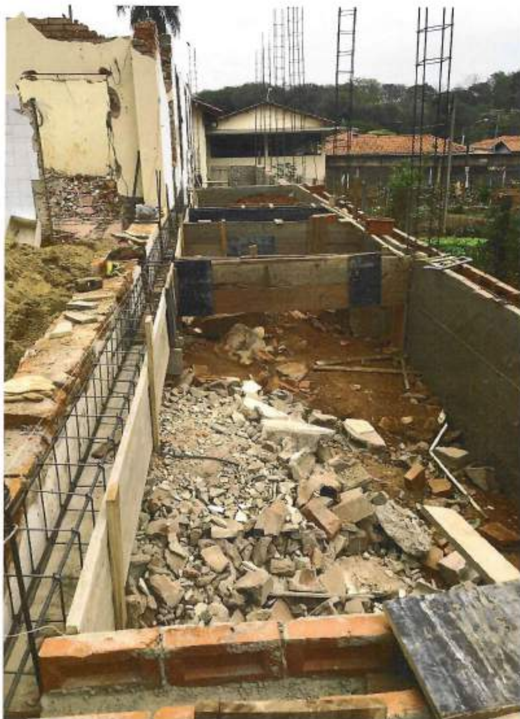
Foto 05 – Montagem e concretagem de vigas e pilares – data: 06/09/2021
