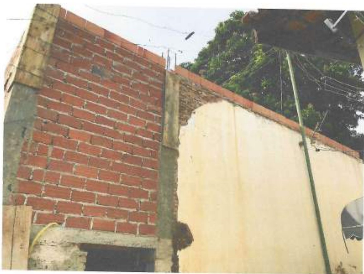
Foto 19 – Alvenaria de vedação e canaletas – data: 30/11/2021
