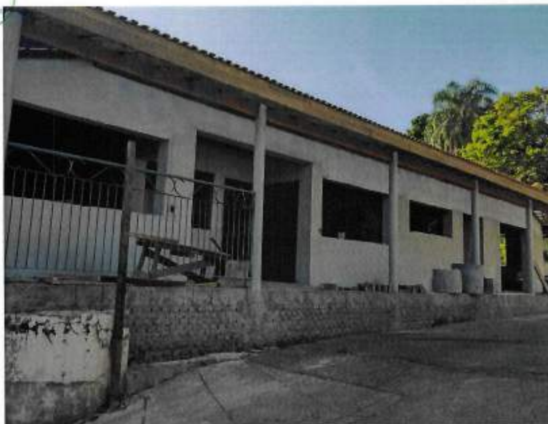
Foto 15 – Aplicação de argamassa em paredes externas – data: 27/07/2022
