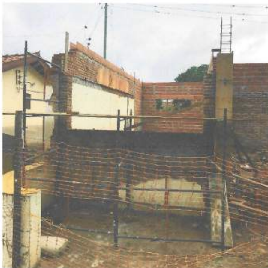
Foto 11 – Alvenaria de vedação e janela frontal – data: 12/12/2021
