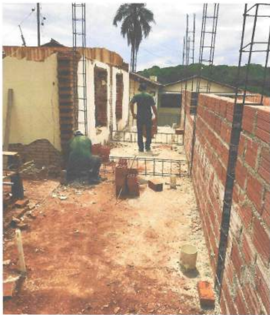
Foto 14 – Armação de viga – data: 25/10/2021
