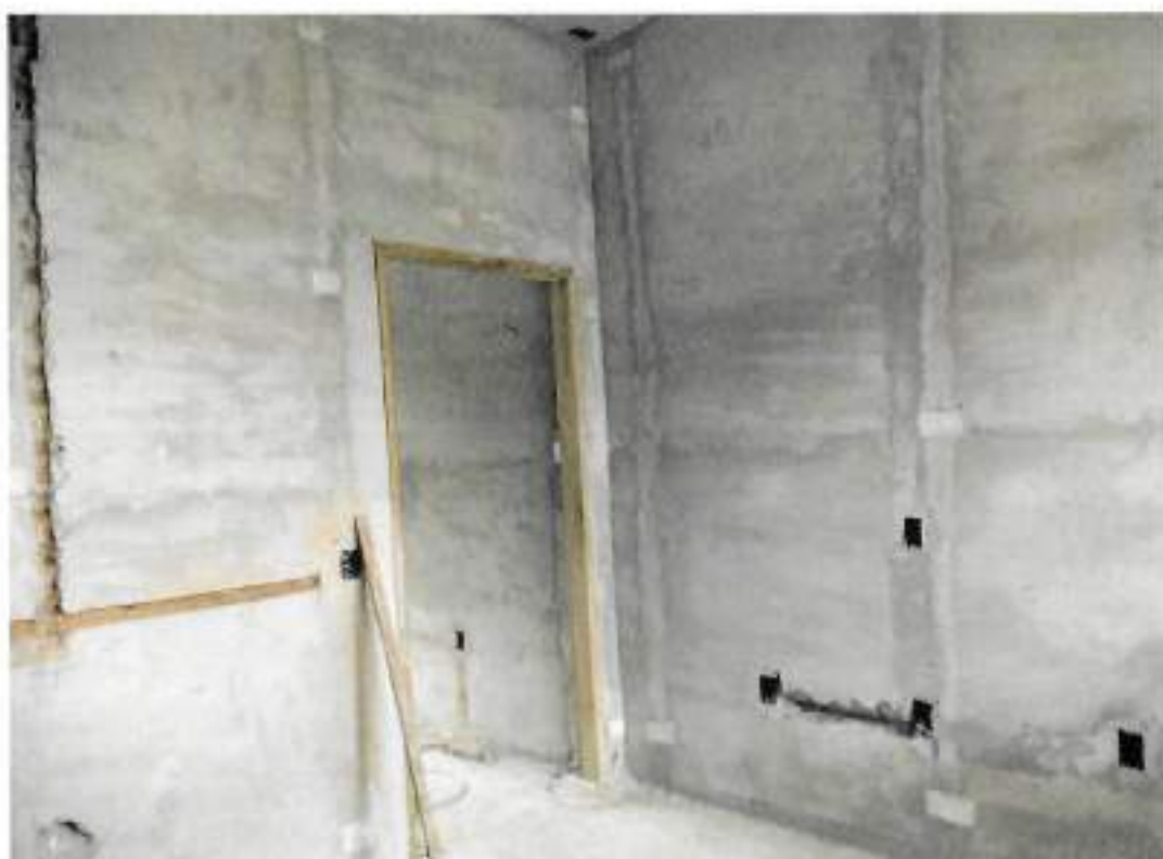
Foto 11 – Emboço para recebimento de cerâmica – data: 21/07/2022
