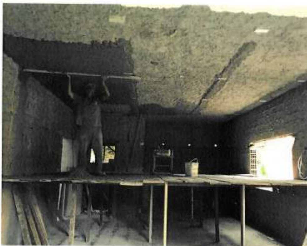
Foto 07 – Aplicação de argamassa em faces internas– data: 16/05/2022
