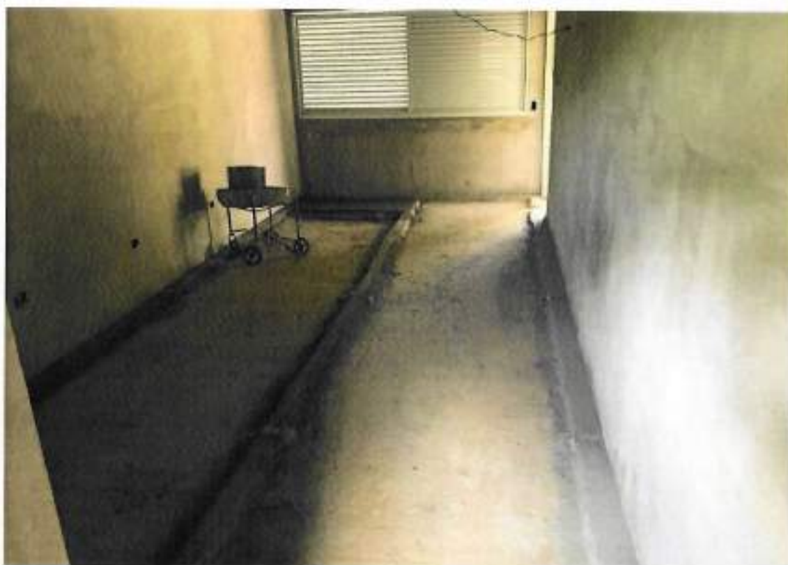
Foto 08 – Aplicação massa de nivelamento para piso cerâmico – data: 13/09/2022
