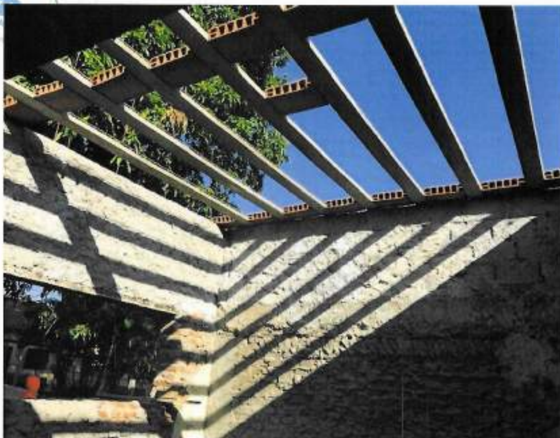
Foto 17 – Montagem da laje pré-moldada de forro – data: 25/02/2022
