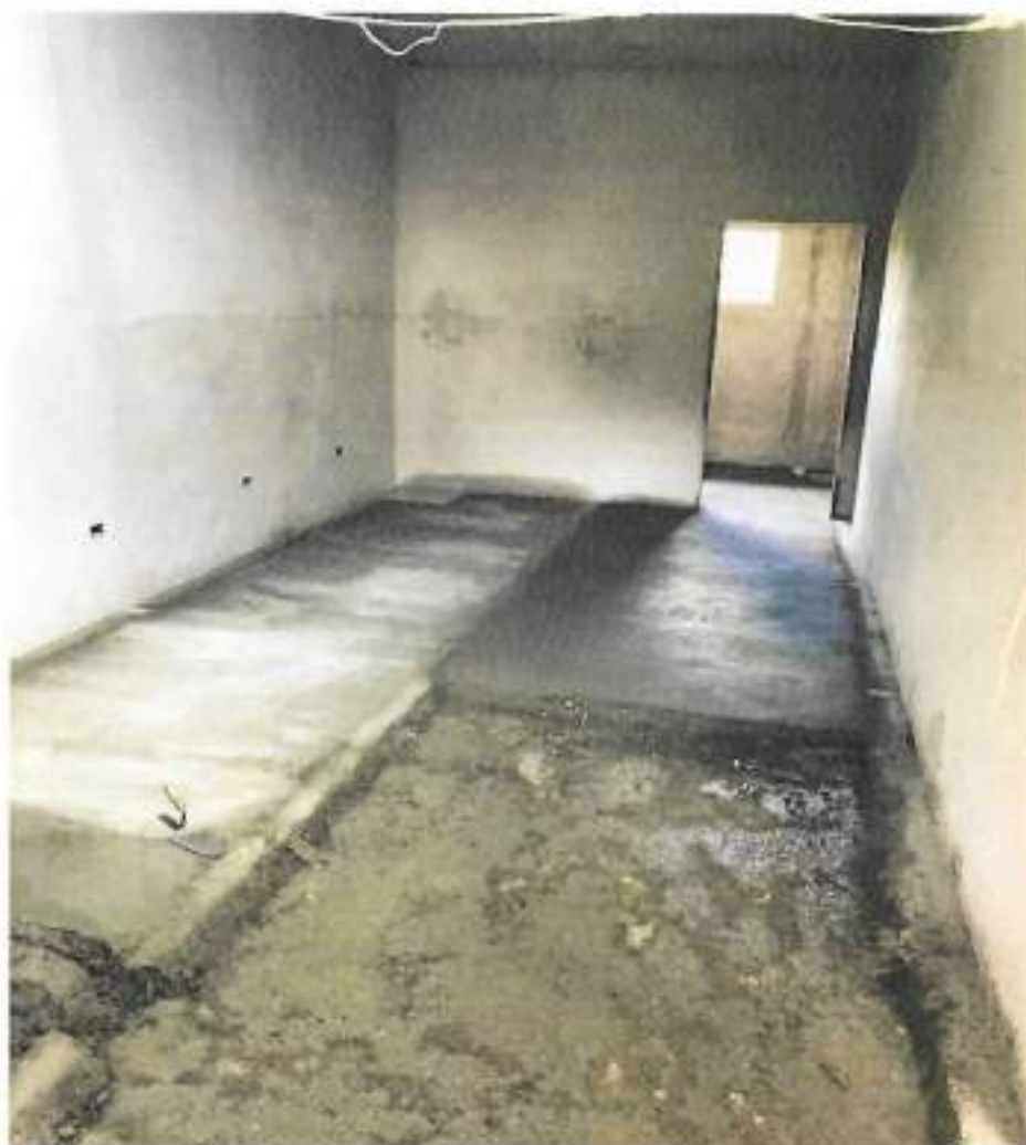
Foto 04 – Aplicação massa de nivelamento para piso cerâmico – data: 06/09/2022
