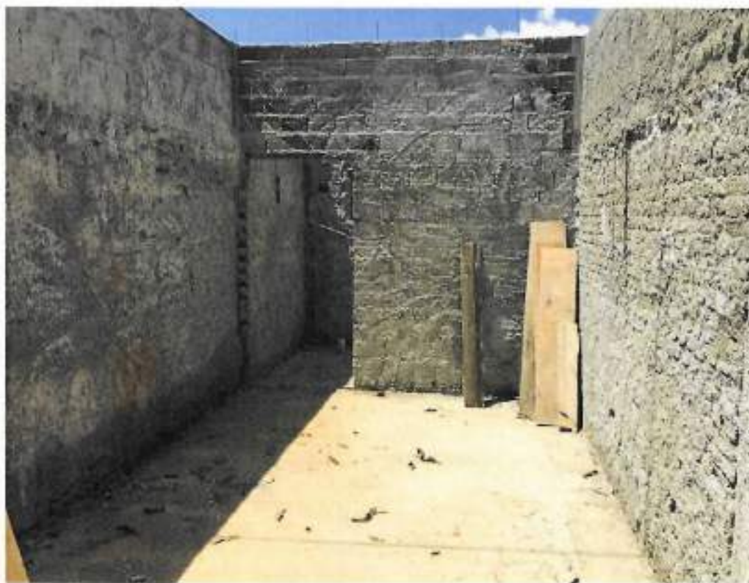
Foto 12 - Chapisco da parede – data: 23/02/2022
