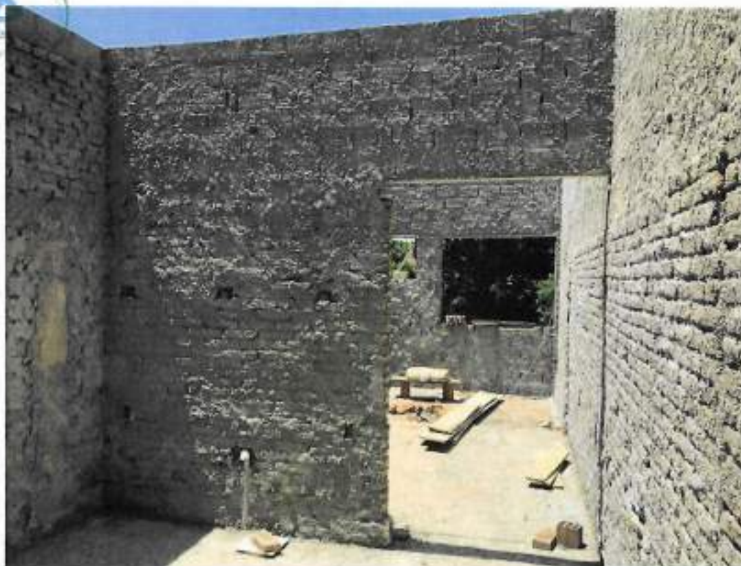
Foto 11 – Chapisco da parede – data: 22/02/2022
