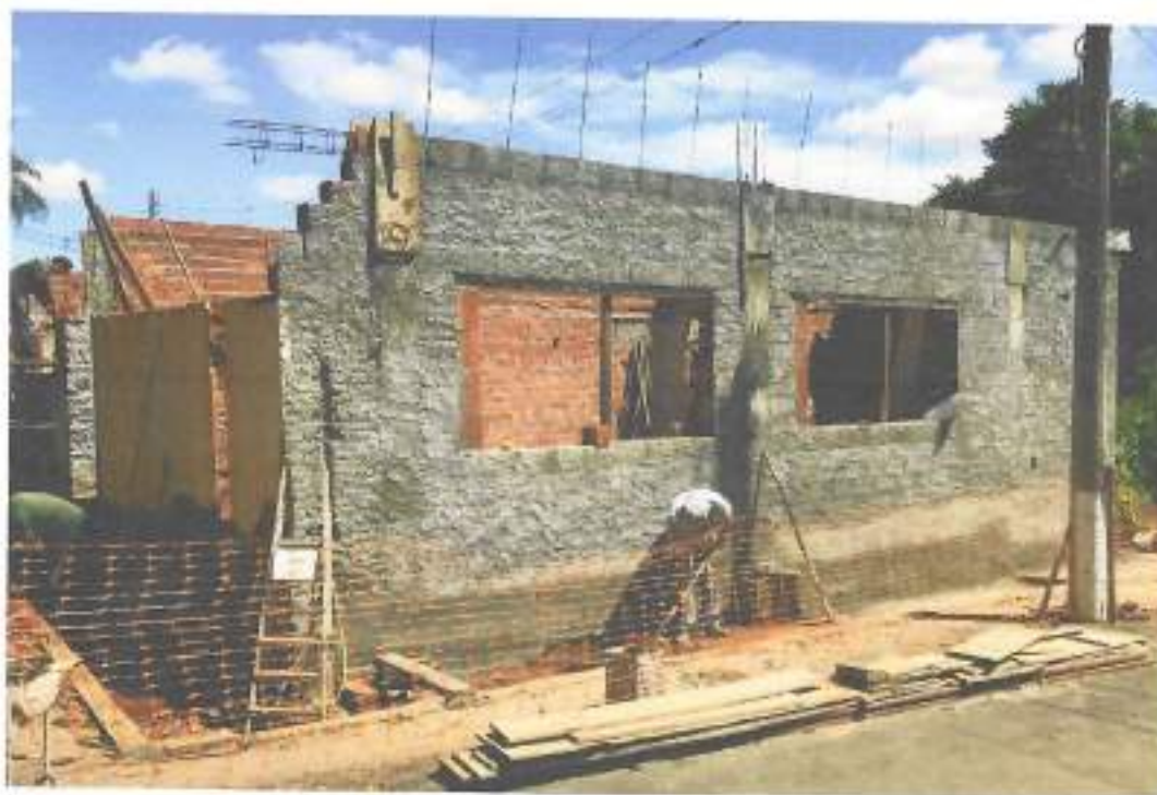
Foto 20 – Alvenaria de vedação, canaleta e chapisco – data: 29/12/2021
