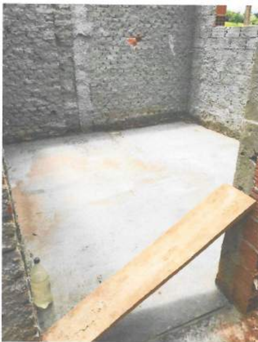
Foto 06 – Chapisco e concretagem do contrapiso – data: 17/01/2022
