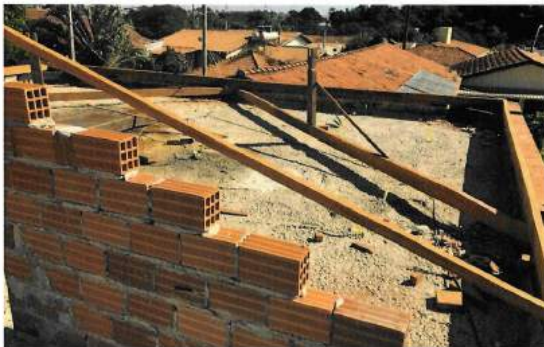
Foto 13 – Fabricação e Instalação de tesouras – data: 22/06/2022
