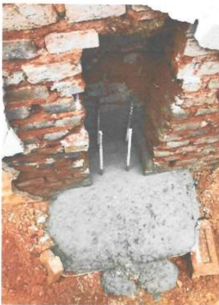
Foto 13 – Alvenaria baldrame de pilar – data: 24/01/2022
