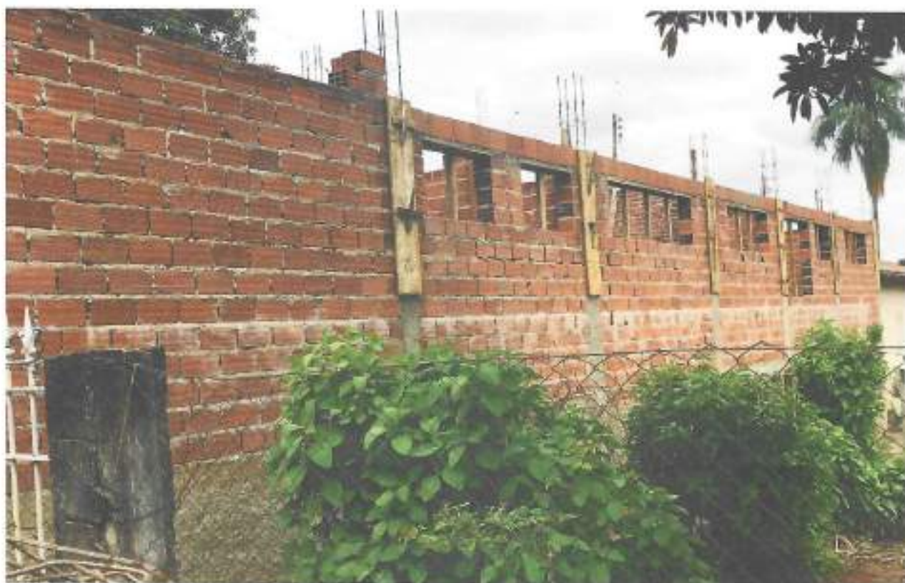
Foto 11 – Alvenaria de vedação e verga moldada de canaletas – data: 22/11/2021
