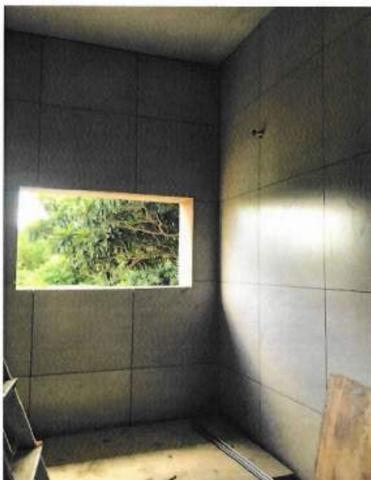
Foto 04 – Revestimento cerâmico para paredes internas – data: 07/10/2022
