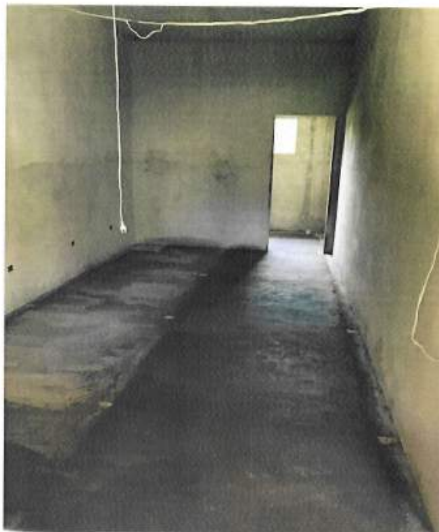
Foto 05 – Aplicação massa de nivelamento para piso cerâmico – data: 09/09/2022
