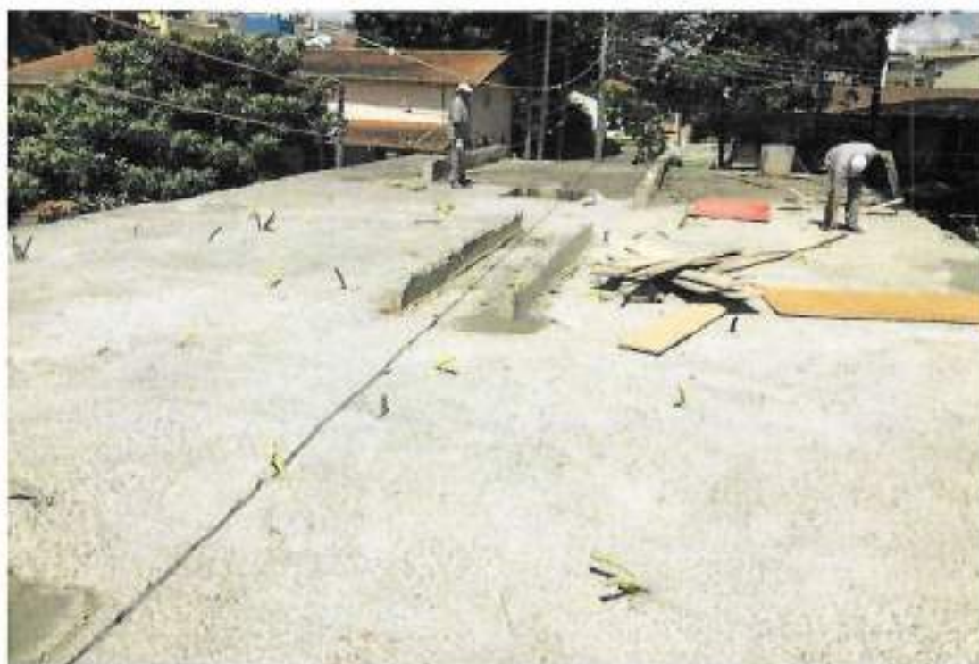
Foto 18 – Desmontagem da caixa da viga – data: 28/02/2022
