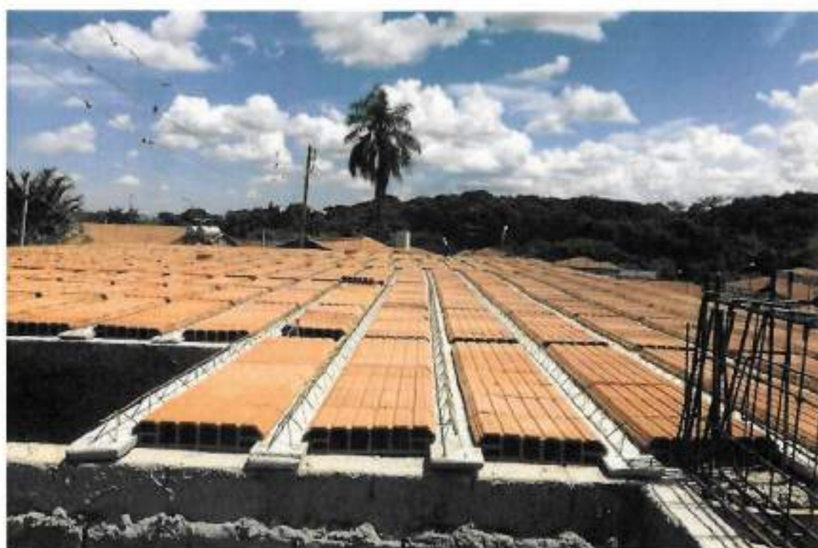
Foto 06 – Vista Externa do Enchimento de laje com cerâmica – data: 07/03/2022
