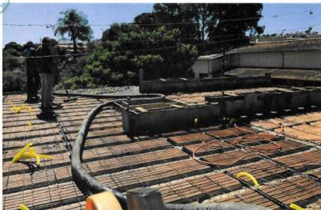
Foto 17 – Concretagem de vigas e laje – data: 23/03/2022
