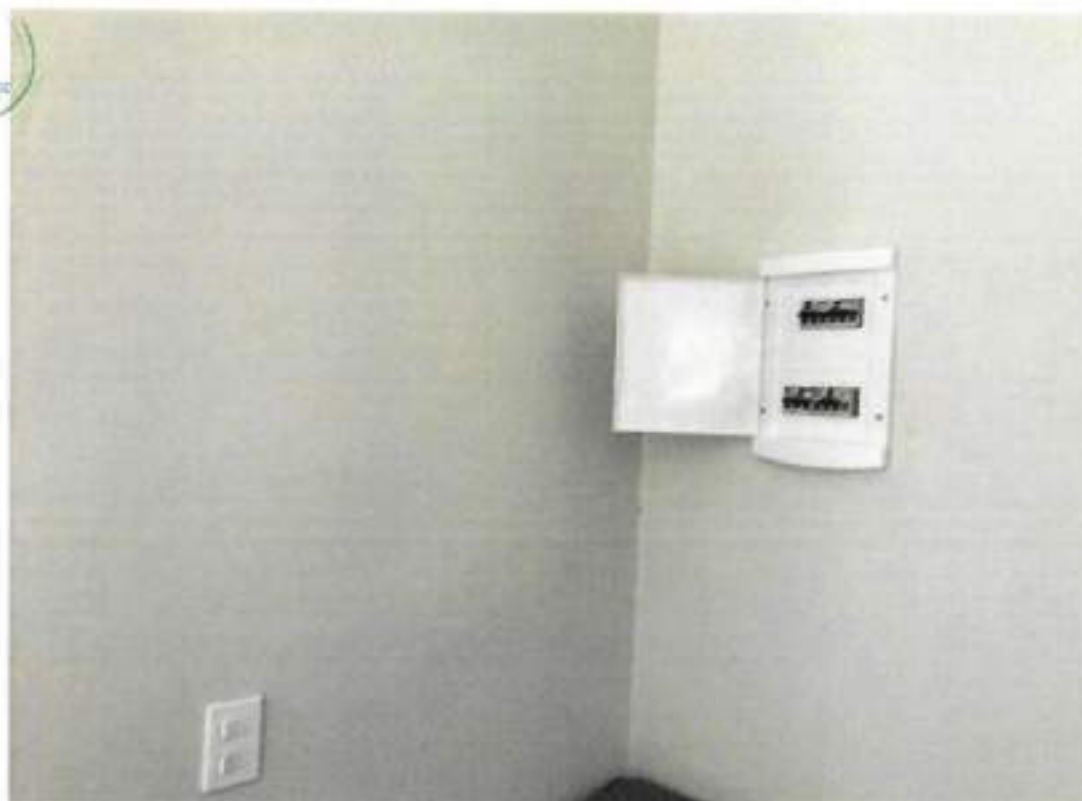
Foto 09 – Montagem quadro de distribuição, disjuntores e interruptores – data: 13/12/2022
