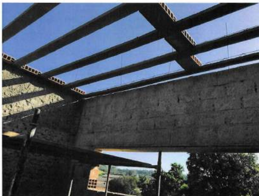
Foto 14 – Montagem da laje pré-moldada de forro – data: 24/02/2022
