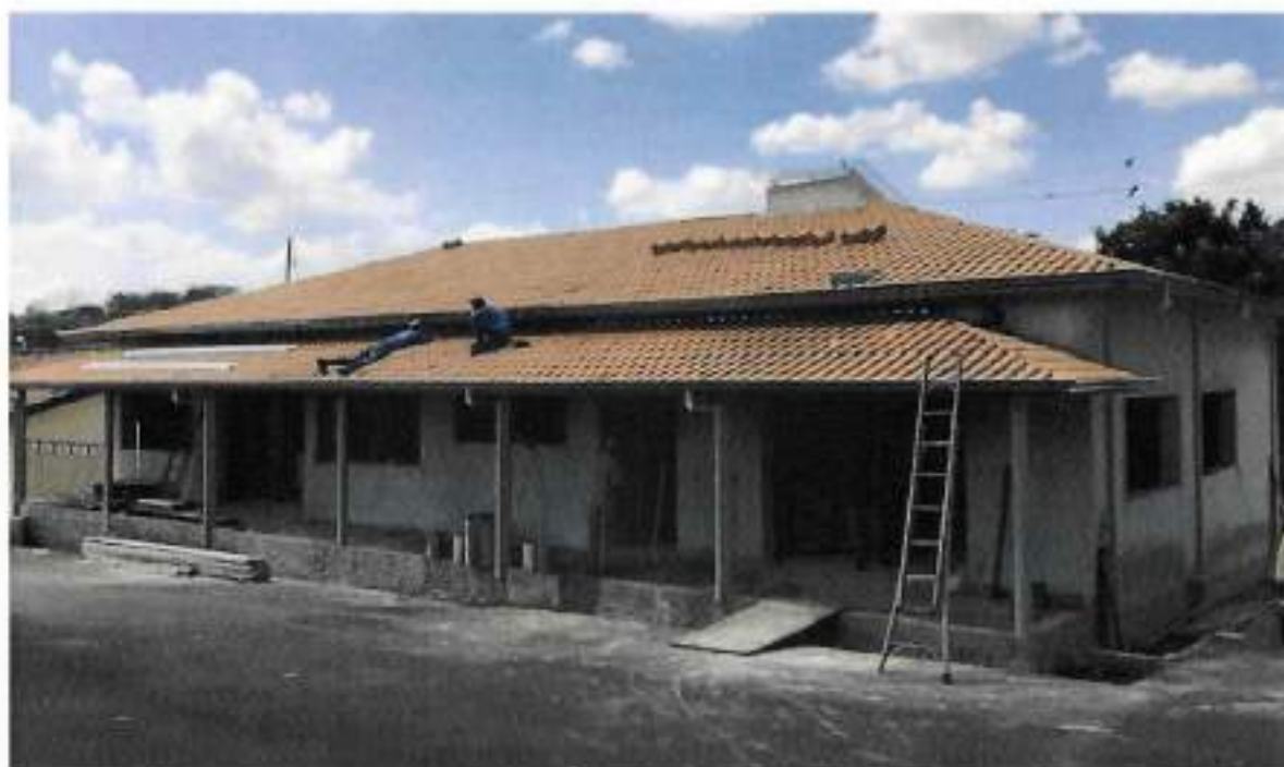
Foto 20 – Colocação de calhas de beiral, bocais e transportes verticais – data: 29/07/2022
