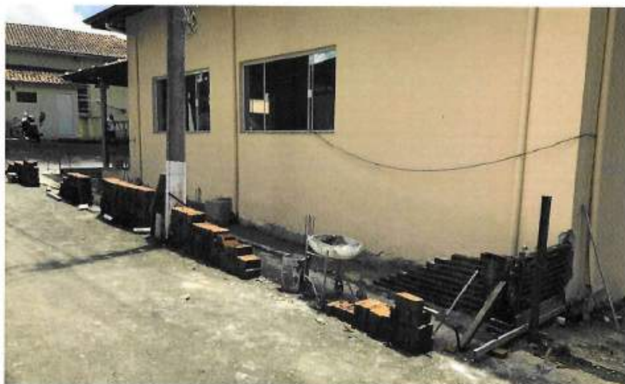
Foto 12 – Construção da floreira lateral do prédio – data: 16/11/2022
