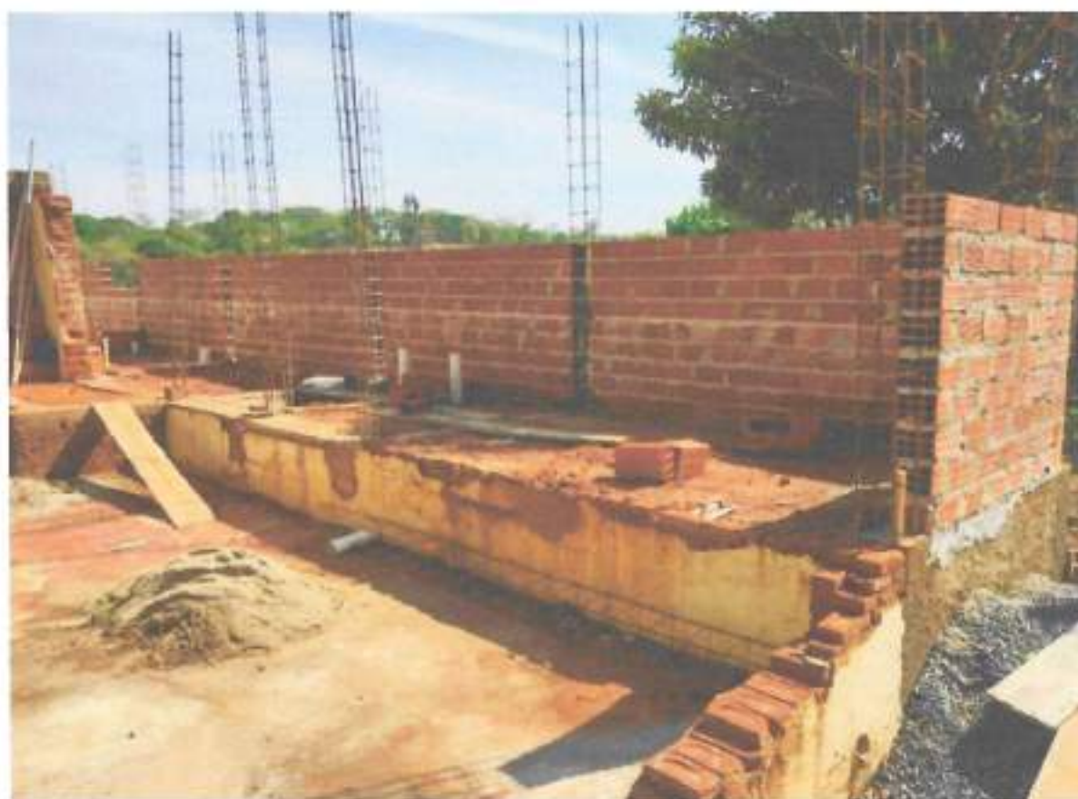
Foto 12 – Alvenaria de vedação de blocos furados – data: 22/10/2021
