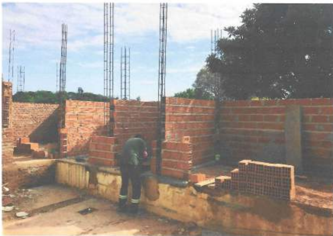
Foto 17 – Alvenaria de vedação de blocos furados – data: 29/10/2021
