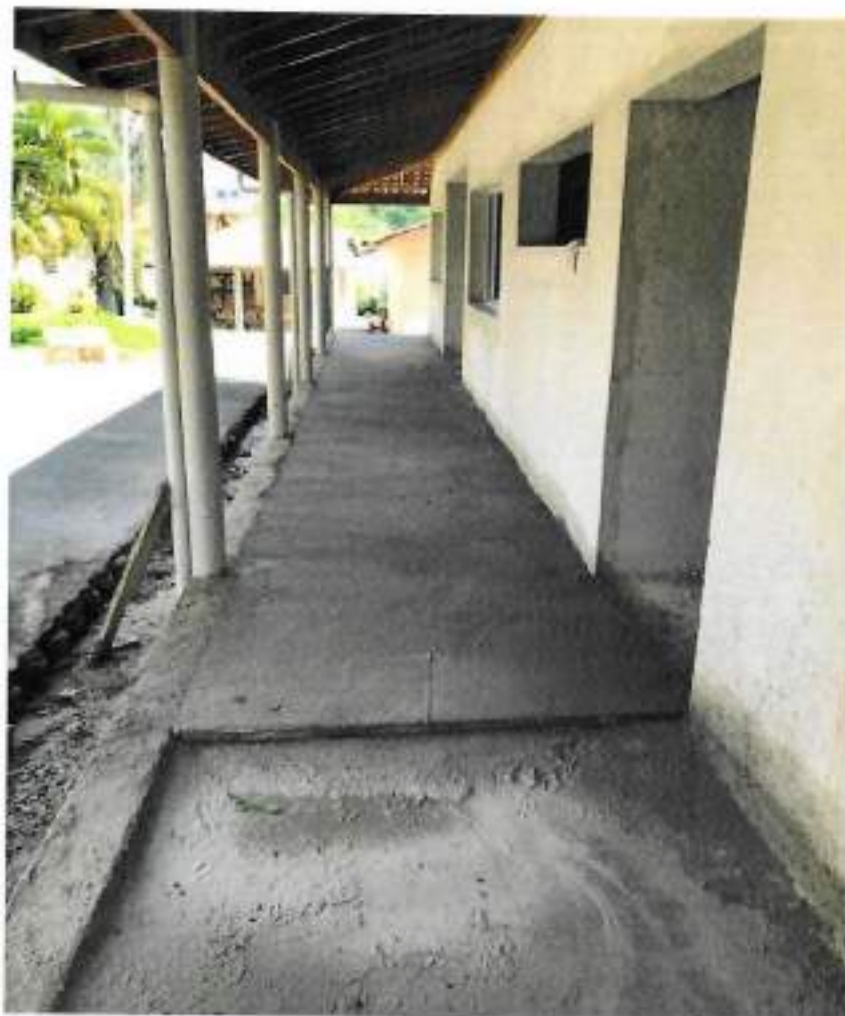
Foto 17 – Aplicação massa de nivelamento para piso cerâmico – data: 30/08/2022
