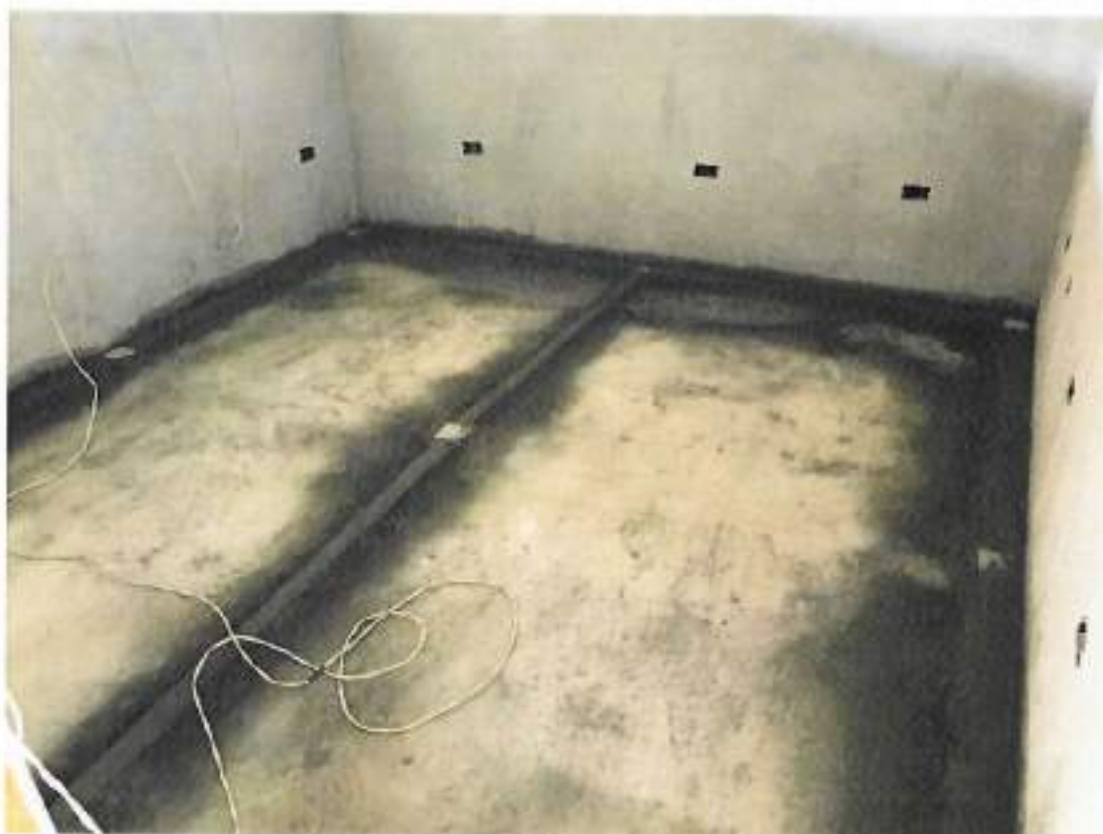
Foto 16 – Aplicação massa de nivelamento para piso cerâmico – data: 22/09/2022
