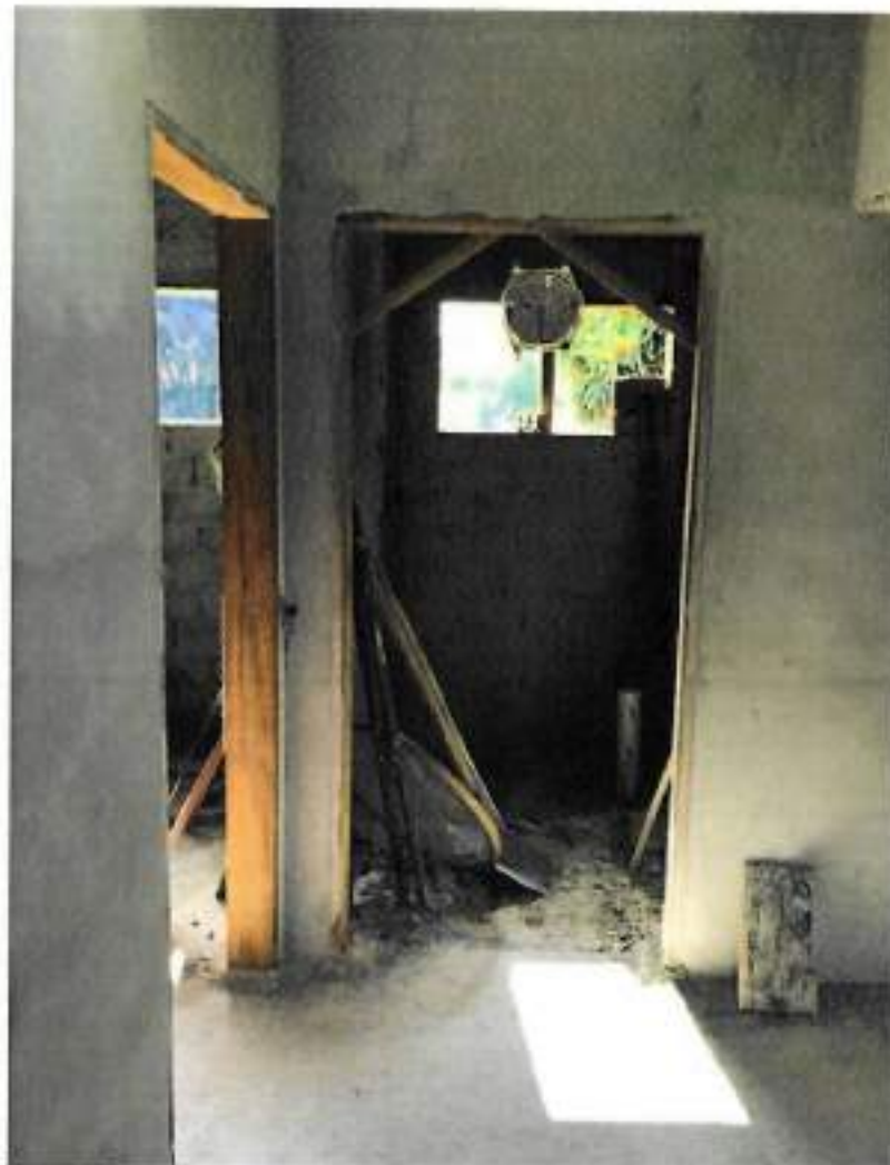
Foto 05 – Colocação de batente de porta e aplicação de argamassa – data: 09/05/2022
