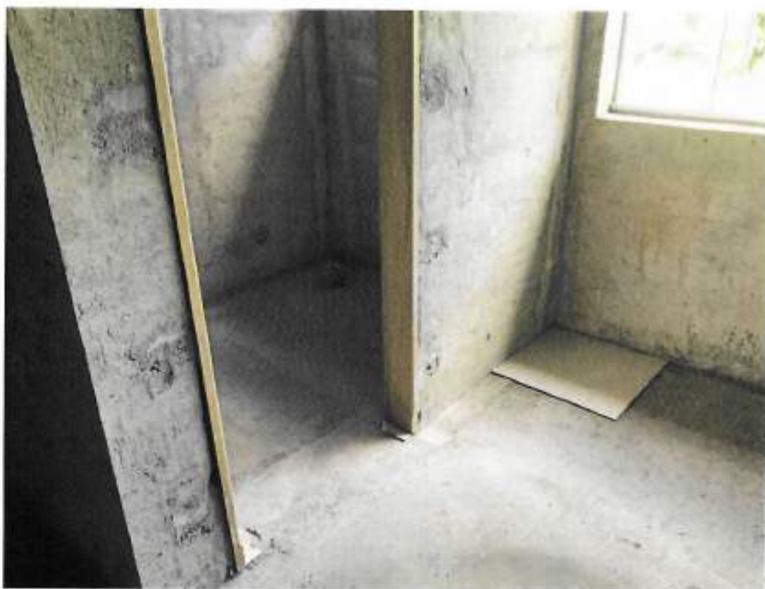
Foto 14 – Aplicação massa de nivelamento para piso cerâmico – data: 19/09/2022
