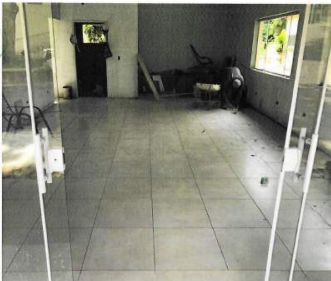
Foto 03 – Revestimento cerâmico para pisos e rodapé – data: 04/11/2022
