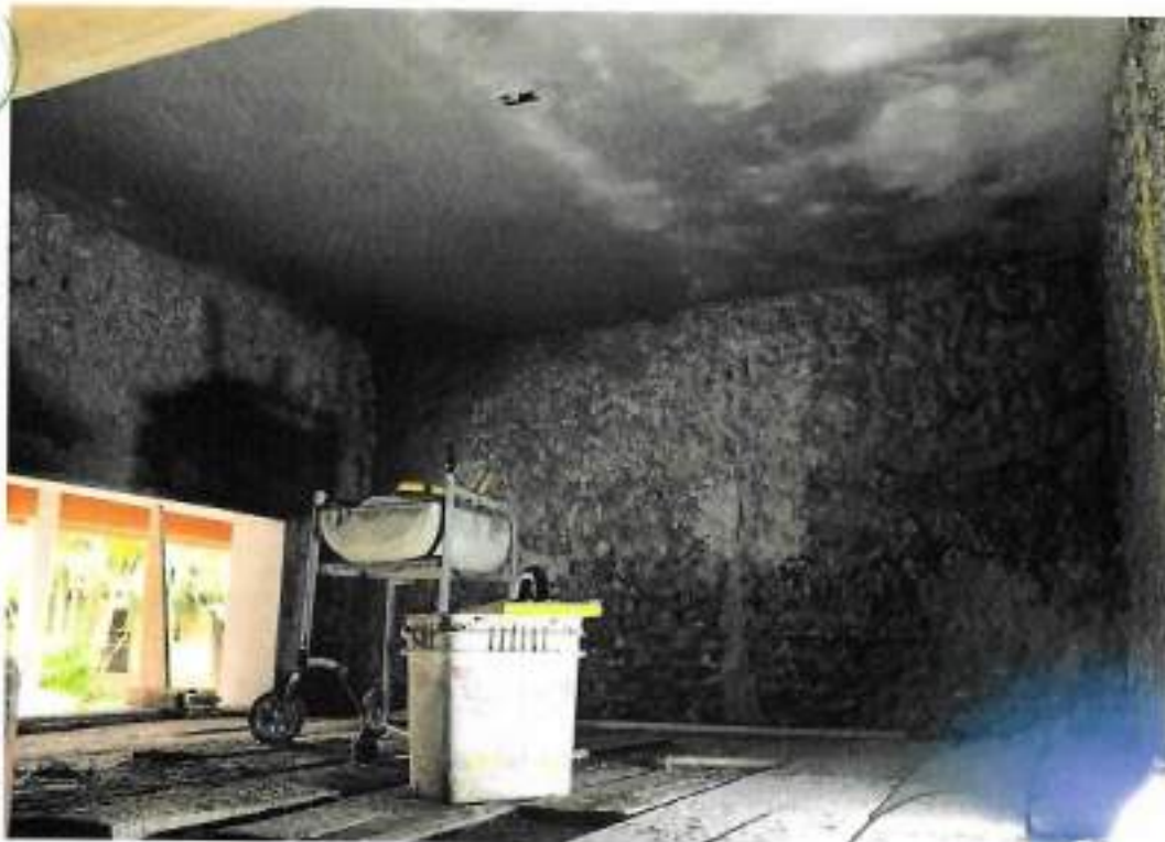
Foto 07 – Aplicação de argamassa em paredes internas – data: 11/08/2022
