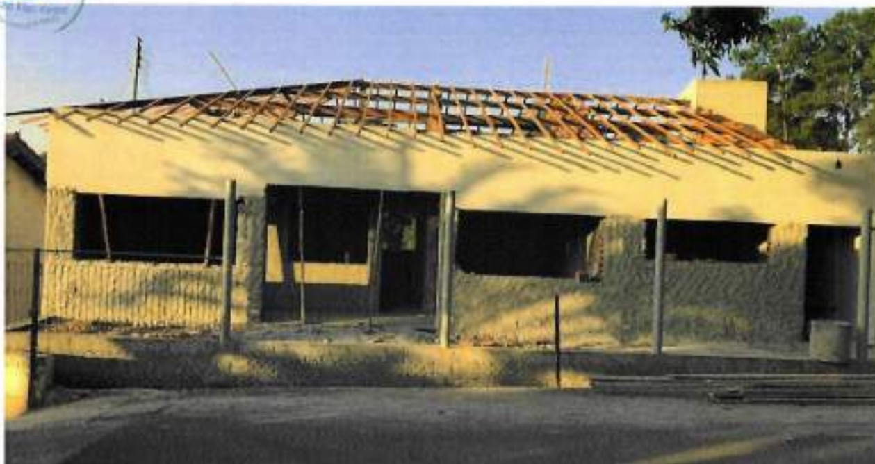
Foto 19 – Fabricação e Instalação de tesouras e caibros – data: 30/06/2022
