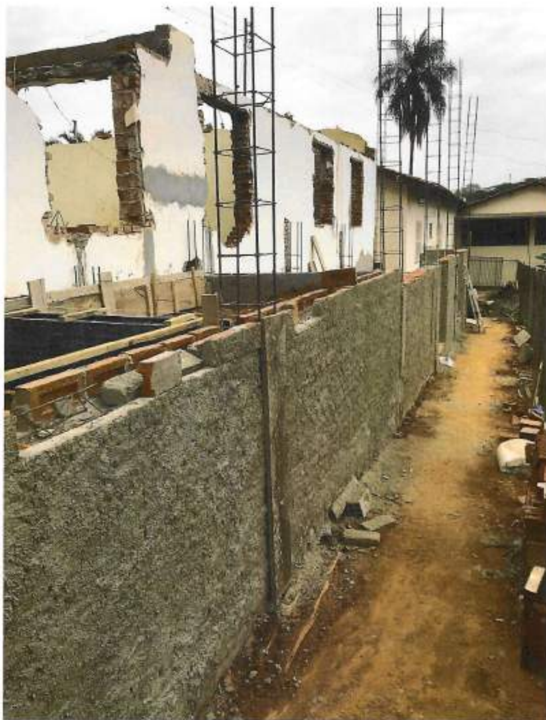
Foto 07 – Chapisco externo da parede externa lateral – data: 10/09/2021
