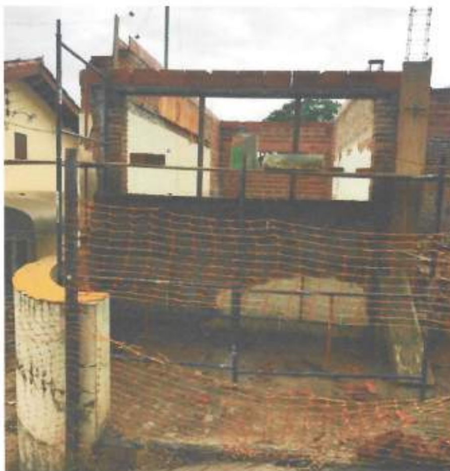
Foto 12 – Alvenaria de vedação e janela frontal – data: 14/12/2021
