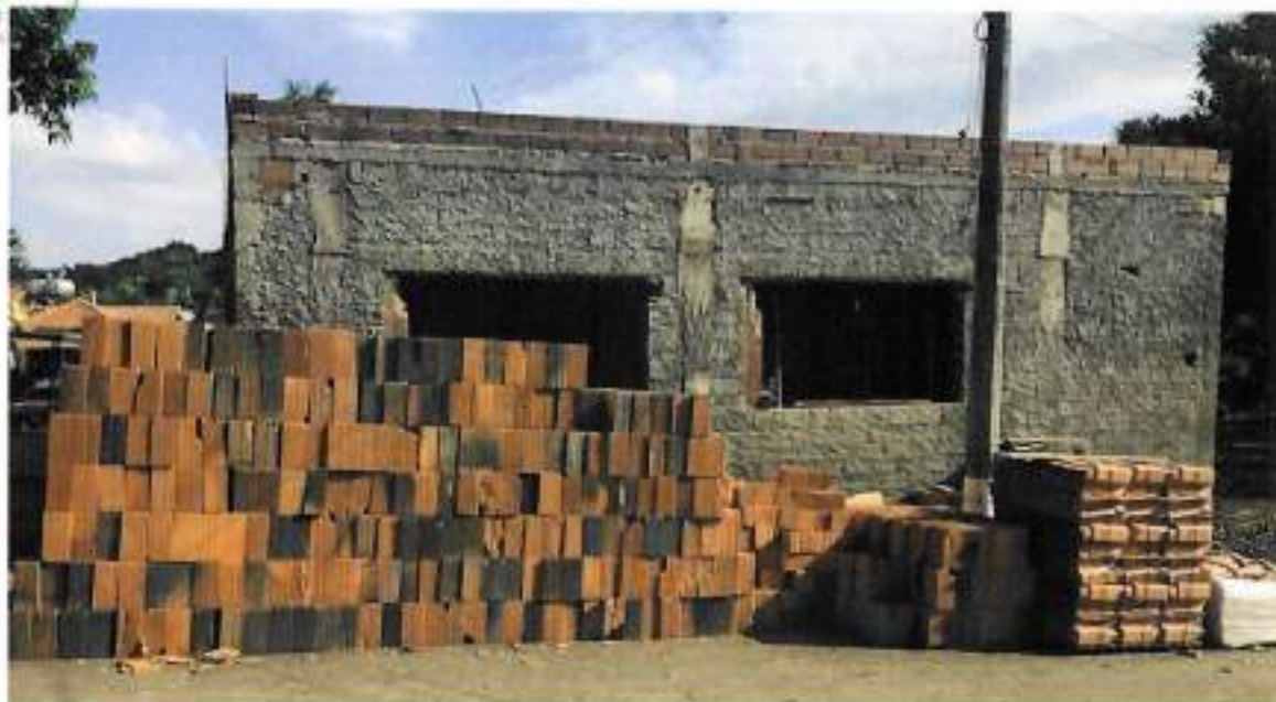
Foto 03 – Alvenaria de blocos furados – data: 05/04/2022
